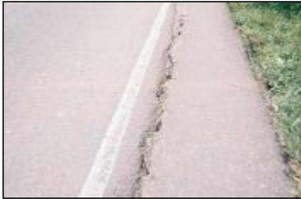
*Imagen N° 22: Separación entre Berma y Pavimento.*
