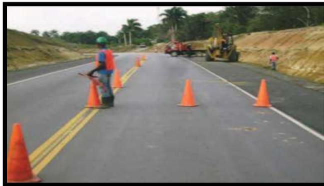
*Imagen N° 26: Nivelación de bermas con material granular.*
