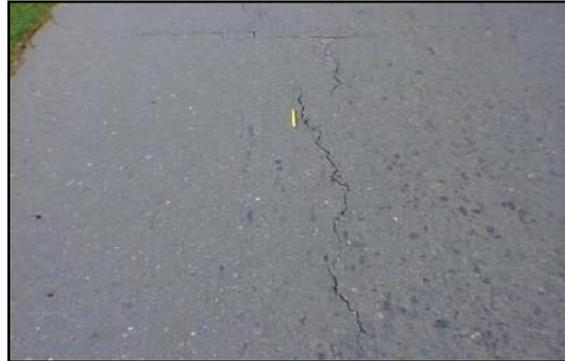
*Imagen N° 10: Fisuras y Grietas Longitudinales y Transversales.*
