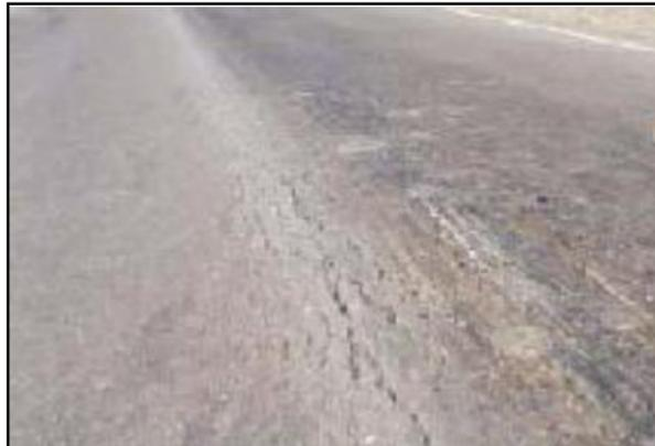
*Imagen N° 15: Deformación Transversal.*
