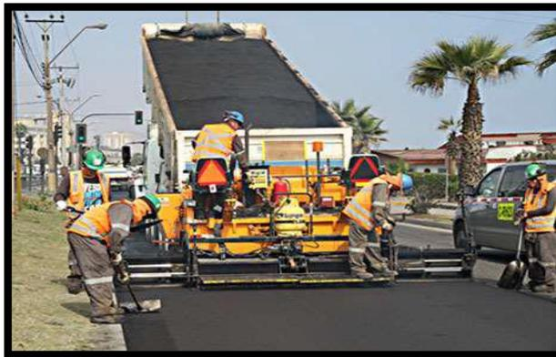
*Imagen N° 28: Recapados Asfálticos.*
