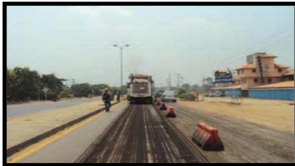
*Imagen N° 30: Microfresado de Carpeta Asfáltica.*
