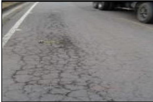
*Imagen N° 07: Fisuras y Grietas por Fatigamiento.*
