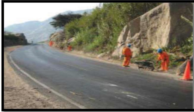
*Imagen N° 25: Bacheo de bermas con material granular.*
