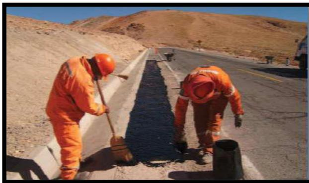
*Imagen N° 31: Nivelación de bermas con mezcla bituminosa.*
