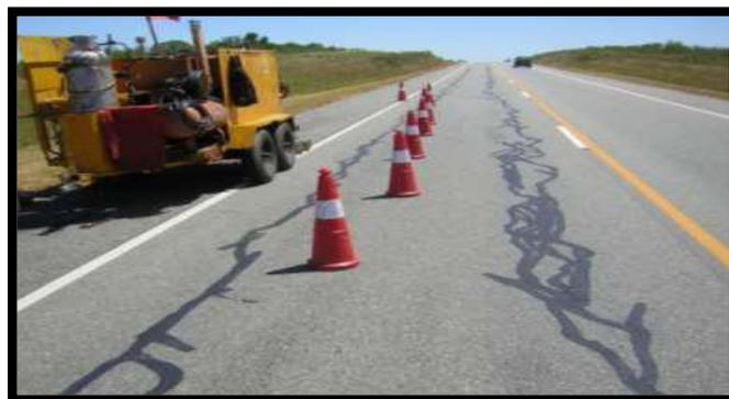
*Imagen N° 23: Sellado de Fisuras y Grietas.*
