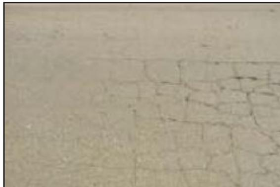
*Imagen N° 08: Fisuras y Grietas pro Bloque.*
