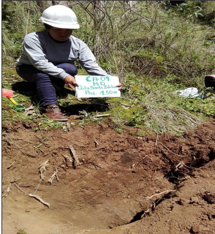
Fotografía 9. Excavación de la Calicata N°1.
