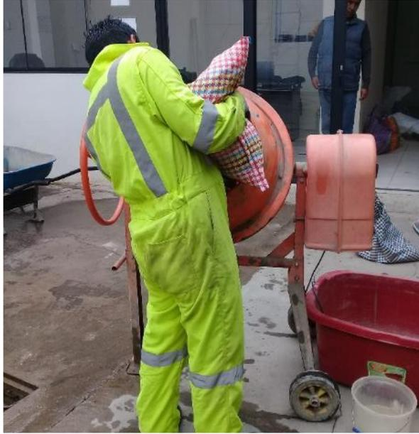
**IMAGEN 3:** ELABORACION DEL CONCRETO SIN ADITIVO. En la imagen se observa el vertimiento de los materiales dentro del trompito.
