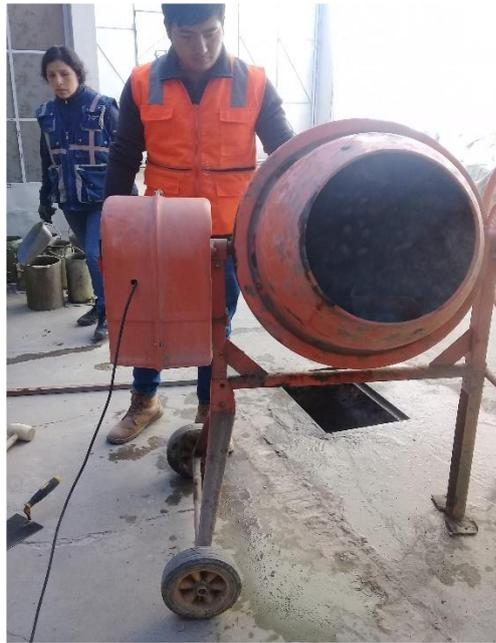
**IMAGEN 28:** ELABORACION DEL CONCRETO CON ADITIVO. En la imagen se observa la verificación de los equipos para la elaboración del concreto con aditivo.
