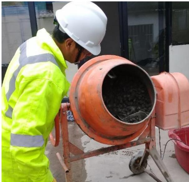
**IMAGEN 4:** ELABORACION DEL CONCRETO SIN ADITIVO. En la imagen se observa el mezclado de los materiales dentro del trompito.
