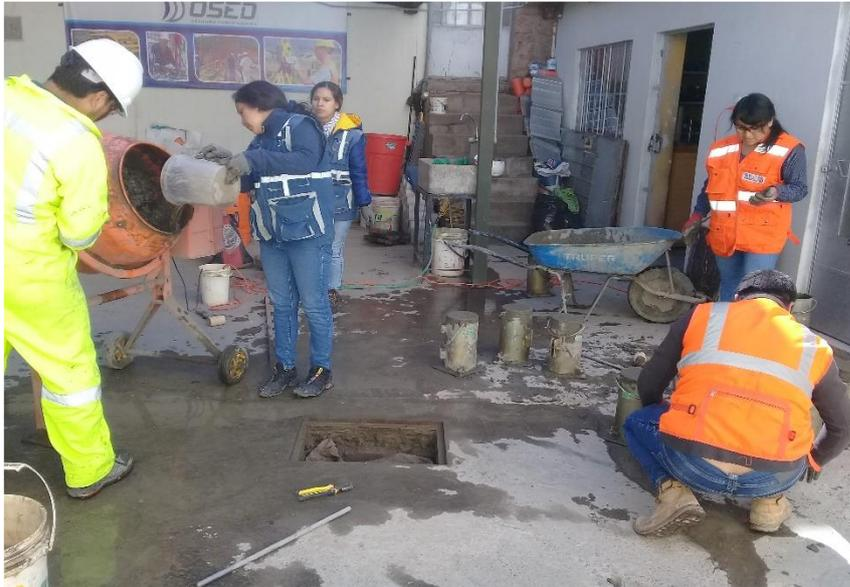
**IMAGEN 30:** ELABORACION DEL CONCRETO CON ADITIVO. En la imagen se observa el vertimiento de los materiales dentro del trompito.
