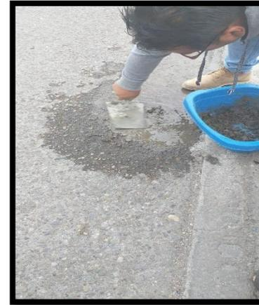
Sellado de orificio de la extracción de la diamantina.
