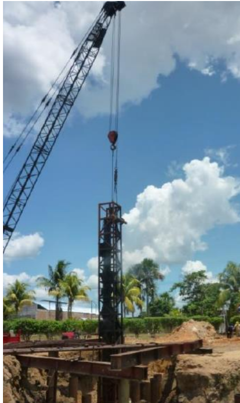
Figura 17: Montaje de Pilote
