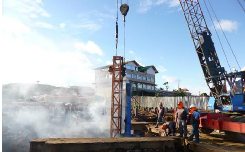
Figura 18: Hincado de Pilotes
