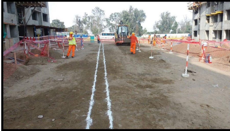
Figura 1: Verificación Control topográfico del tramo 03 -04
