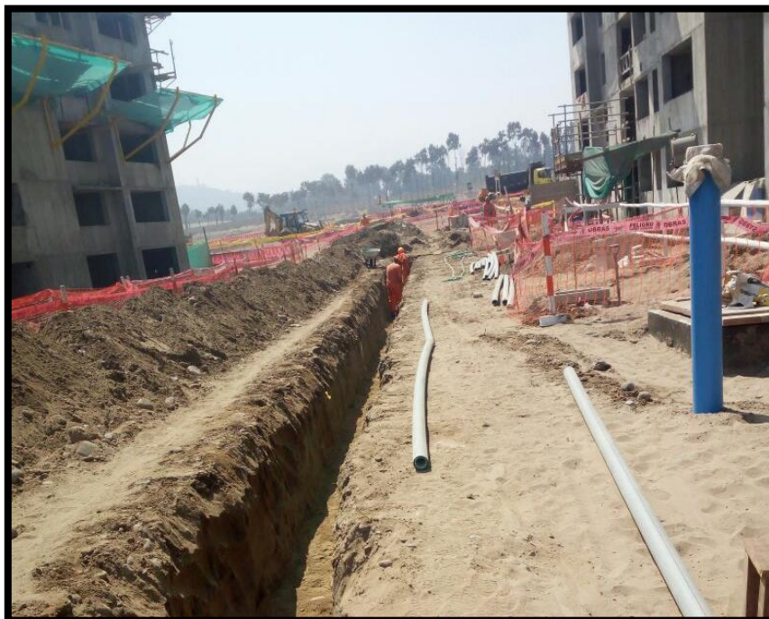
Figura 2: Verificación excavación de zanja
