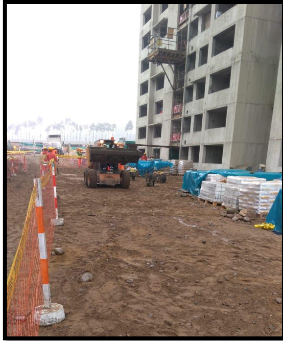
Figura 9: Control del compactado de zanja
