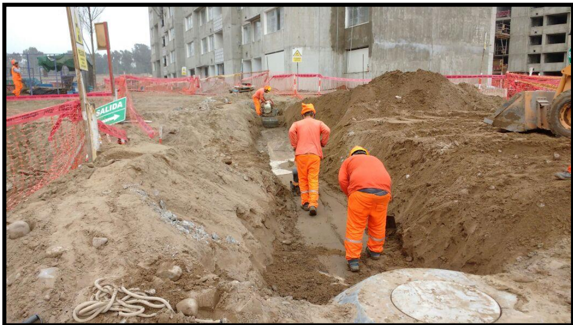
Figura 8: Relleno de zanja de 03 capas c/u 0.30 cm
