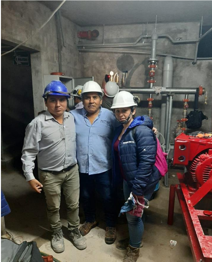
Fotografía 3. Ingeniero responsable de las instalaciones sanitarias e hidráulicas del edificio "Murales Azcona".
