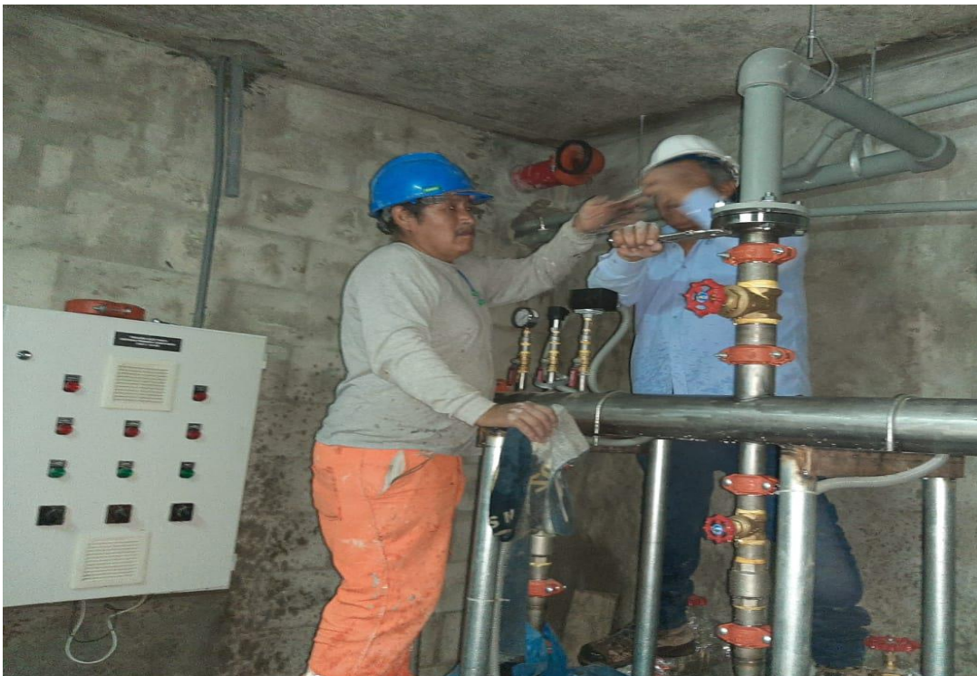
Fotografía 2. Instalación de accesorios del sistema de bombeo.
