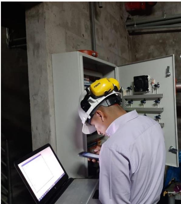
Fotografía 4. Encargo de la programación del PCL para el control de la prueba hidráulica.
