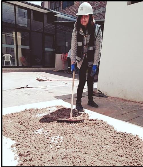
*Figura 3. Secado de agregado fino.*
