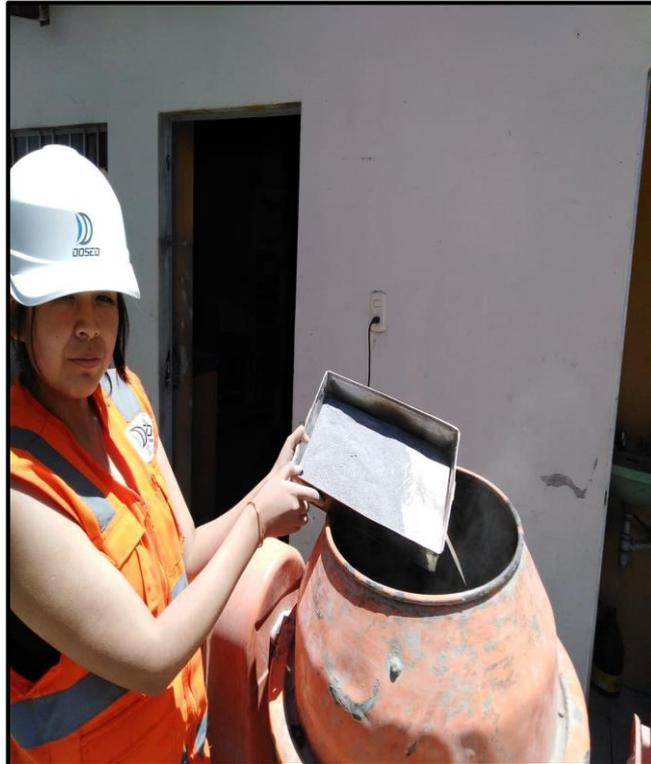
Figura 30. Echando relave y cemento a la mezcladora.
