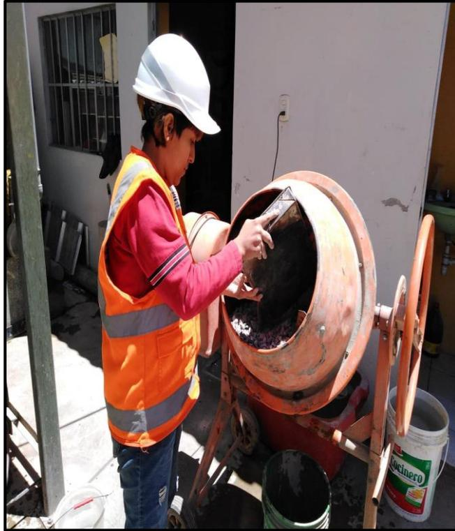
*Figura 28 Echando agregados a la mezcladora
