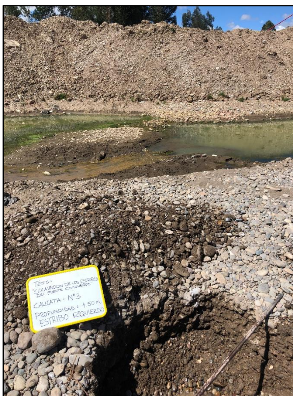
Imagen 16.- Extracción de material de la calicata N°3.
