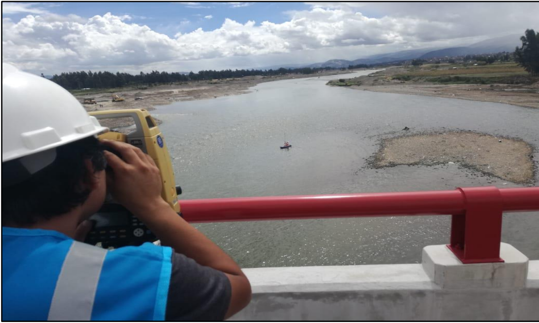
Imagen 5.- Punto de Instalación de la estación total para el levantamiento topográfico – batimetría de la secciones transversales aguas arriba.
