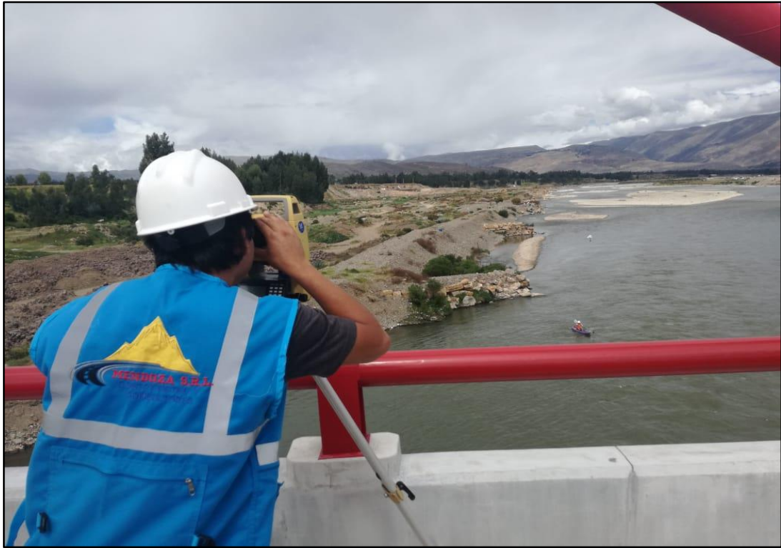
Imagen 7.- Toma Secciones Transversales Aguas Abajo.
