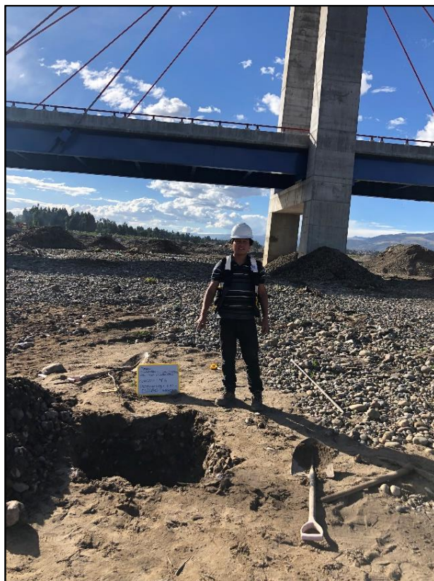
Ilustración 28.- Extracción de material de las calicatas.
