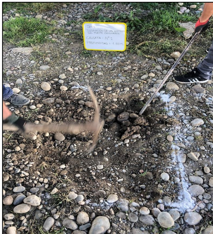
Ilustración 26.- Extracción de la muestra Calicata
