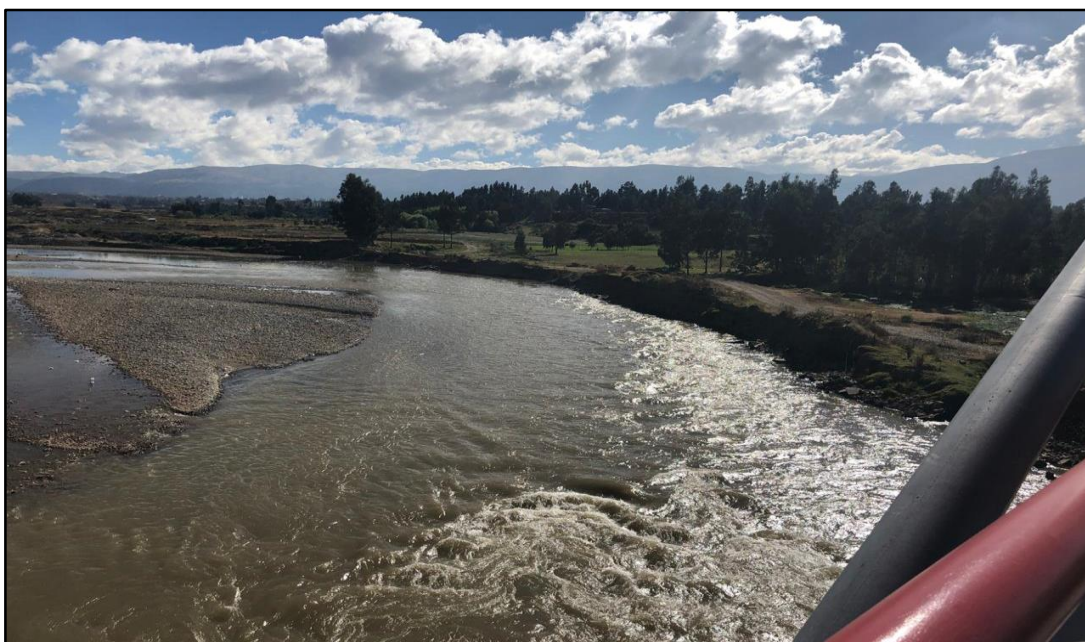
Imagen 35.- Vista panorámica de las secciones transversales aguas arriba del Puente Comuneros.
