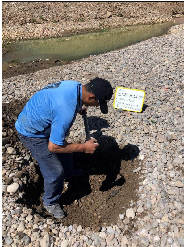
Imagen 14.- Extracción de material de la calicata N°2.
