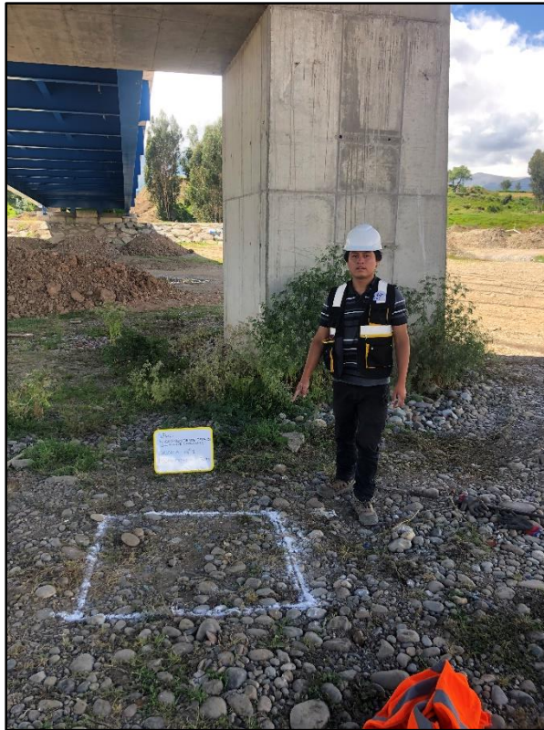
Imagen 11.- Extracción de material de la calicata N°1
