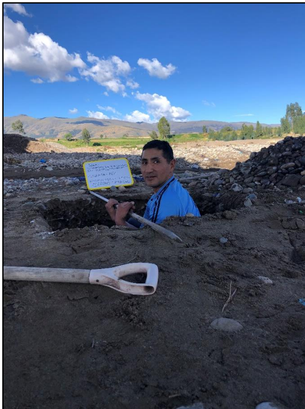
Imagen 18.- Extracción de material de la calicata N°4.
