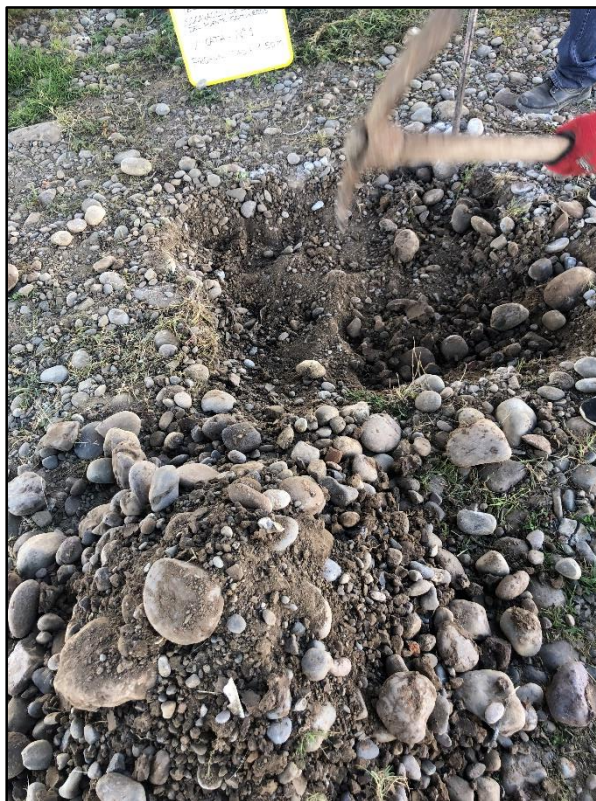
Imagen 12.- Extracción de material de la calicata N°1
