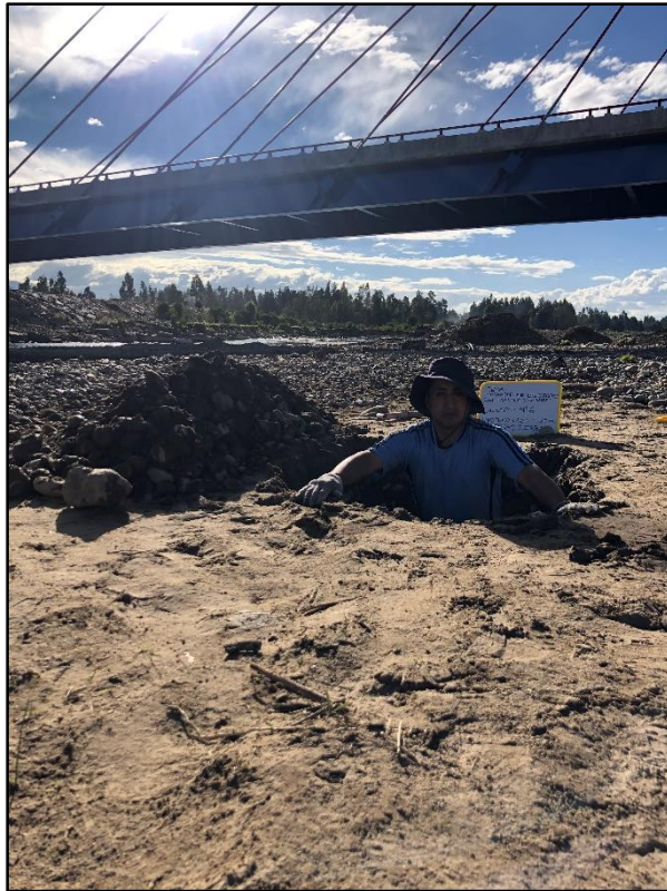
Imagen 22.- Extracción de material de la calicata N°6.
