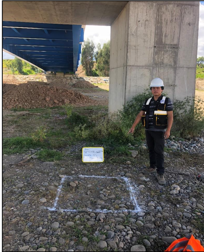
Ilustración 25.- Extracción de la muestra Calicata
