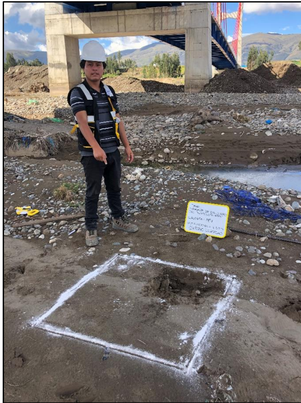
Imagen 17.- Extracción de material de la calicata N°4.
