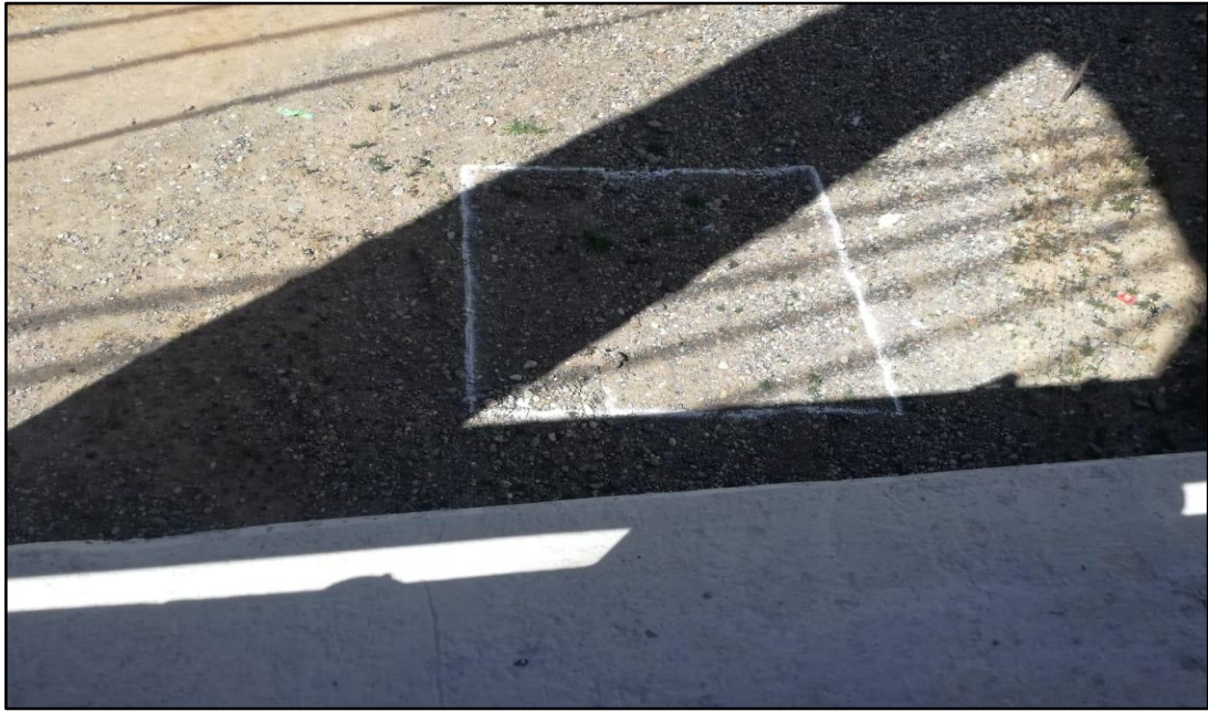
Imagen 9.- Demarcación de zona para la extracción de la calicata en el lecho del río.
