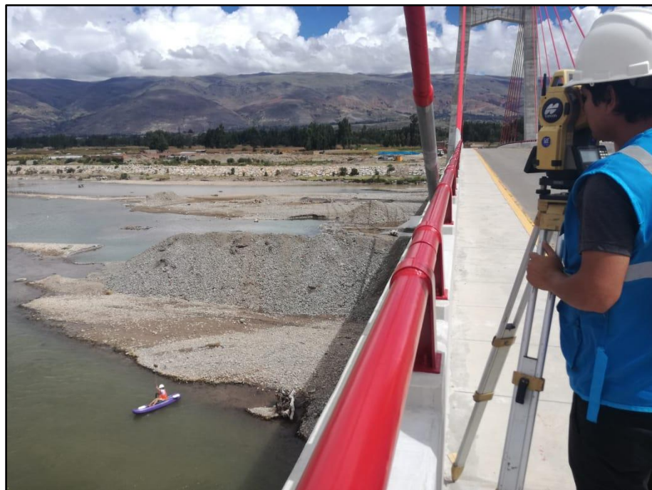
Ilustración 19.- Toma de puntos para la secciones transversales aguas abajo.
