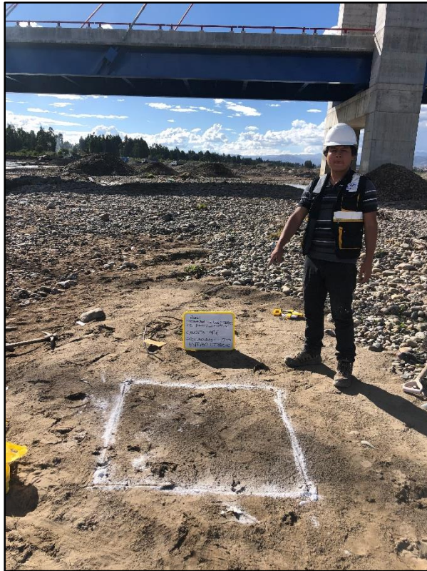
Imagen 21.- Extracción de material de la calicata N°6.
