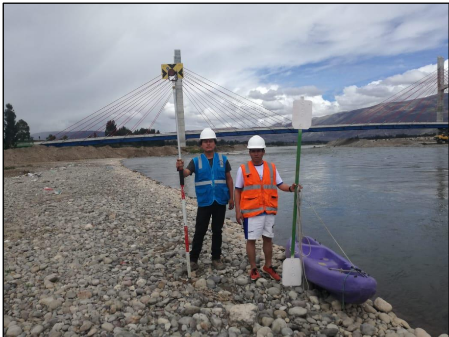
Ilustración 21.- Toma de la Secciones Transversales.
