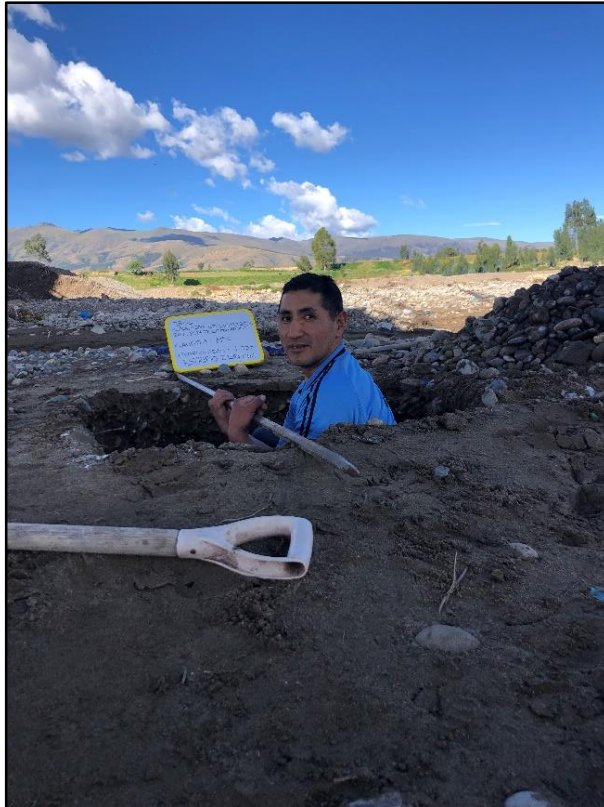
Ilustración 27.-Extracción de Muestras de las calicatas.
