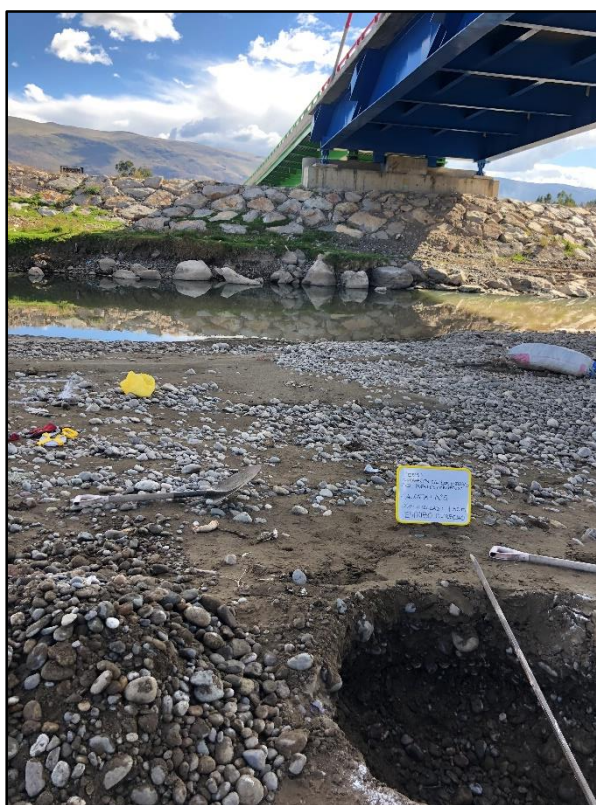
Imagen 20.- Extracción de material de la calicata N°5.
