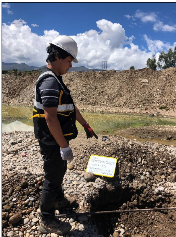
Imagen 15.- Extracción de material de la calicata N°3.
