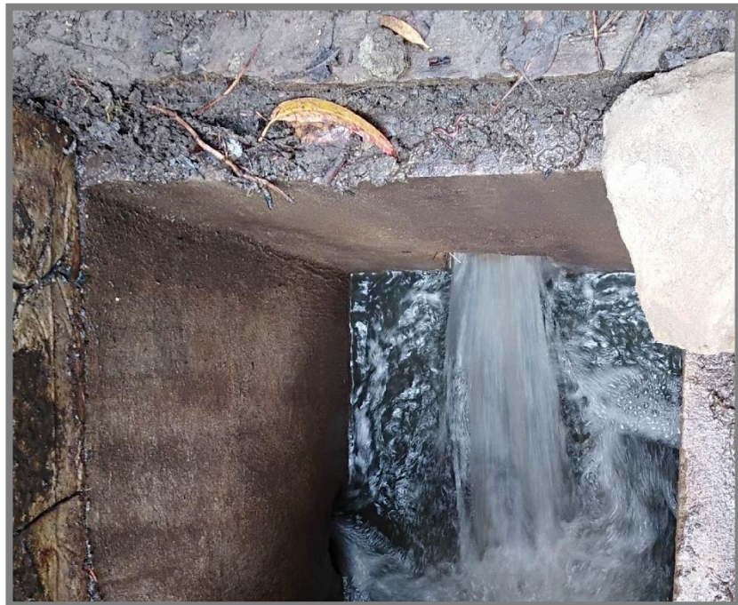
FIGURA N° 2 – 01 EFLUENTE DEL PTAR
