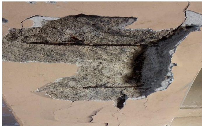
Figura 74: estado de conservación de la vivienda
