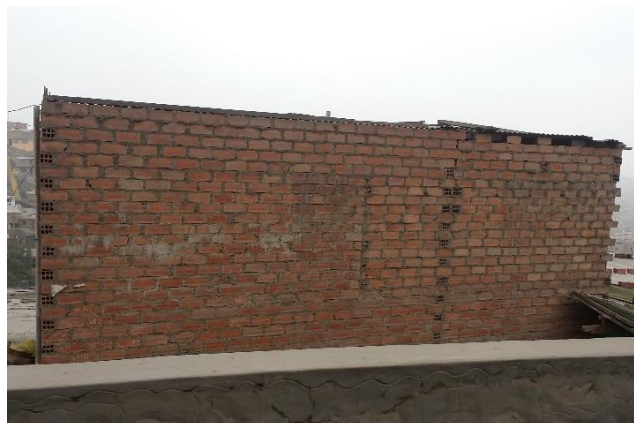
Figura 66: Viviendas sin Columnas
