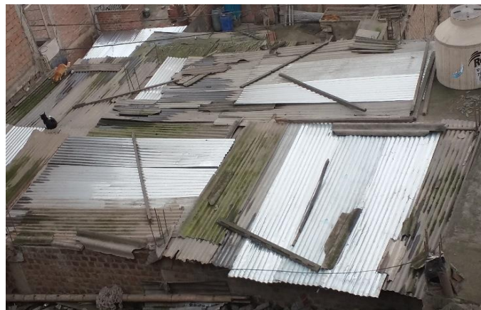
Figura 70: Viviendas Construida con techo predominante
