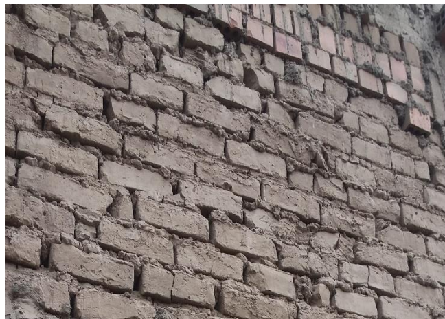
Figura 51: Vivienda de 3 Pisos construidos con Adobe artesanal
