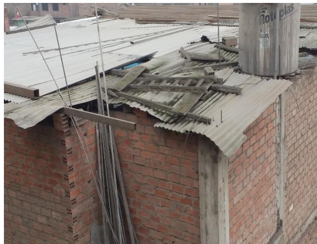
Figura 69: Viviendas Construida con techo predominante
