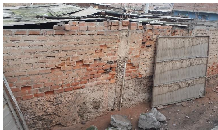
Figura 75: estado de conservación de la vivienda
