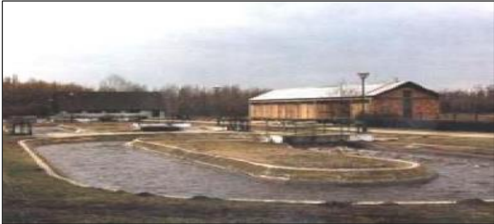
Figura N°: 8 – Zanja de Oxidación. Fuente: Ayala y Gonzales, 2008.
