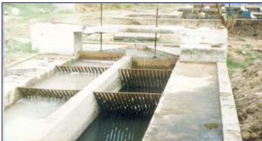
Figura N°: 1 – Canal de Rejas. Fuente: Ayala y Gonzales, 2008.
