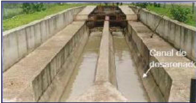
Figura N°: 2 – Canal Desarenador. Fuente: Ayala y Gonzales, 2008.
