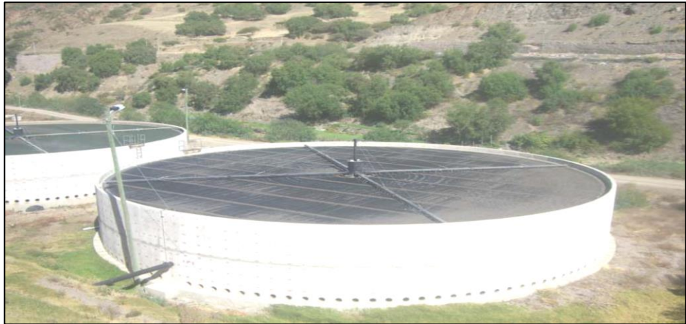
Figura N°: 11 – Vista General de un Filtro Percolador. Fuente: Ayala y Gonzales, 2008.
