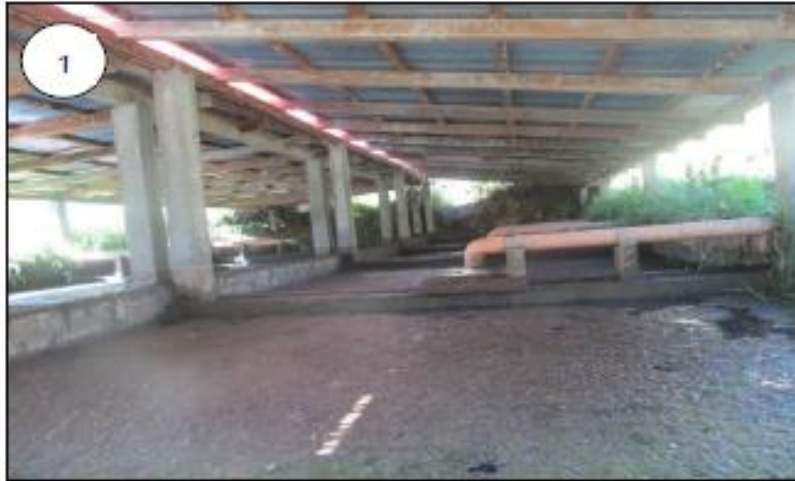
Figura N°: 17 – Estado Situacional del Lecho de Secado. Fuente: Elaboración Propia.
