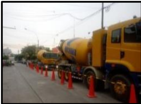
FOTOGRAFIA N°57. REVISION DE LA CALIDAD DEL TIEMPO YA QUE EL CONCRETO LLEGA A UN ESTADO DE SECADO EN ALGUNAS OCASIONES.
