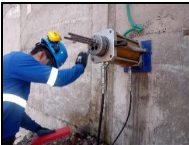
FOTOGRAFIA N°9. EN CURSO EL TENSADO DEL MURO
