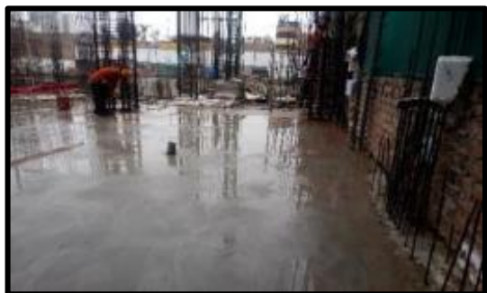
FOTOGRAFIA N°64. SE REALIZA EL CURADO DE LOS PISOS
