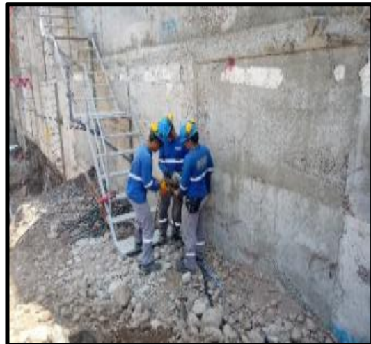
FOTOGRAFIA N°12. SEGUNDA CARGA DE TENSADO DEL MURO N° 2.02
