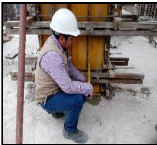
FOTOGRAFIA N°39. SE REVISA LA PLOMADA PARA ASEGURA SU VERTICALIDAD.
