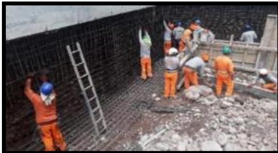
Figura 22. Colocación de Acero.
