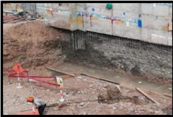
Figura 21. Muro anclado N° 2.01.
