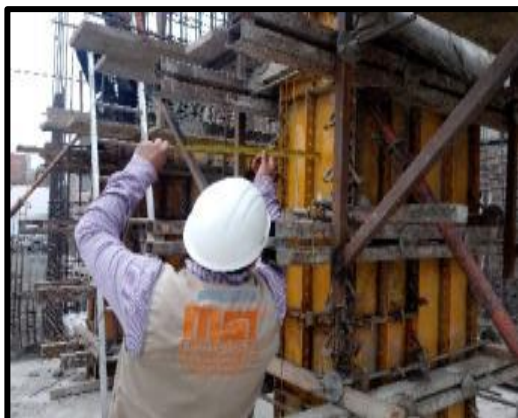
FOTOGRAFIA N°40. SE VERIFICA EL CORRECTO ASEGURAMIENTO DE APUNTALDO
