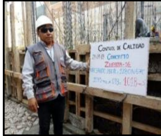
FOTOGRAFIA N°17. ASEGURAMIENTO Y CONTROL DE CALIDAD DEL CONCRETO EN LA ZAPATA.
