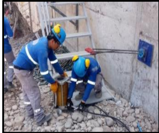
FOTOGRAFIA N°10. PRIMERA CARGA DE TENSADO Y CONTROL DE CALIDAD DE LA CARGA
