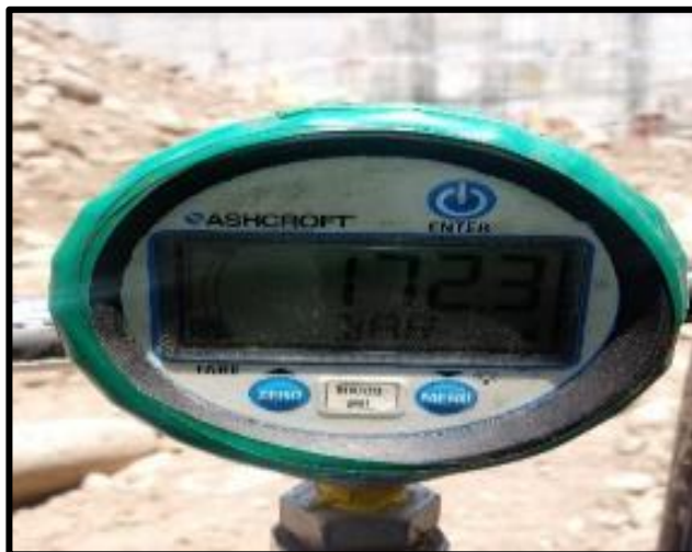
FOTOGRAFIA N°8. SEGÚN LO QUE INDICA EL PLANO ESTA DENTRO DEL MARGEN DE TOLERANCIA Y ESTA APLICANDO TENSION.
