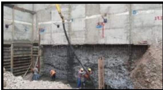
Figura 23. Vaciado de Concreto.
