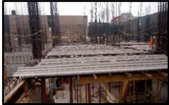
FOTOGRAFIA N°54. ORDEN DE LOS MATERIALES Y EL ADECUADO PROCESO DE COLOCACION DE LAS VIGUETAS
