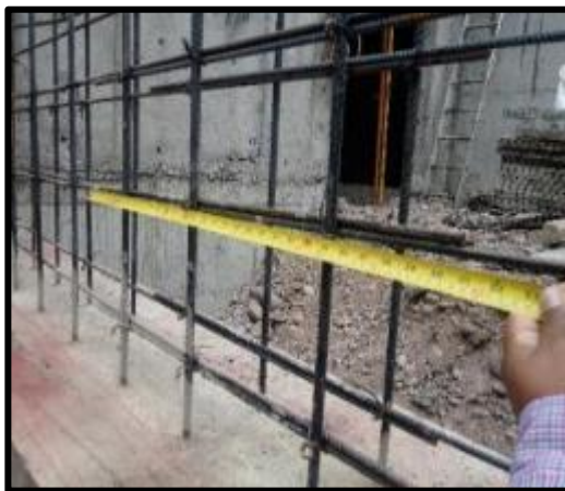
FOTOGRAFIA N°38. SE REALIZA ELCHEQUE DEL EMPALME DELACERO DEREFUERZO.
