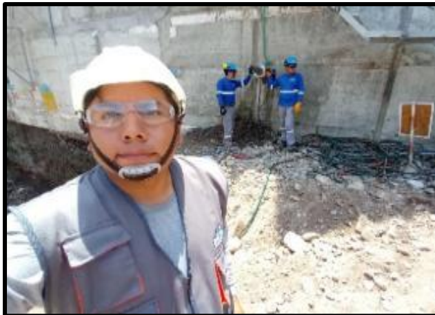
FOTOGRAFIA N°7. PREPARACION DEL TENSADO EN EL MURO 2.02
