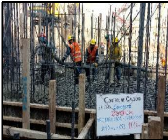
FOTOGRAFIA N°19. SE ESTA VACIANDO EL CONCRETO QUE HA SIDO REVISADO.
