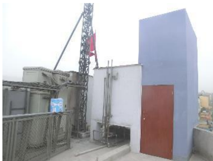
Azotea de la Edificación 25
