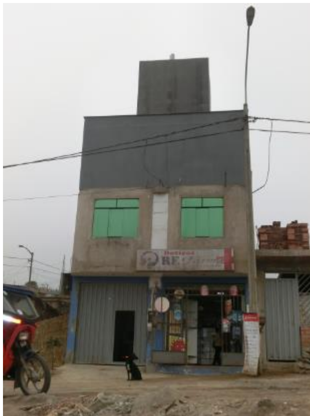
Fuente: Toma realizada por la autora Azotea de la Edificación 24
