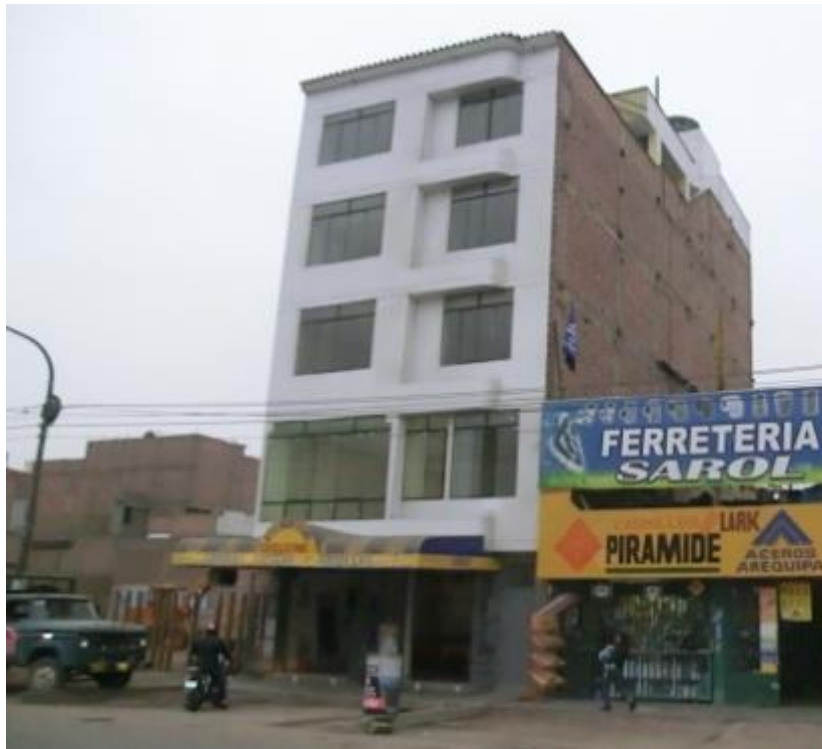
Fachada de la Edificación 12
