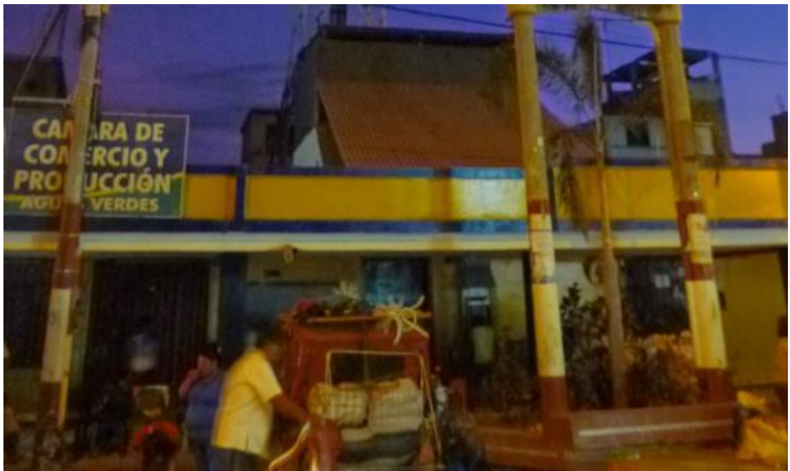
Fachada de la Edificación 31
