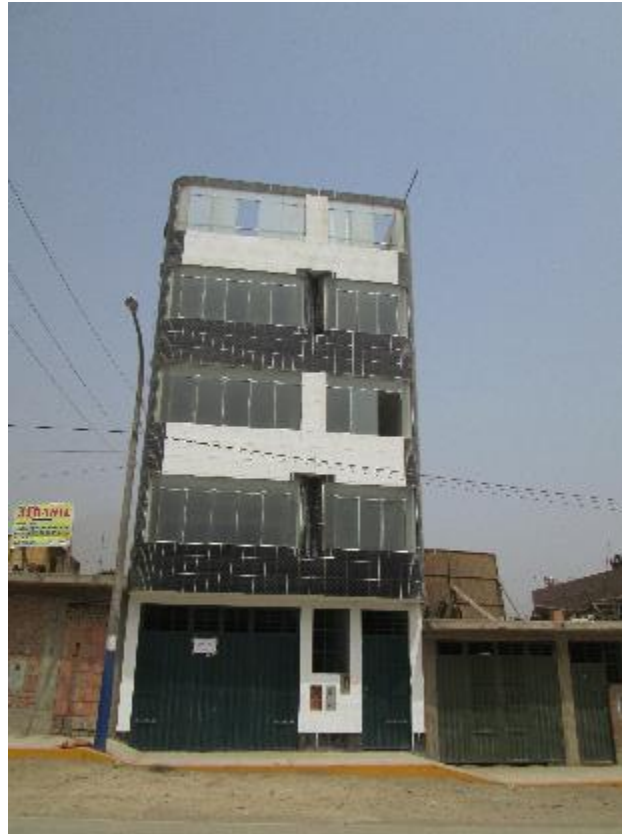
Fachada de la Edificación 13
