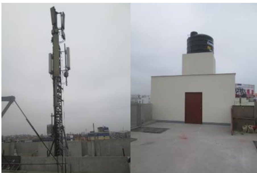
Azotea de la Edificación 10
