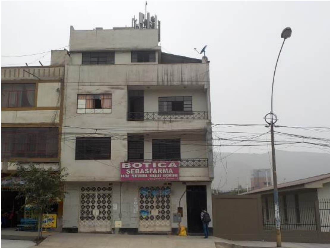
Fachada de la Edificación 32
