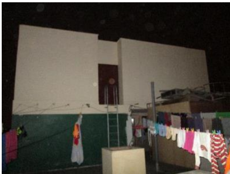
Fuente: Toma realizada por la autora
