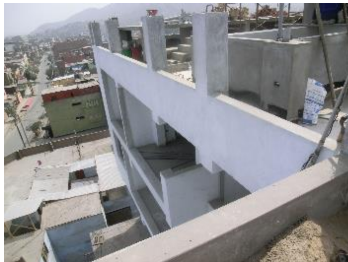
Azotea de la Edificación 22
