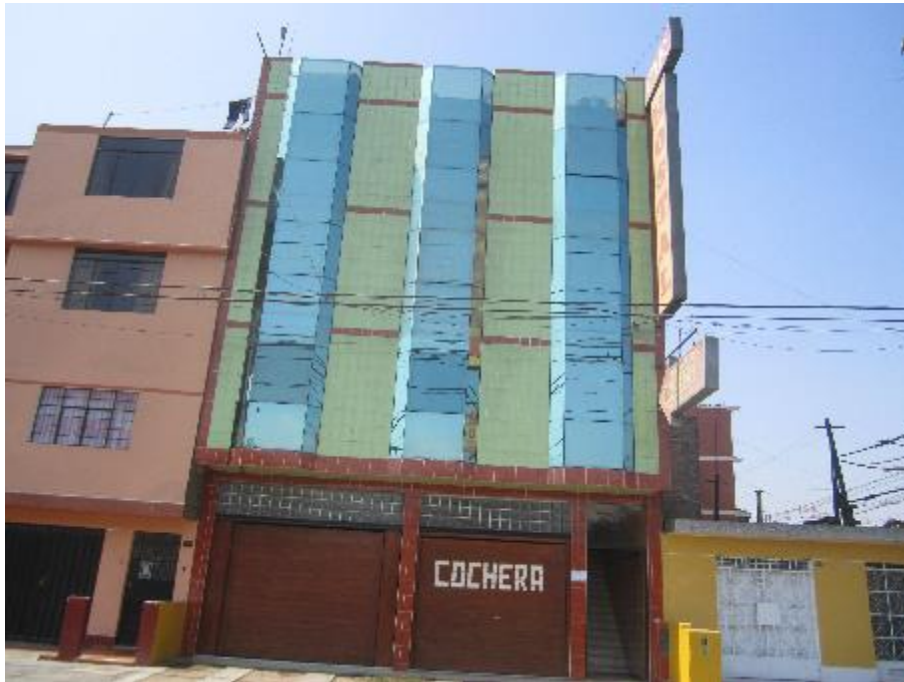
Fachada de la Edificación 19
