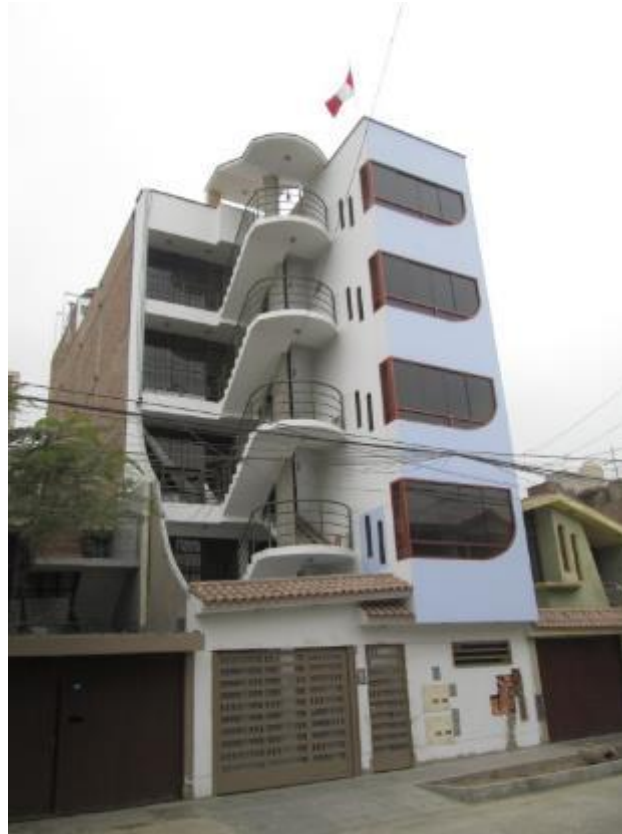
Fachada de la Edificación 14
