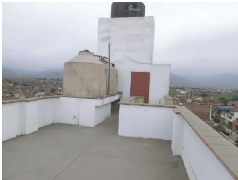
Azotea de la Edificación 12
