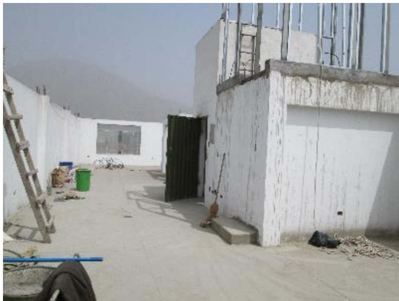
Azotea de la Edificación 13
