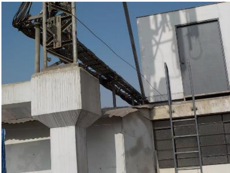
Azotea de la Edificación 32
