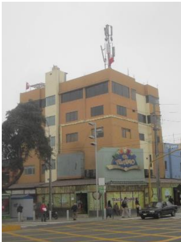
Fachada de la Edificación 10
