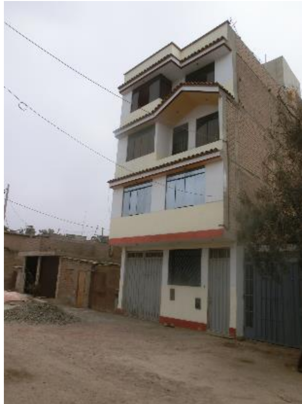
Fachada de la Edificación 20
