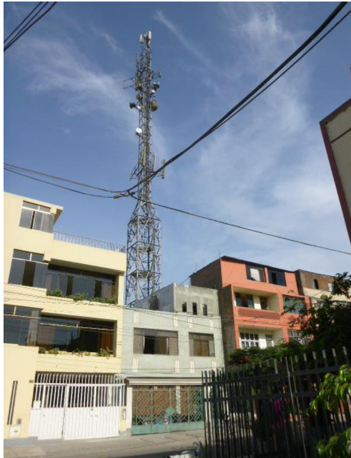
Fuente: Toma realizada por la autora Azotea de la Edificación 01
