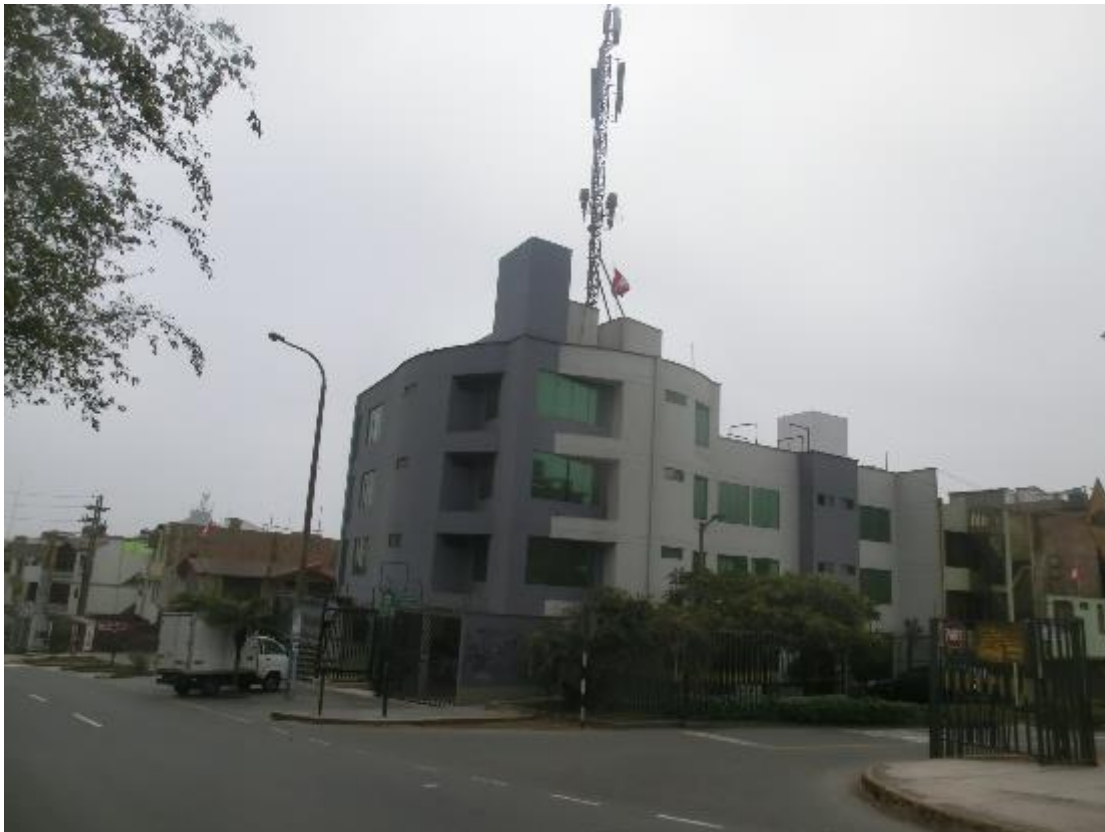
Fachada de la Edificación 25
