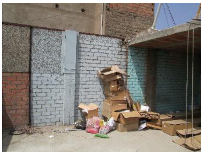
Azotea de la Edificación 23
