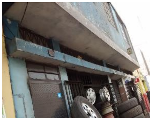
Vista de la viga peraltada, se puede apreciar deterioro de la sección.
