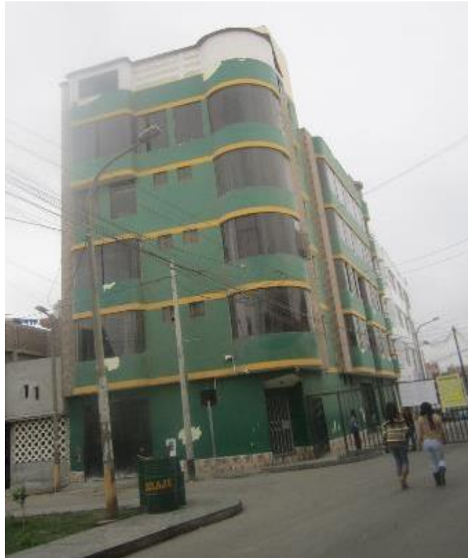
Fuente: Toma realizada por la autora Azotea de la Edificación 08
