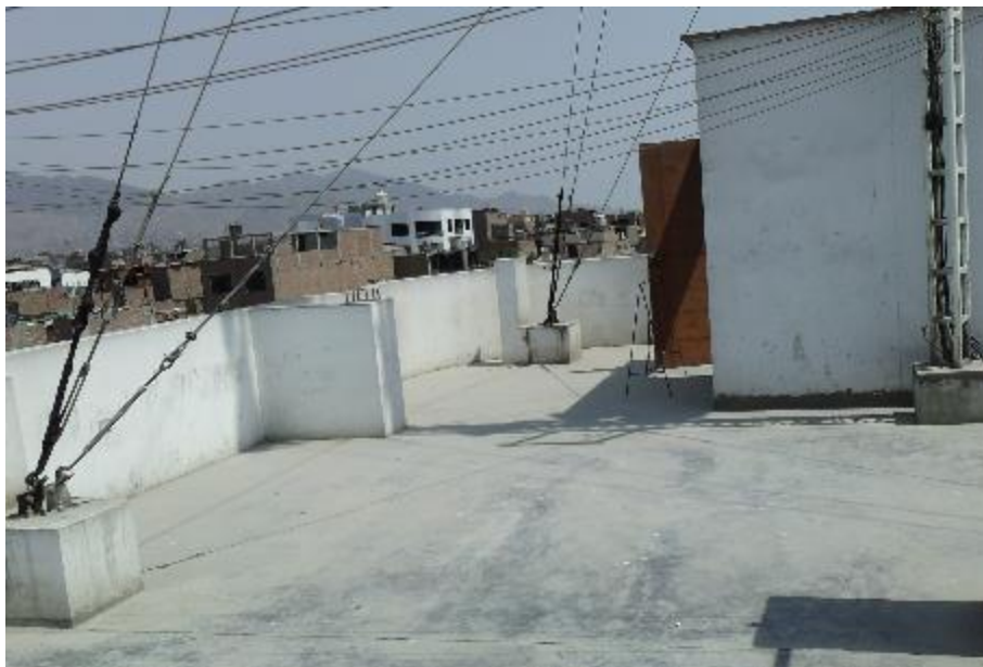
Azotea de la Edificación 21
