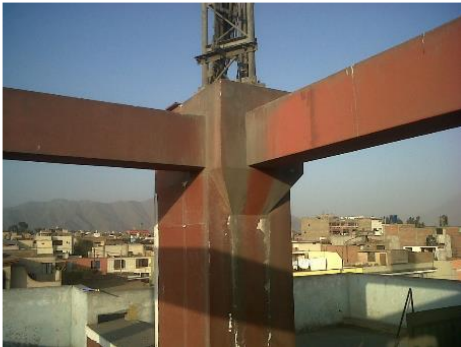
Azotea de la Edificación 06
