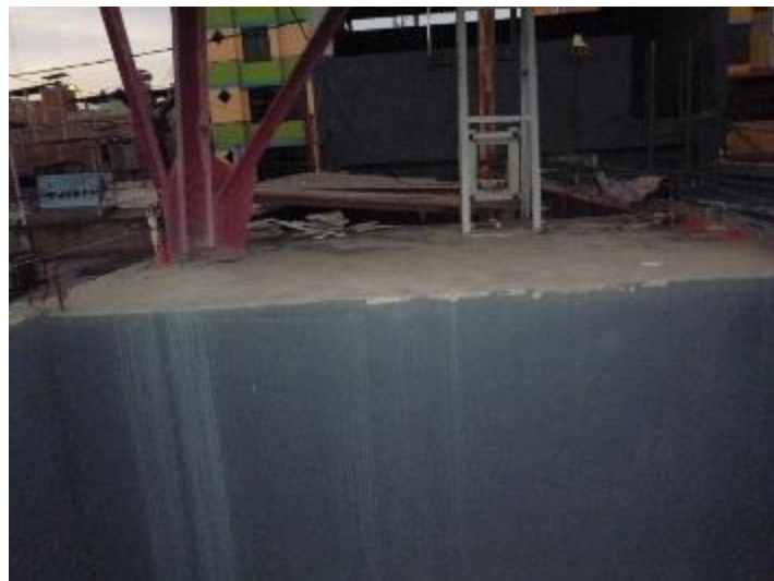
Azotea de la Edificación 31
