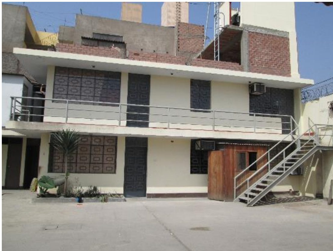
Fachada de la Edificación 23
