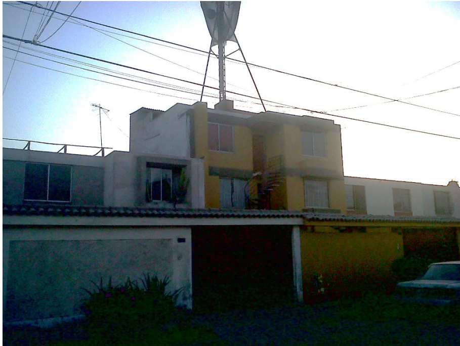
Fachada de la Edificación 06
