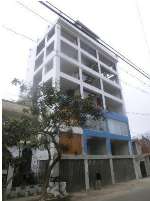
Fachada de la Edificación 22
