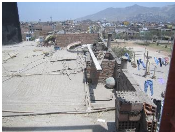
Azotea de la Edificación 19
