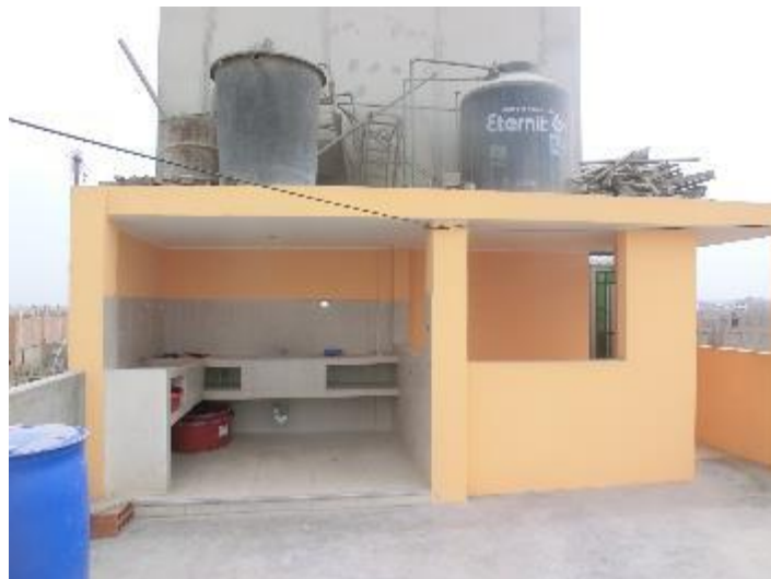
Azotea de la Edificación 20
