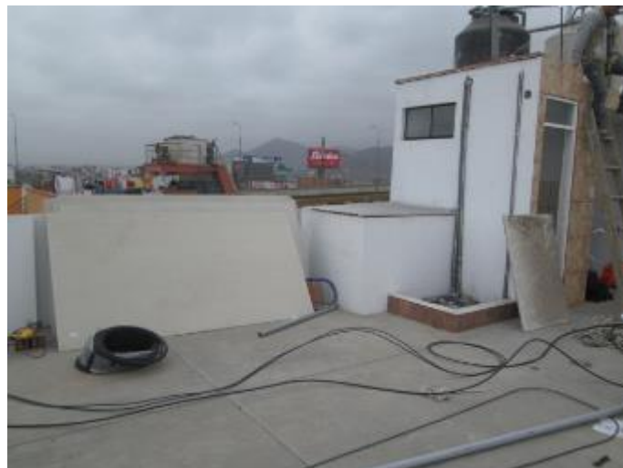
Azotea de la Edificación 14
