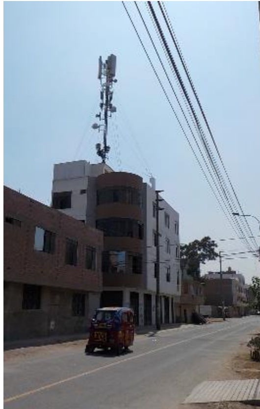
Fachada de la Edificación 21
