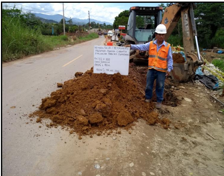
Fig. 05. Calicata en el sector km. 2+120 a km 2+300, muestreo km. 2+300, profundidad 1.80 m, L. Der.
