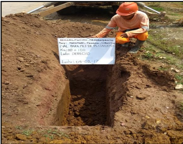
Fig. 11. Calicata en el sector km. 7+950 a km 8+120, muestreo km. 8+100, profundidad 1.50 m, L. Der.
