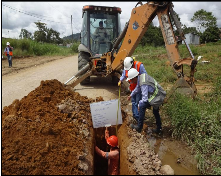
Fig. 16. Calicata muestreo km. 10+000, profundidad 1.50 m, L. Der. Modelo de medición de profundidad.
