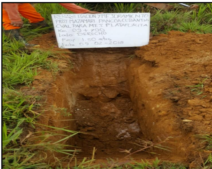
Fig. 15. Calicata en el sector km. 9+640 a km 9+750, muestreo km. 9+700, profundidad 1.50 m, L. Der.
