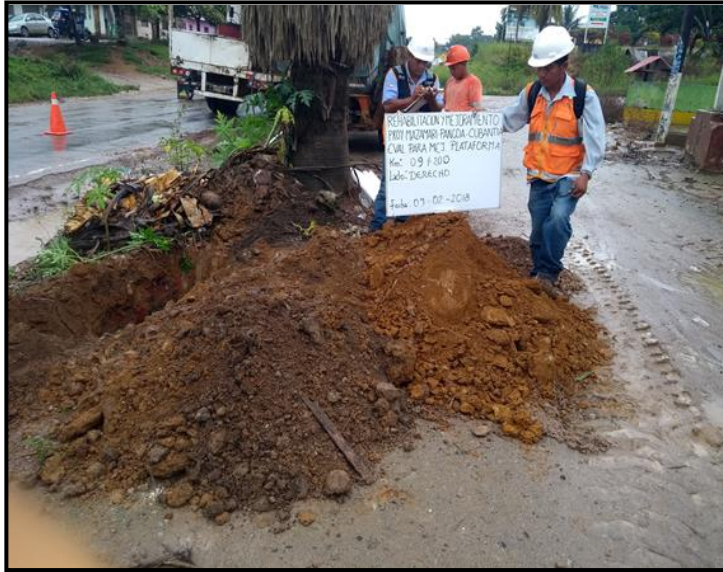
Fig. 13. Calicata en el sector km. 9+122 a km 9+350, muestreo km. 9+200, profundidad 1.50 m, L. Der.
