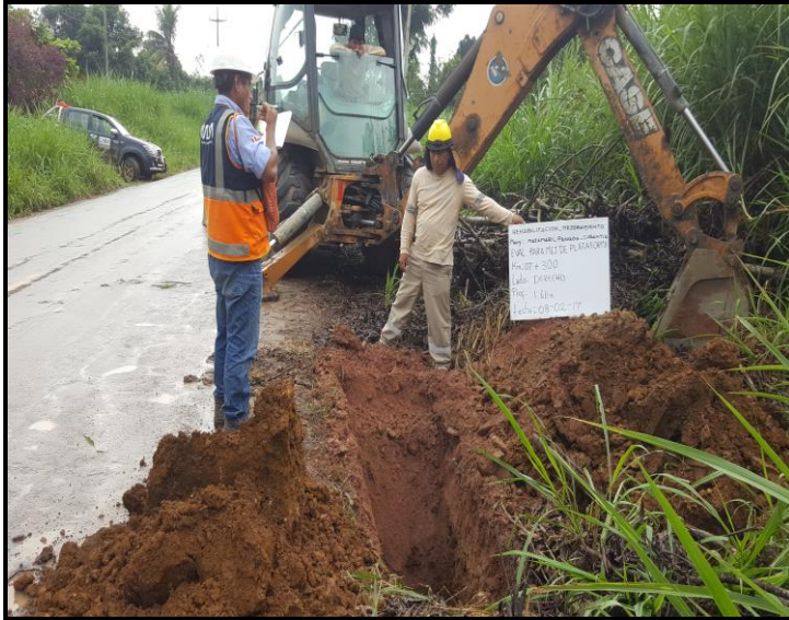
Fig. 10. Calicata en el sector km. 7+120 a km 7+380, muestreo km. 7+300, profundidad 1.60 m, L. Izq.
