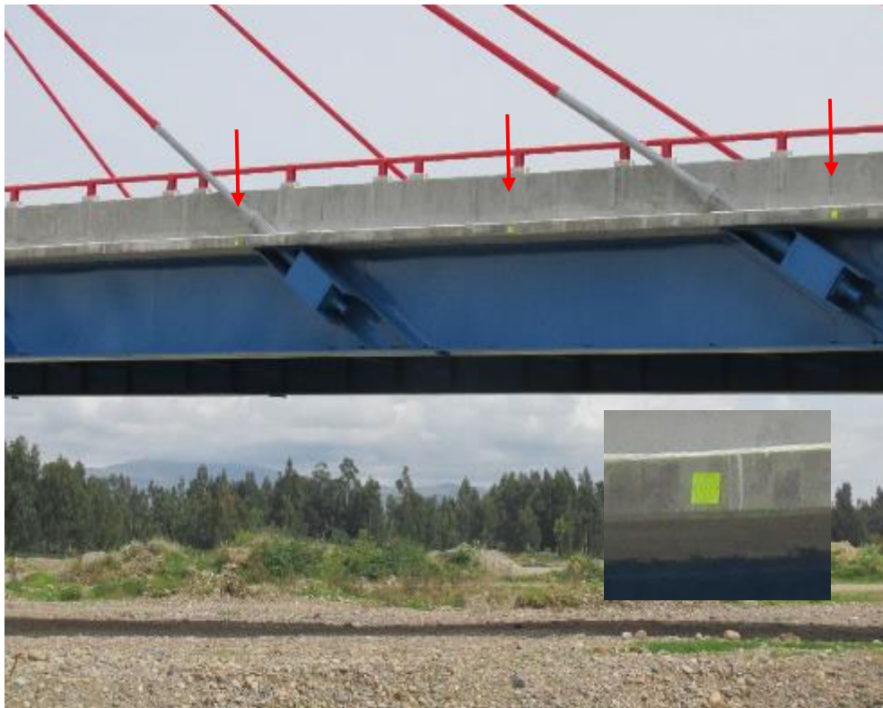
Figura 23 - Dianas colocadas en el voladizo
