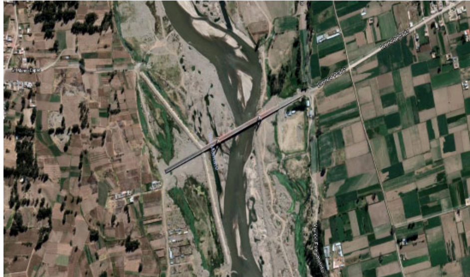
Figura 8 - Puente Mantaro - Chilca y tres de diciembre
