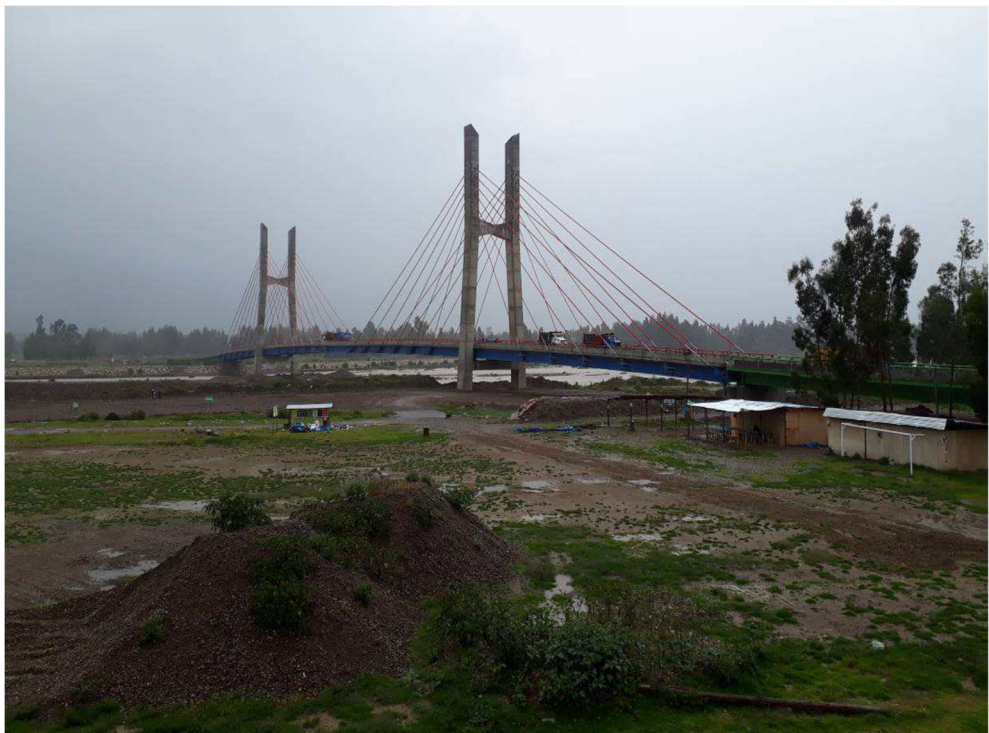
Figura 37 - Colocación de volquetes del estado de carga 3
