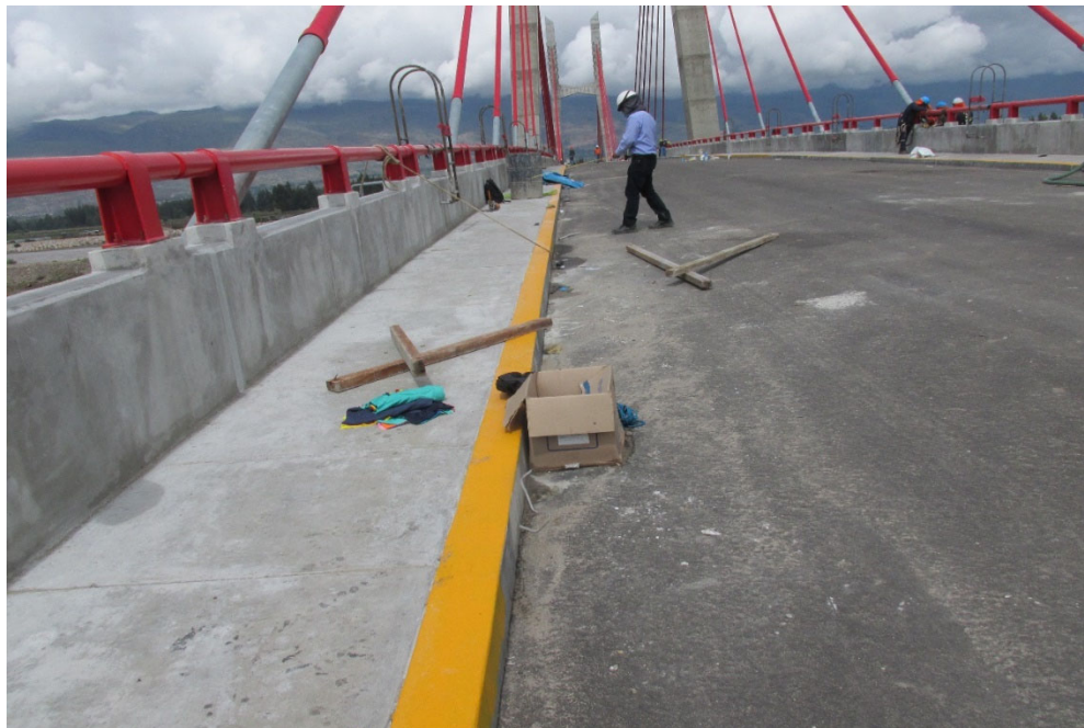
Figura 21 - Replanteo de ubicación de posición de carga
