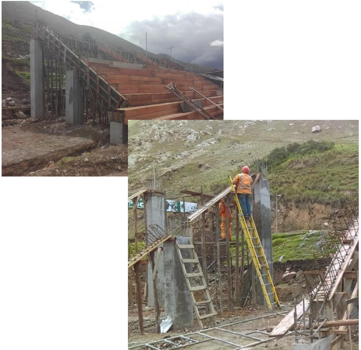
**Imagen N°07:** En la imagen se puede apreciar el encofrado de la gradería.
