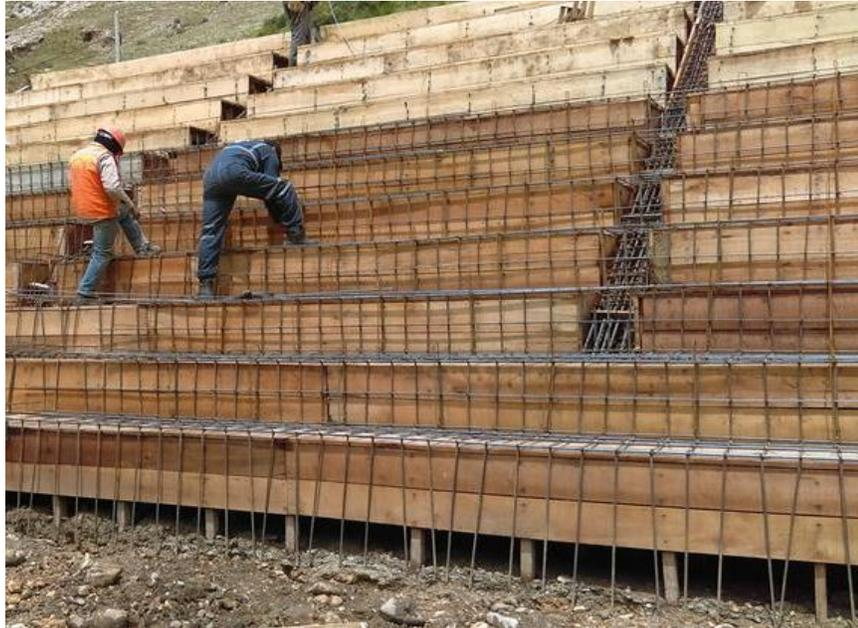
**Imagen N°08:** En la imagen se puede apreciar el enmallado de la gradería.
