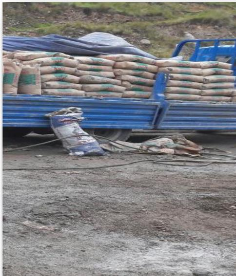
**Imagen N°06:** En la imagen se puede apreciar que el cemento está expuesto al aire.
