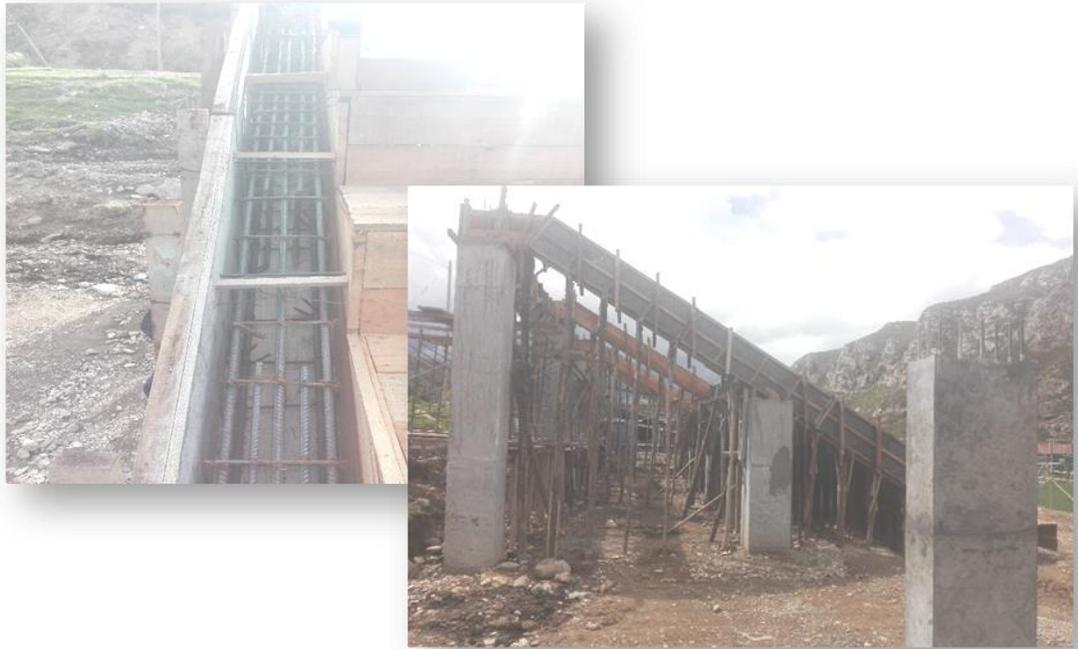
Fotografía N°06: ENCOFRADO DE GRADERIAS
