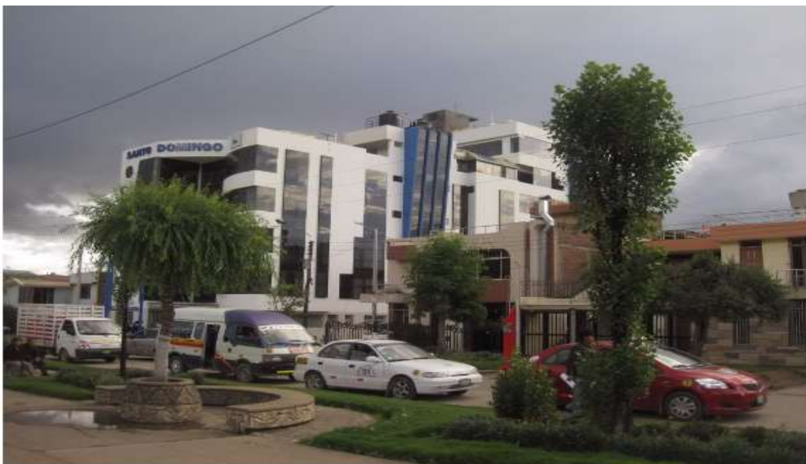
Figuras 13 Vista panorámica de la clínica
