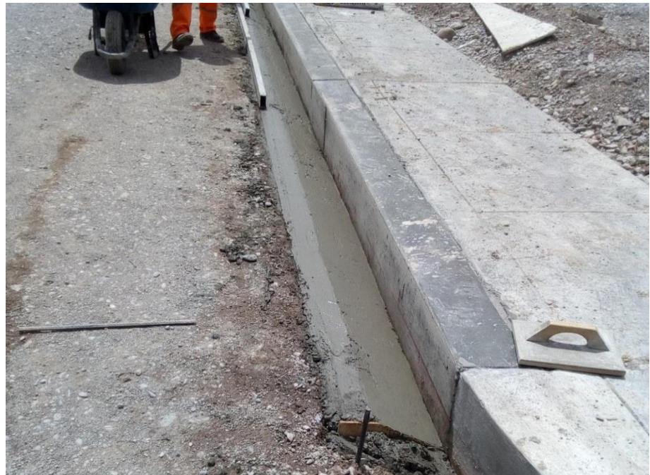
Fotografía. 15. Vaciado de cuneta. (Fuente: Propia)
