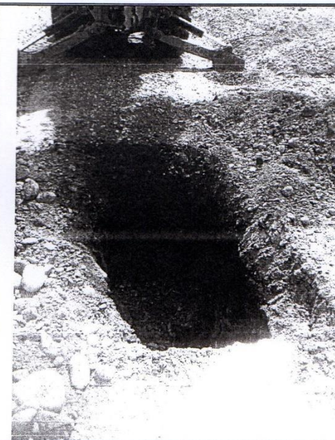
FOTOGRAFIA 17 : Excavación "Los Naranjos"
