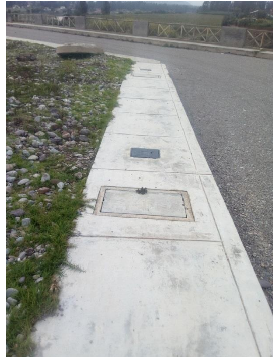
Fotografía 06. Redes de Desagüe Domiciliario en la Calle Saucos. (Fuente Propia)
