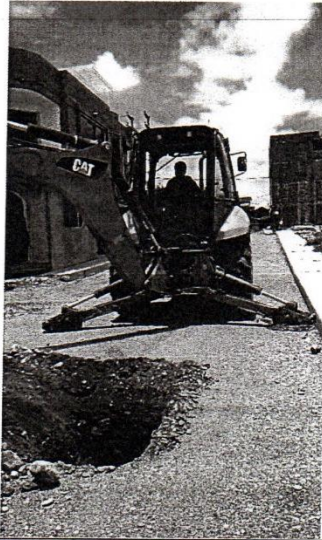
FOTOGRAFIA 5 : : Excavación Los Perales
