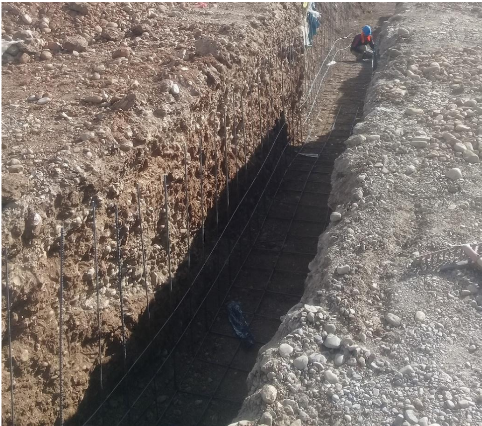
Fotografía. 22. Armado de la estructura con fierros de \frac{1}{2} @ 0.20 m. (Fuente: Propia)
