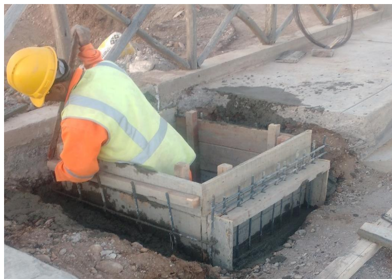
Fotografía. 20. Encofrado y vaciado del sumidero. (Fuente: Propia)
