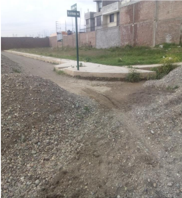
Fotografía 01. Acumulación de material en la intersección de las Calles Naranjos y Nisperos (Fuente Propia)
