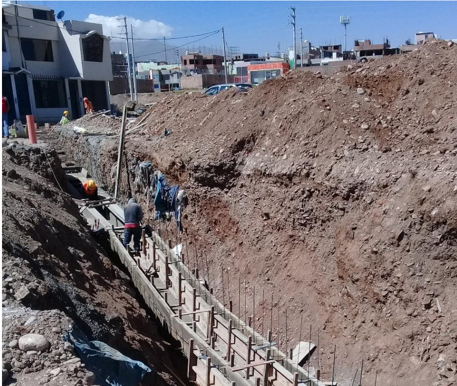
Fotografía. 23 Encofrado del canal en el área de recreación. (Fuente: Propia)
