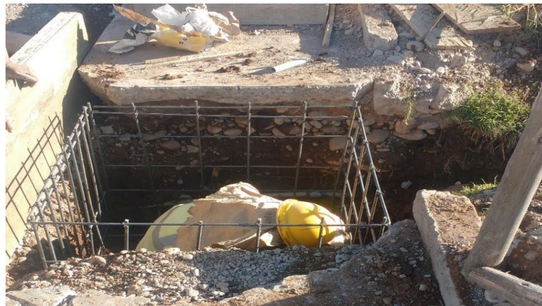
Fotografía. 19. Armado de estructura de sumidero. (Fuente: Propia)
