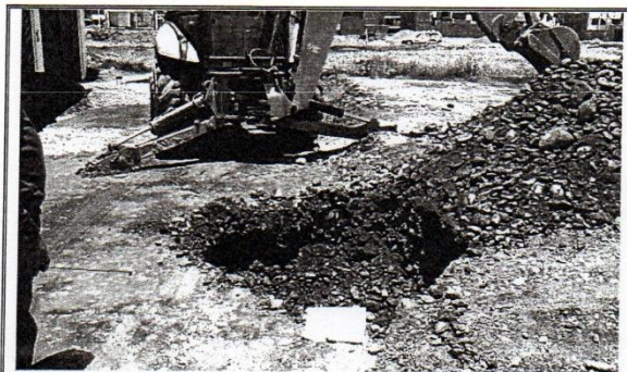
FOTOGRAFIA 7 : Excavación Las Higueras
