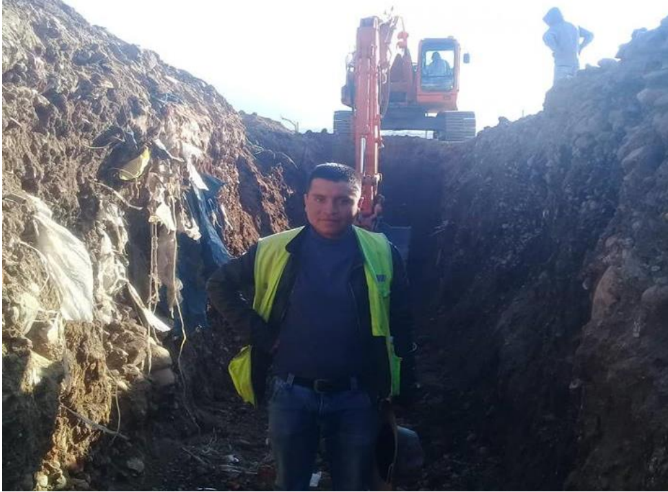
Fotografía. 21. Excavación de la zanja para el canal. (Fuente: Propia)
