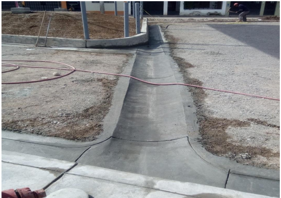
Fotografía.18. Culminación del Badén. (Fuente: Propia)
