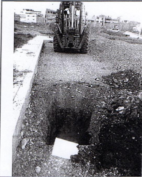
FOTOGRAFIA 15 : Excavación "Los Nísperos"
