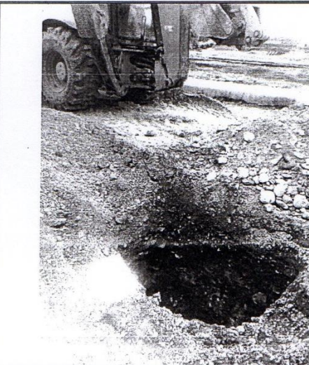
FOTOGRAFIA 3 Excavación Las Moreras
