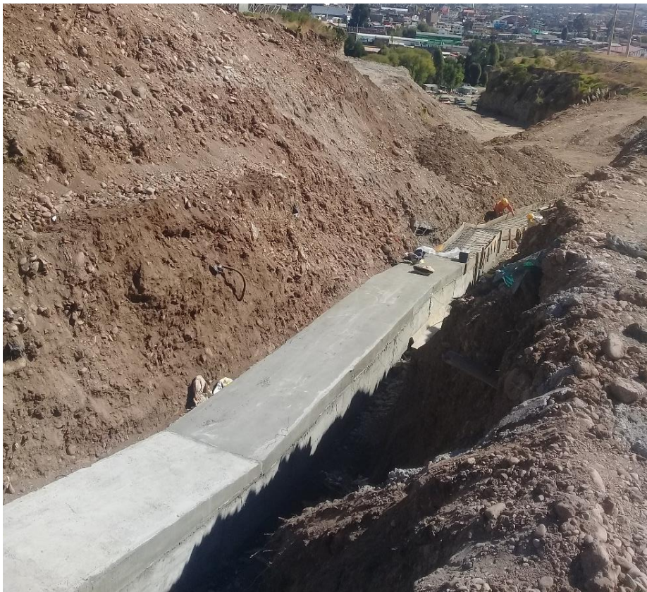
Fotografía. 25. Desencofrado del Canal. (Fuente: Propia)
