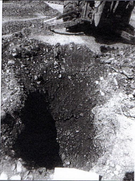
FOTOGRAFIA 11 : Excavación Los Molles
