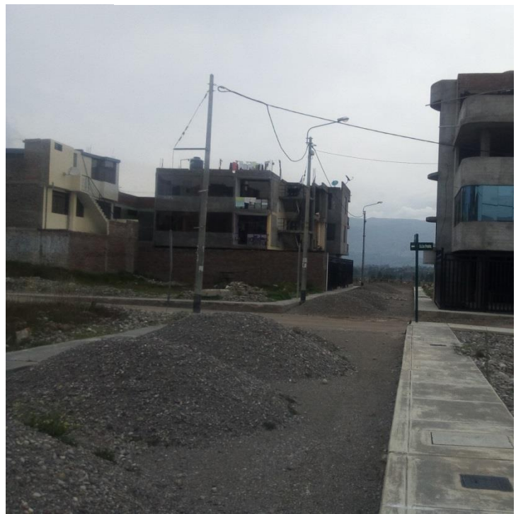
Fotografía 08. Redes de Desagüe Domiciliario en la Calle Saucos. (Fuente Propia)
