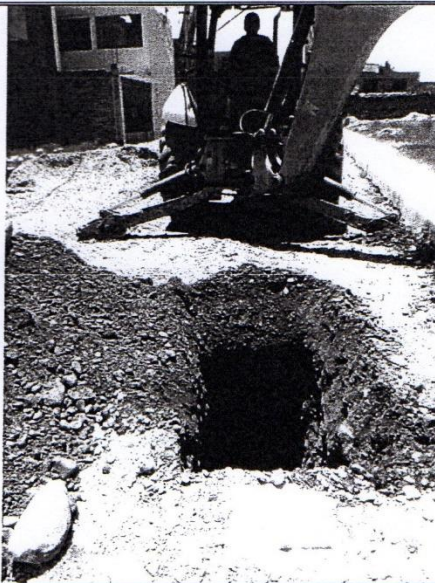
FOTOGRAFIA 9: Excavación Los Algarrobos-Acacias
