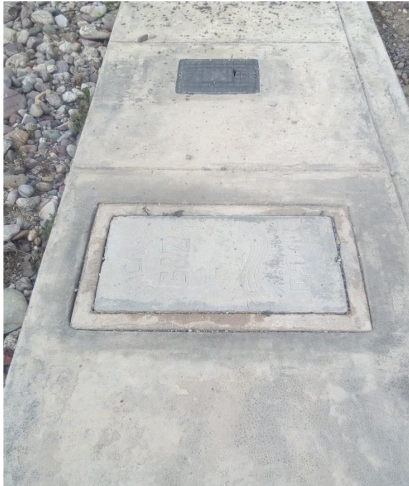
Fotografía 05. Redes de Desagüe Domiciliario en cada lote de la Urbanización. (Fuente Propia)
