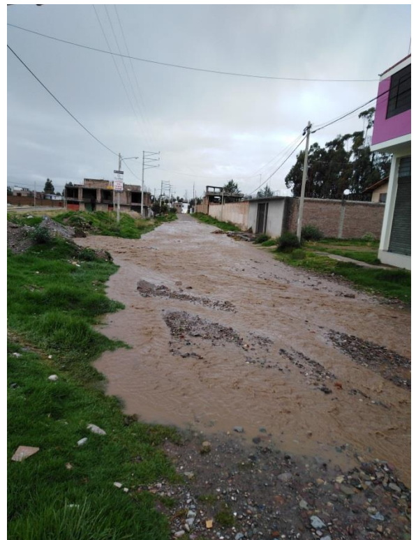
Fotografía. 12 evacuaciones de precipitaciones por la Calle Rosita salas. (Fuente Propia)
