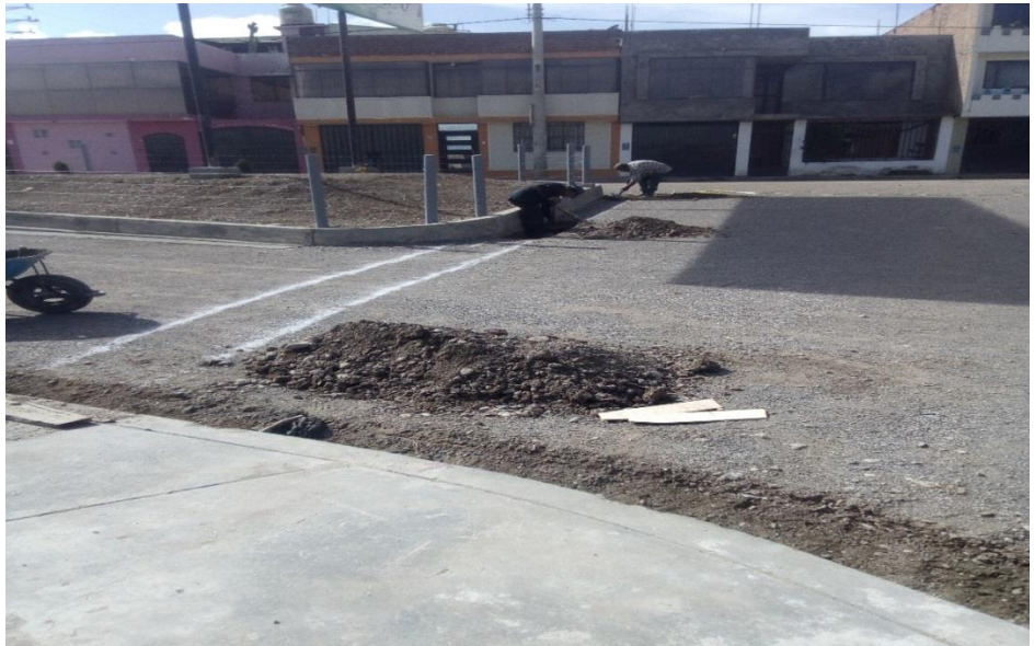
Fotografía. 17. Trazo para la elaboración del Badén. (Fuente: Propia)
