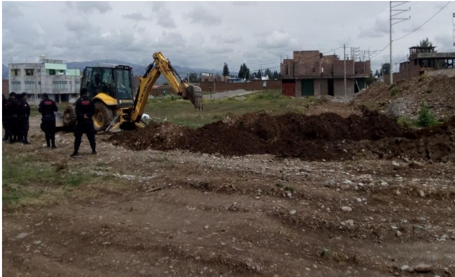
Fotografía. 13. Excavación por la Municipalidad Distrital de El Tambo tratando de solucionar el alcantarillado pluvial de este sector. (Fuente Propia)
