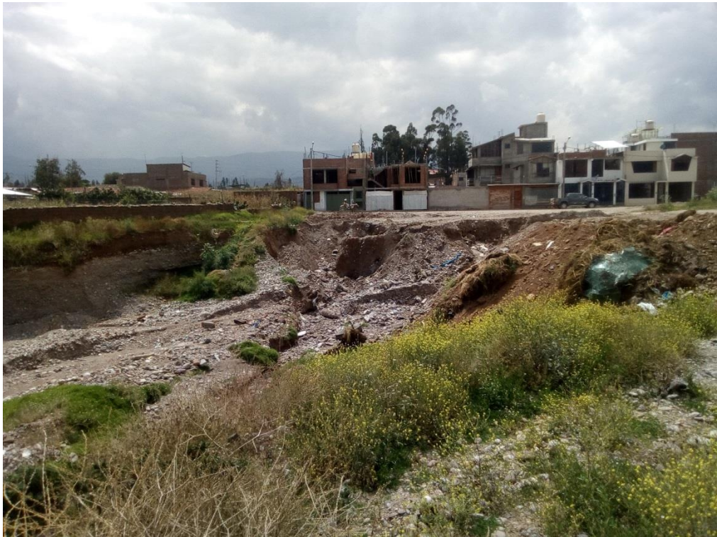
Fotografía 09. Socavado del área de recreación por lluvias. (Fuente Propia)
