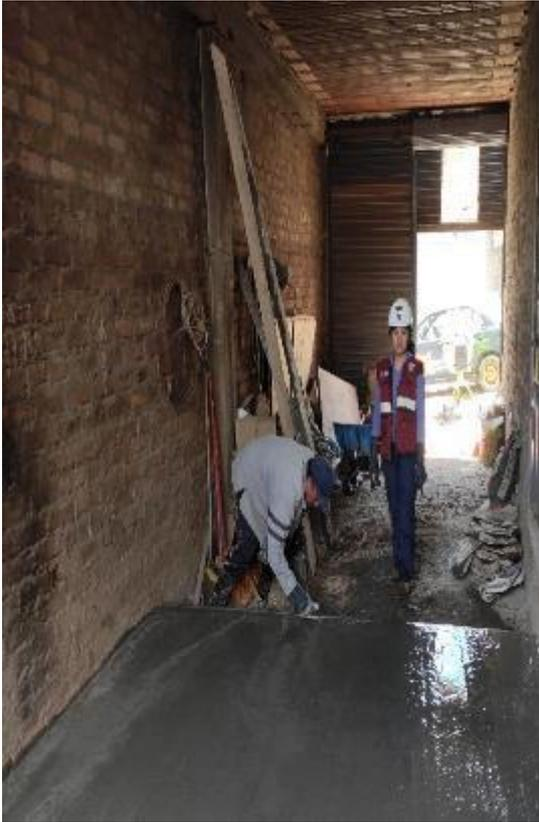
FOTO N° 25: Culminación del Vaciado del pavimento (losa corta) con la Dosificación 1.
