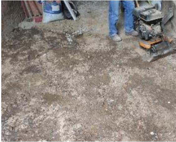
FOTO N° 22: Compactación del terreno para iniciar con el vaciado del pavimento (losa corta).
