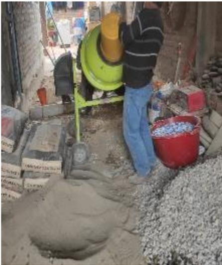
FOTO N° 23: Se verifico las cantidades exactas para vaciar el pavimento (losa corta) de 3m x 3m x 0.15cm.
