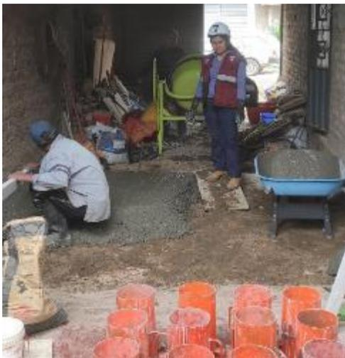
FOTO N° 24: Vaciado del pavimento (losa corta) 3m x 3m x 0.15cm aplicando las proporciones de la Dosificación 1.
