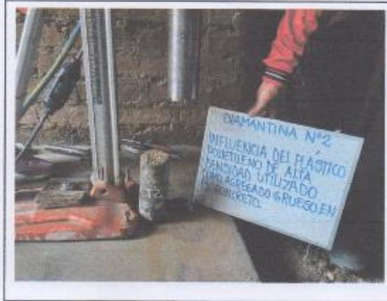
FOTO 03.- EXTRACCIÓN DEL TESTIGO DIAMANTINO T-02 EN PAVIMENTO CORRESPONDIENTE AL PROYECTO: "INFLUENCIA DEL PLASTICO POLIETILENO DE ALTA DENSIDAD UTILIZADO COMO AGREGADO GRUESO EN EL CONCRETO"
