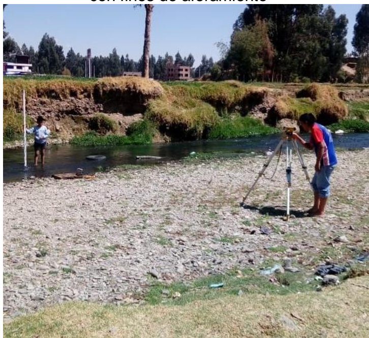
En esta toma se observa nivelación con la finalidad de obtener la sección típica con fines de aforamiento
