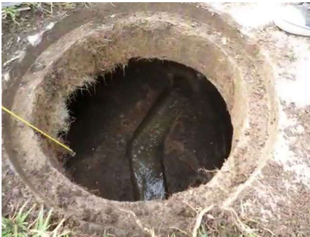
FIGURA N° 05: Midiendo la profundidad del Bz04
