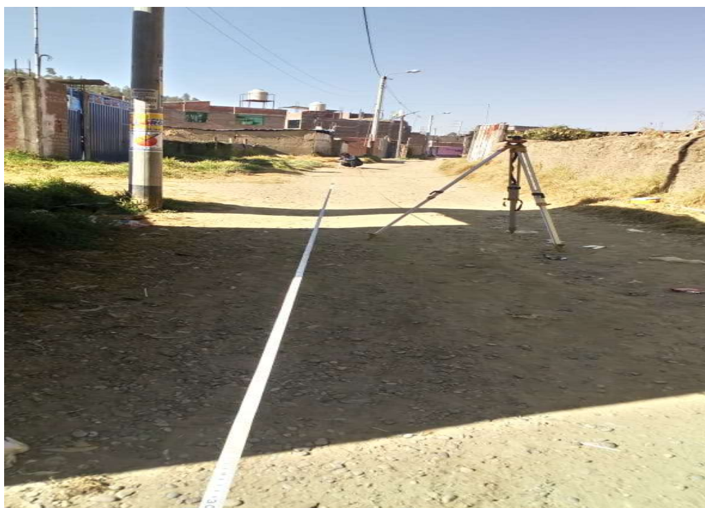
FIGURA N° 04: Tomando distancia del tramo Bz03 – Bz04
