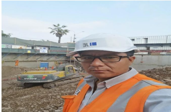
Realizando trabajos de inspección de los muros anclados.
