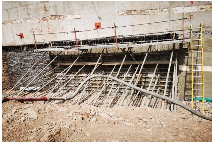
Culminación de llenado de concreto del muro anclado.
