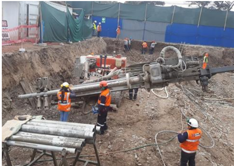
Figura 34 Perforación de anclajes.
