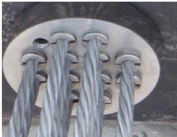
Figura 47. Cable postensado. Fuente propia.
