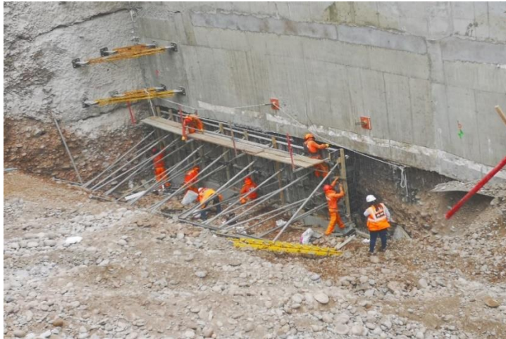
Culminando el encofrado del muro anclado.
