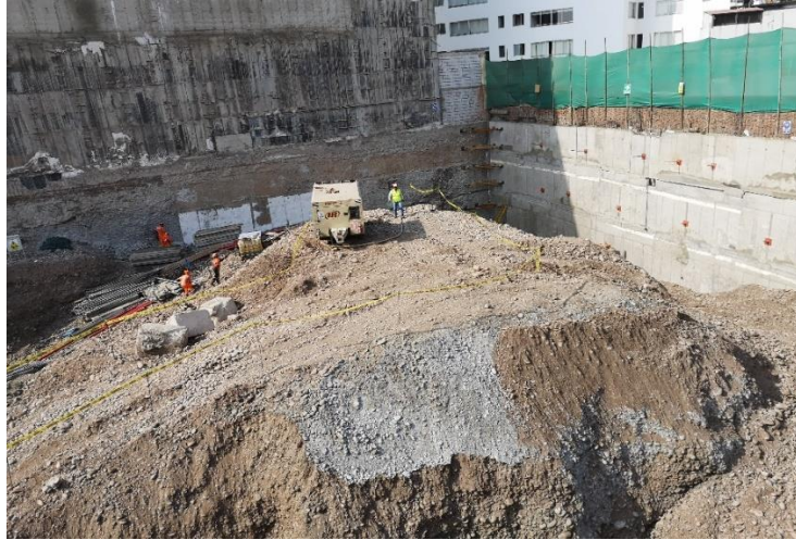
Culminación del tercer anillo de los muros anclados.
