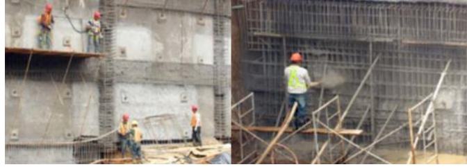
Figura 4. Armado y lanzado de concreto
