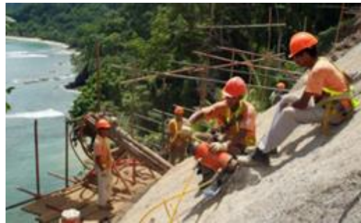
Figura 5. Tensado de los anclajes
