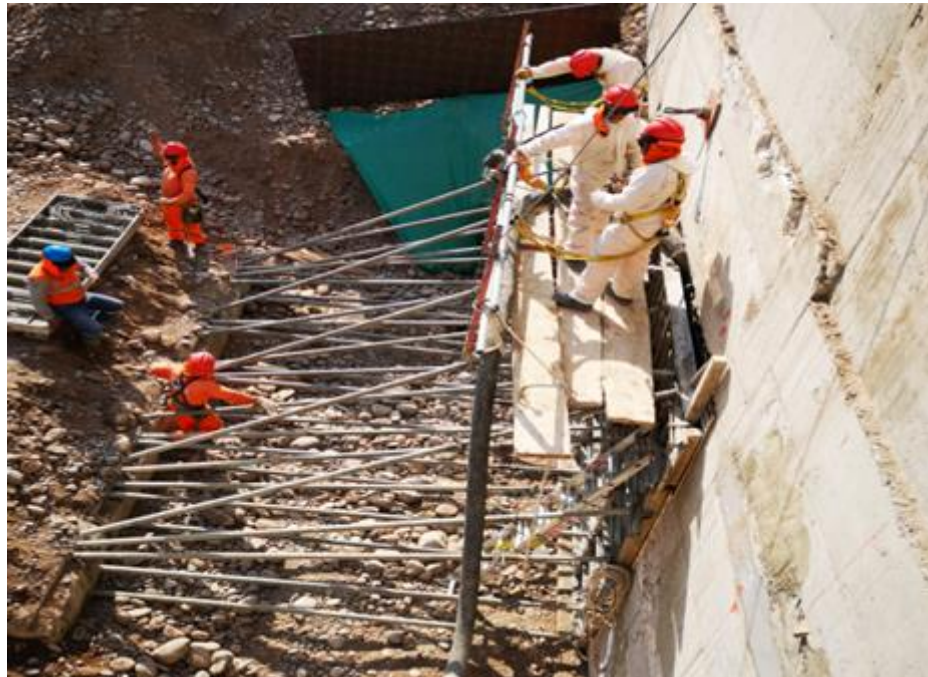
Figura 41. Vaciado de concreto en muros anclados.
