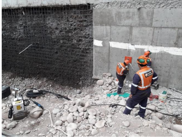
Figura 51. Bomba hidráulica. Fuente propia.
