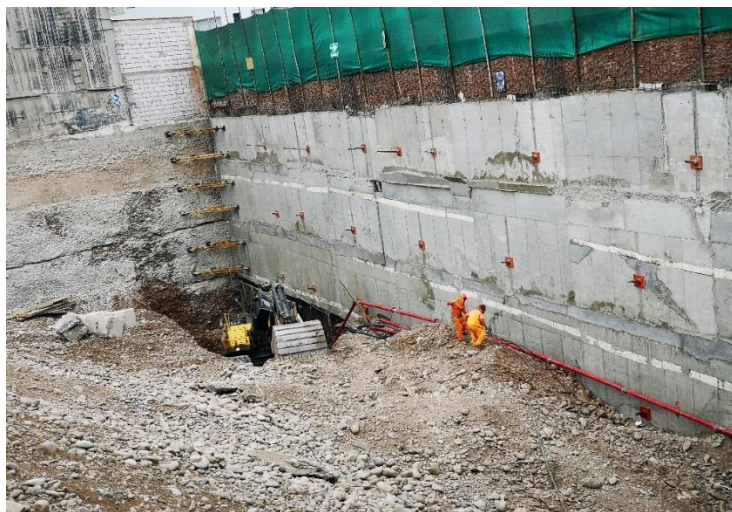
Empezando las excavaciones del cuarto anillo.
