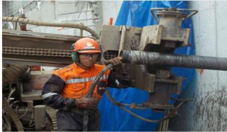
Figura 38. Inyección de lechada.
