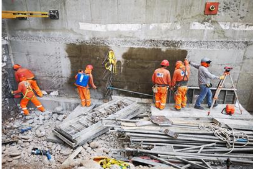
Figura 43. Curado con aditivo el muro.
