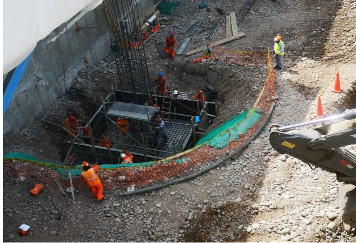
Vista de la zapata.
