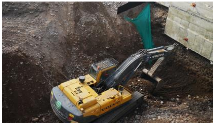
Figura 30. Perfilado de terreno con maquinaria.
