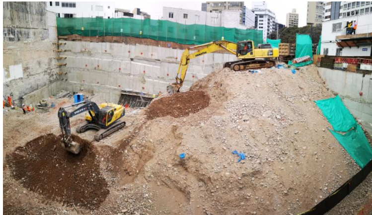
Figura 28. Eliminación de movimiento de tierra mediante banqueta. Fuente propia.
