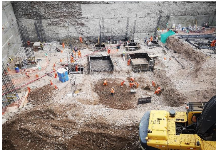
Culminación de los muros anclados y ejecución de las zapatas.
