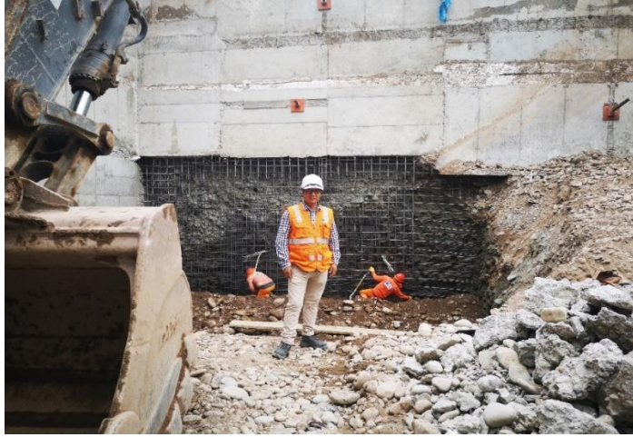
Culminando con el enmallado de acero del muro anclado.
