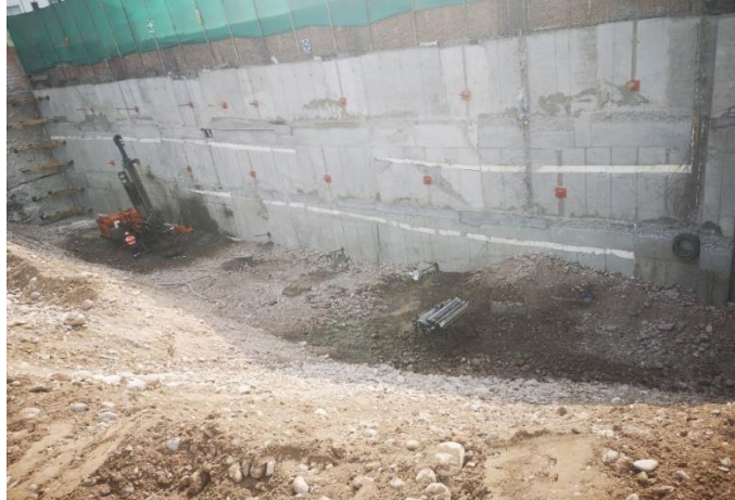
Proceso de excavación de los muros anclados.
