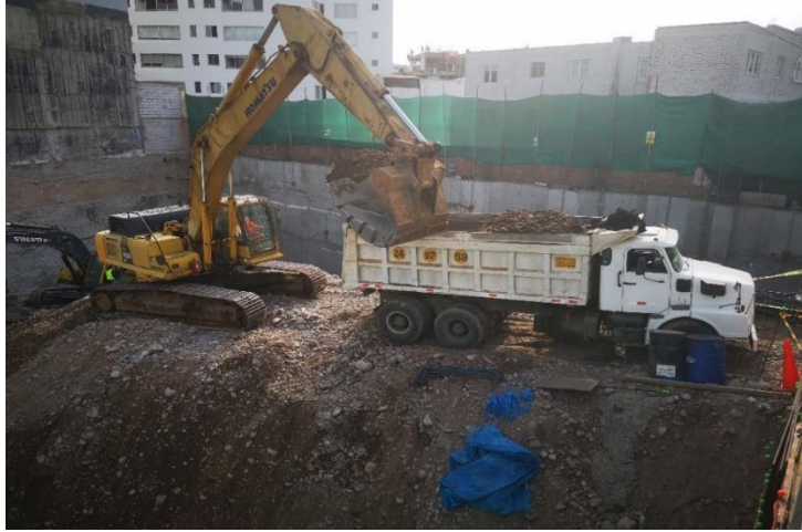
Eliminación del material excavado.
