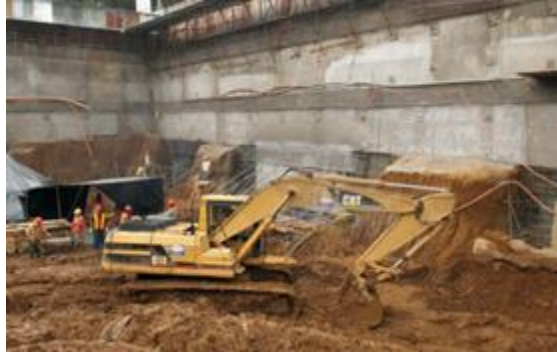
Figura 2. Movimiento de Tierra
