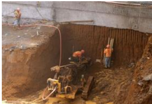
Figura 3. Perforación de anclajes mediante equipo neumático
