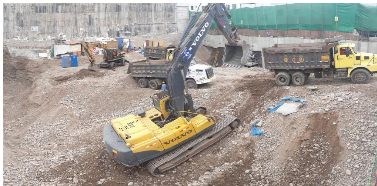
Figura 27. Excavación con el uso de la retroexcavadora.
