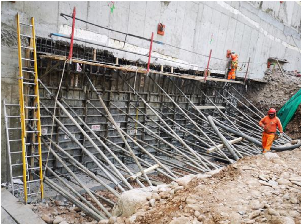
Figura 40. Encofrado de muros anclados.
