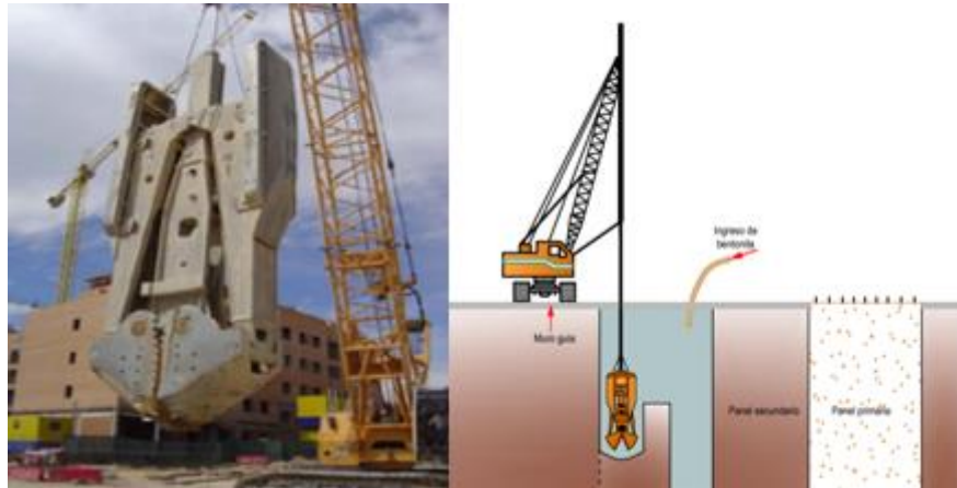
Figura 9. Sistema “de excavación con cuchara Bivalva
