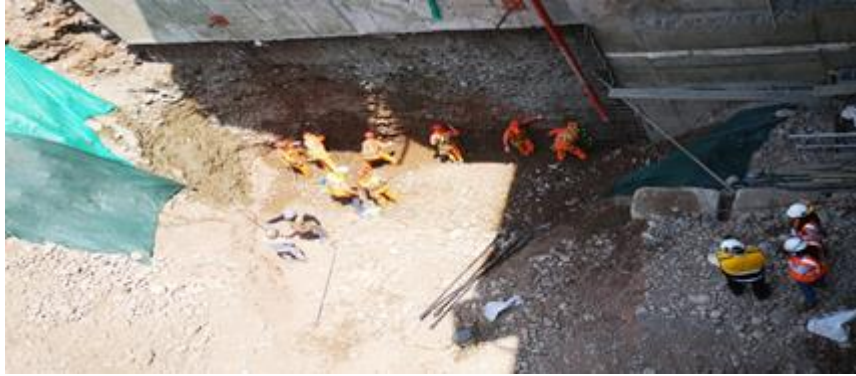
Figura 31. Perfilado de terreno manual fuente propia
