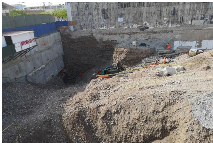
Vista panorámica de la obra.
