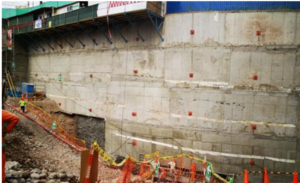
Figura 42. Desencofrado de muros anclados.
