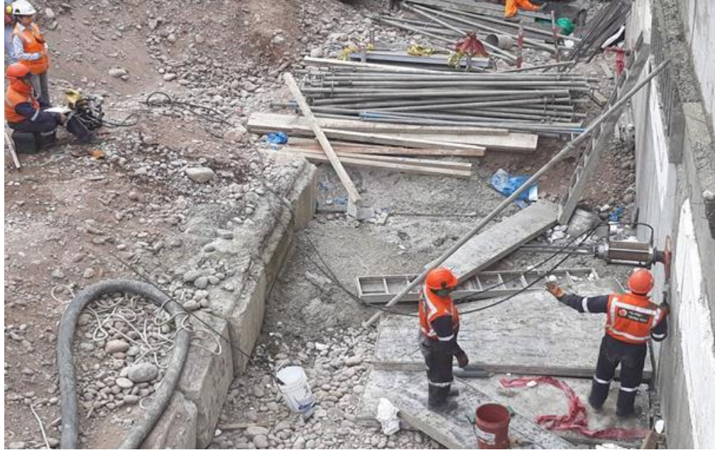
Figura 44. Tensado de anclajes.
