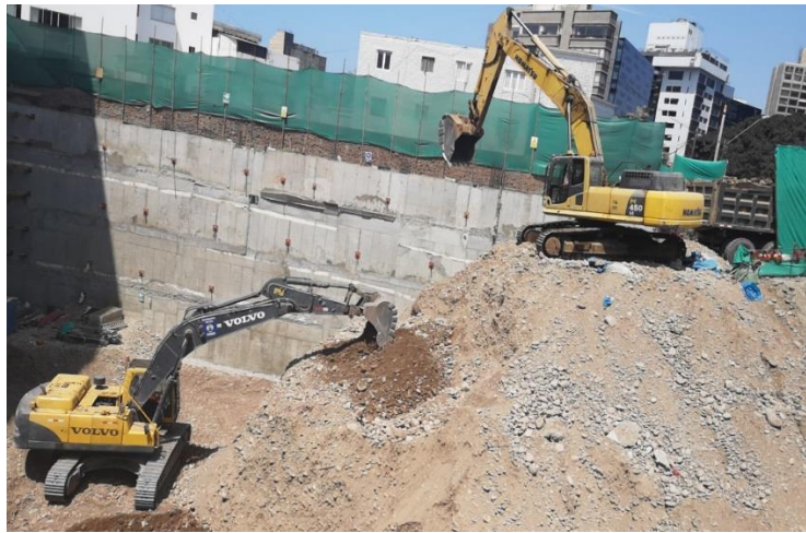
Eliminación de material excavado por capas.
