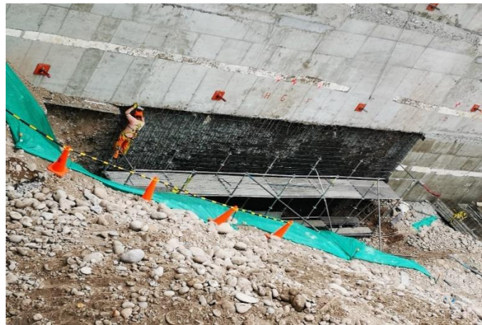
Culminando la colocación de los fierros del muro anclado.
