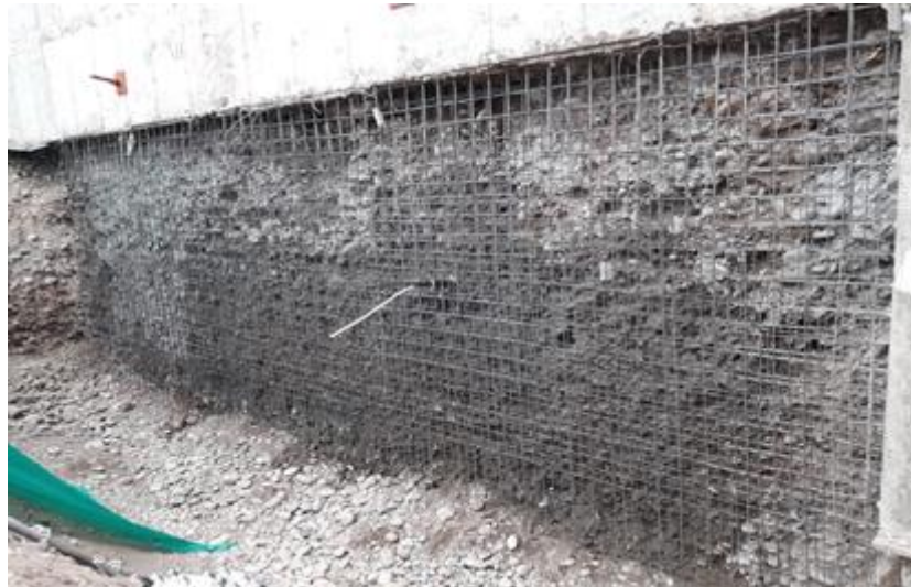
Figura 39. Instalación de acero de refuerzo.
