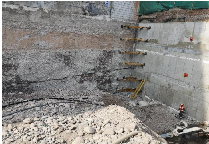
Arriostres en esquina para estabilizar los empujes.
