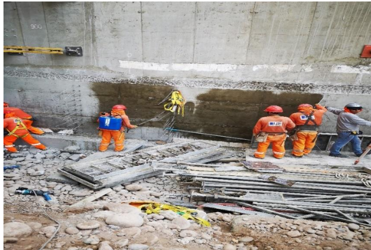
Curado con aditivo del muro anclado.
