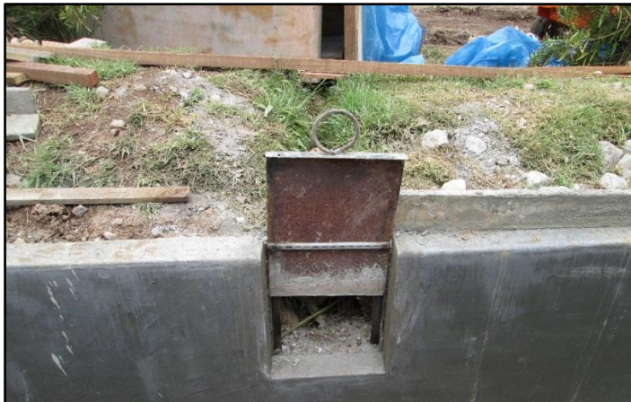
Foto 32 Toma Lateral De La Toma De Yanamuclo
