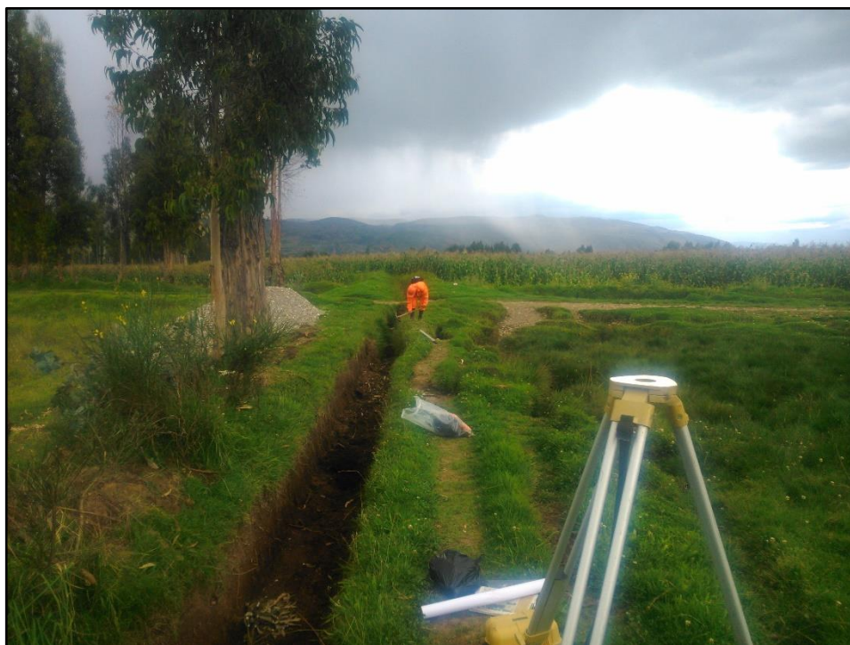
Foto 22 Toma 06 Terreno Compactado
