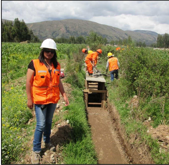
Foto 08 Encofrado Monolítico De La Toma De Yanamucló
