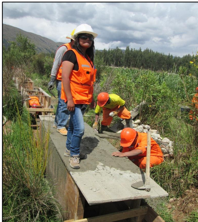
Foto 09 Encofrado Y Vaciado De La Toma De Yanamucló
