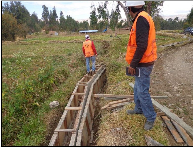
Foto 04 Encofrado De Muros De Toma 2 – Matahuasi
