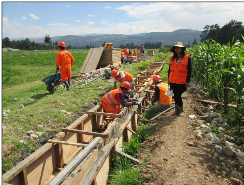
Foto 05 Encofrado De Muros Toma De Yanamucllo
