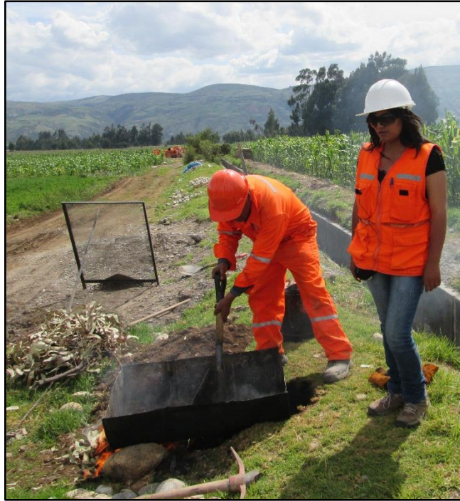
Foto 30 Preparación De Las Juntas Asfálticas
