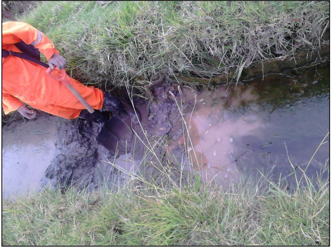
Foto 20 Toma 06 Limpieza Del Canal
