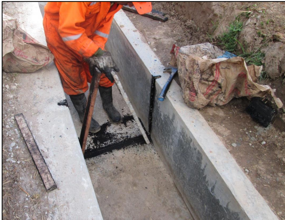
Foto 31 Colocación De Las Juntas Asfálticas
