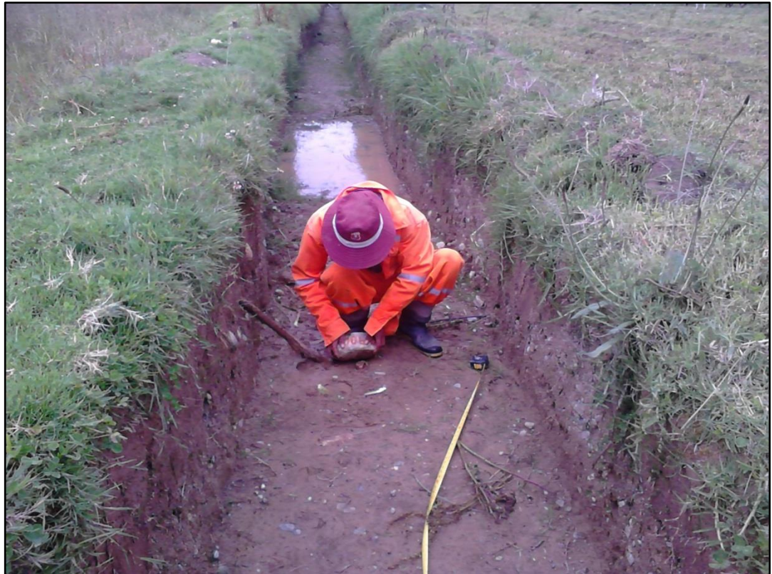
Foto 21 Toma 06 Terreno Compactado
