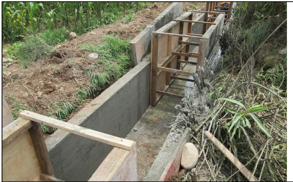
Foto 07 Vaciado Y Encofrado Monolítico De La Toma De Yanamucllo
