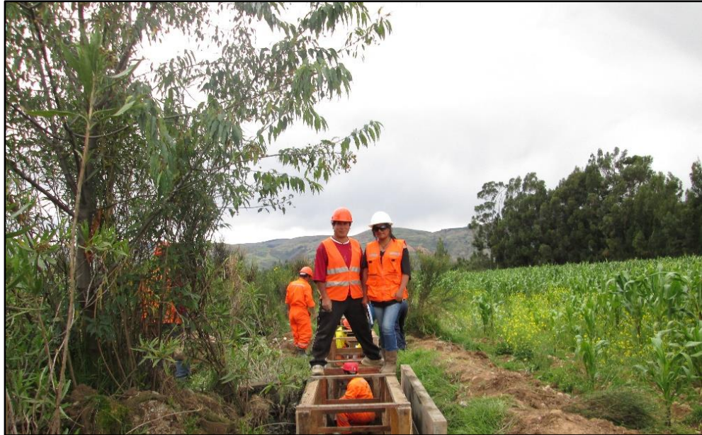
Foto 06 Encofrado Monolítico De Toma De Maravilca
