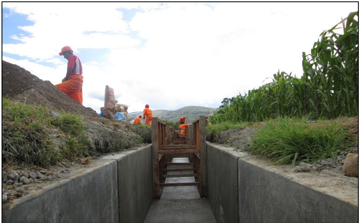
Foto 17 Toma Yanamuclo Vaciado Y Encofrado Monolítico
