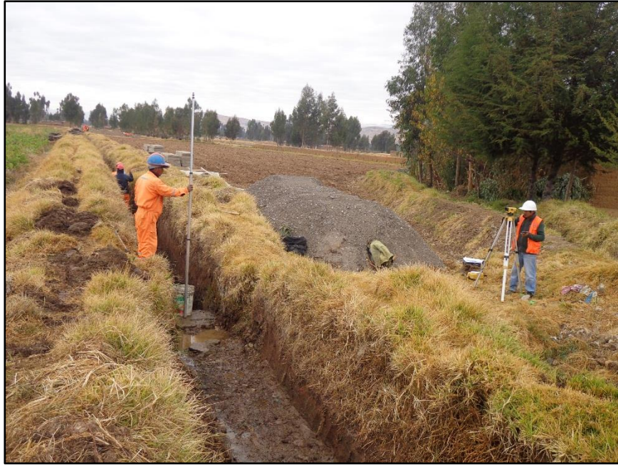
Foto 24 toma 08 verificación del compactado
