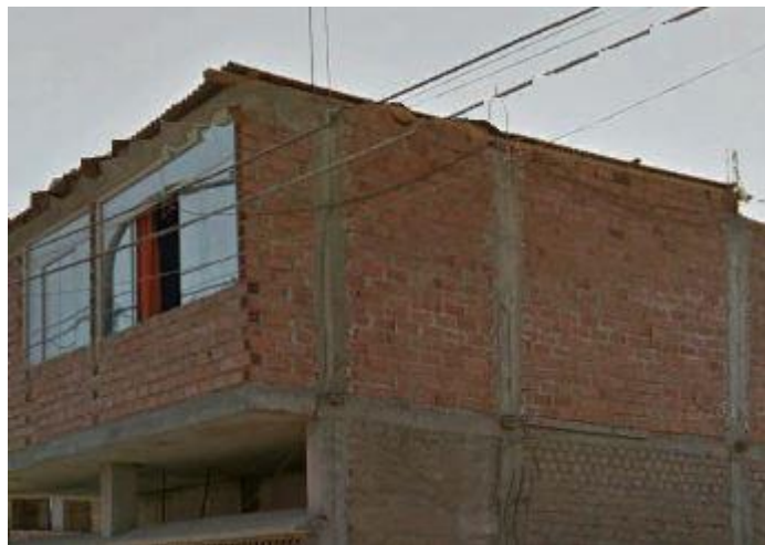
Figura 21. Cambio de calidad de albañilería
