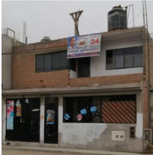
Figura 23. Fachada de vivienda.
