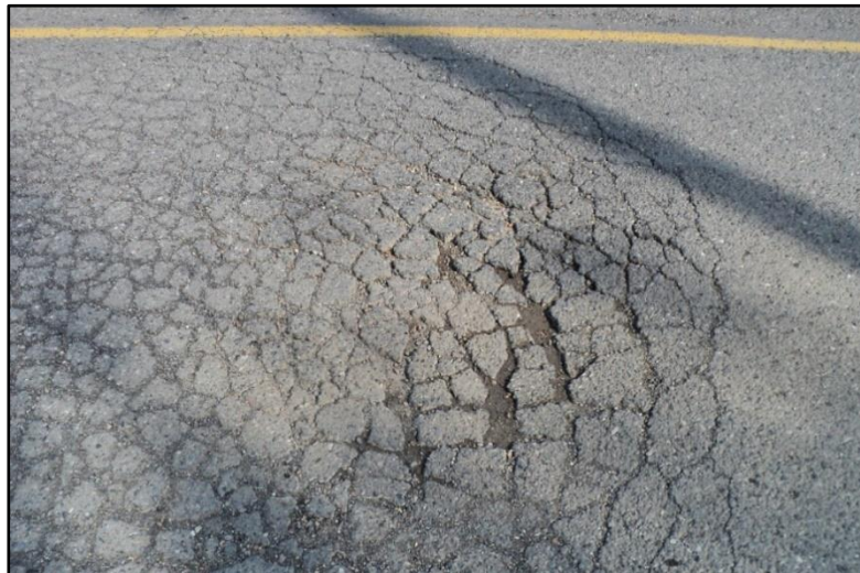
Figura 4 Piel de cocodrilo Fuente: Elaboración Propia
