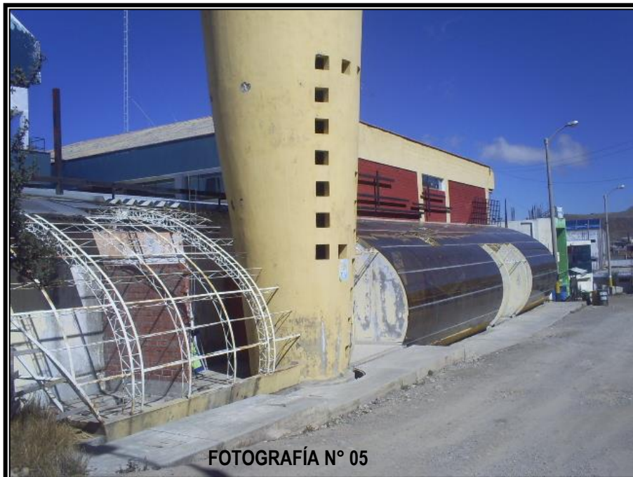
VISTA DE LOS LABORATORIOS EN PROCESO DE CONSTRUCCIÓN
