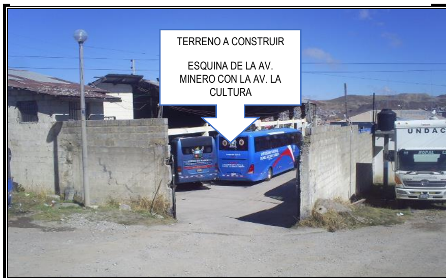
Figura 3 Exterior del terreno a demoler para la ejecución del proyecto
