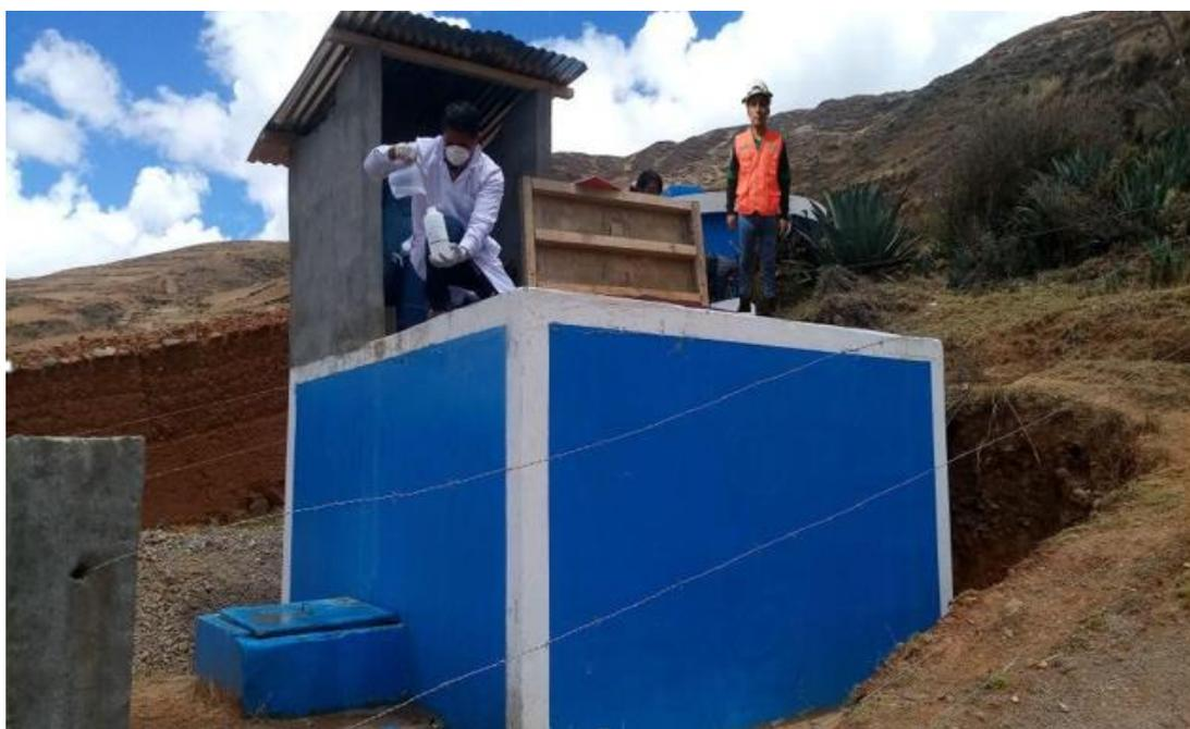
**FOTO N° 02: EL PERSONAL DEL LABORATORIO, CASANDO LAS MUESTRAS PARA LLEVAR AL LABORATORIO, A LA VEZ SE VE EL AVANCE DE LA CASETA DEL SISTEMA DE CLORACION POR GOTEO**
