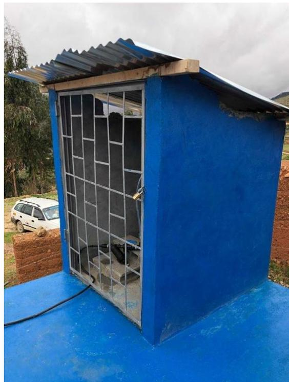
**FOTO N° 04: CULMINACION DE LA CASETA PARA LA COLOCACION DEL SISTEMA DE CLORACION POR GOTEO**
