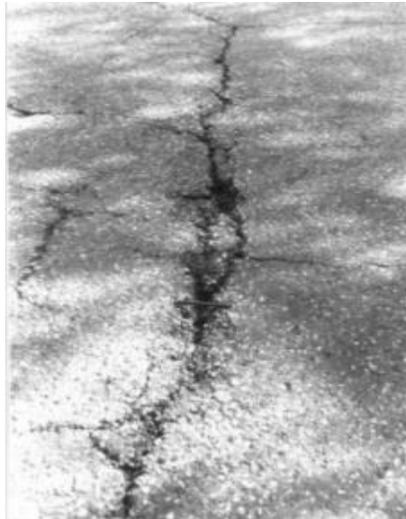
Figura 14. Imagen de Fisura Longitudinal
