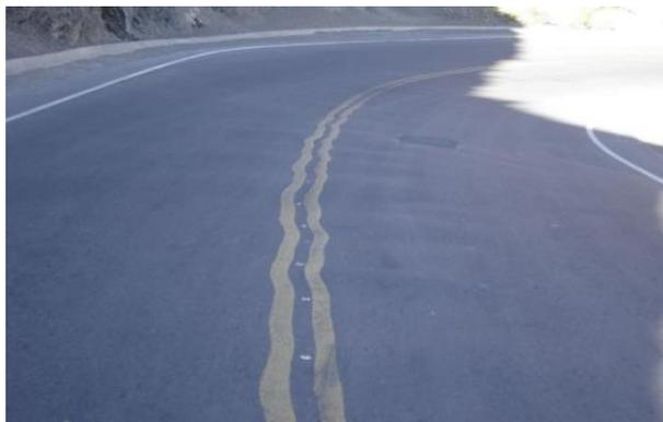
Figura 12. Imagen de hundimiento en una Carretera
