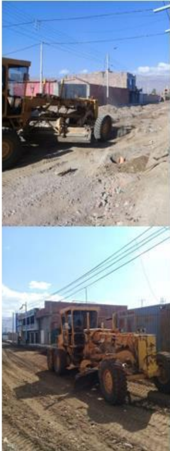
03.01.03 ROTURA Y REPOSICION PAVIMENTO ASFALTICO E=2" +CONCRETO 6" (PARCHE)
