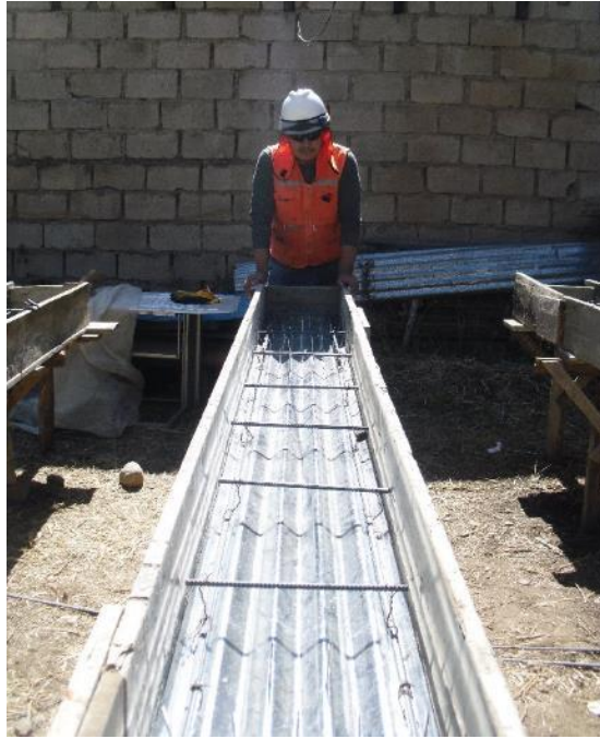
Armado de las losas macizas unidireccionales con planchas metálicas de sección ondulada.
