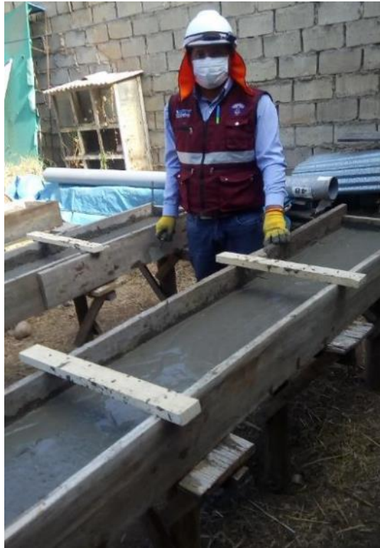
Vaciado de probetas estructuradas (losas macizas).
