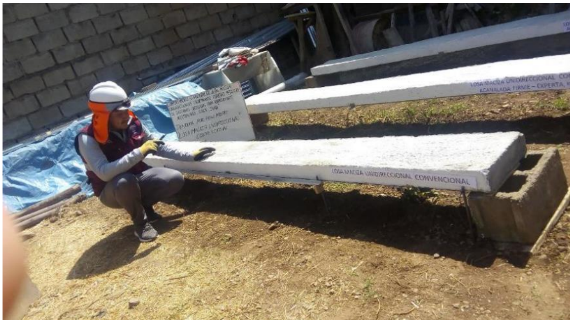
Control de resistencia a la deflexión inicial por peso propio.
