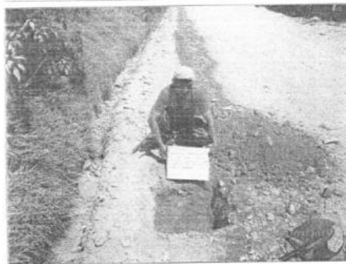
FOTO 11: SE OBSERVA LA EXCAVACION CALICATA C-06.
