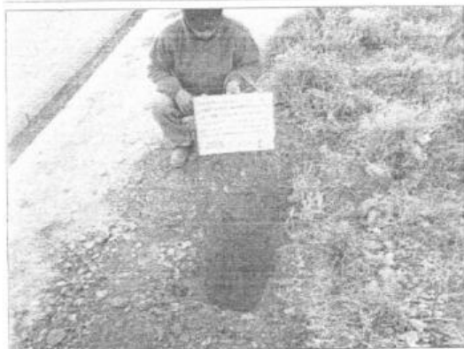
FOTO 01: SE OBSERVA LA EXCAVACION CALICATA C-01.
