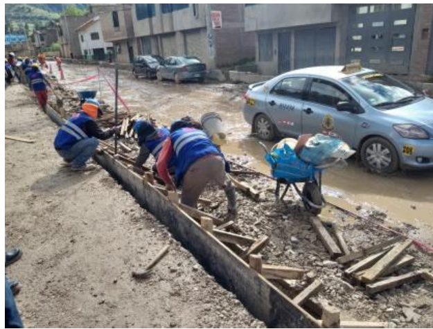
Figura 15. Encofrado de las obras de arte de la carretera Fuente: Elaboracion Propia
