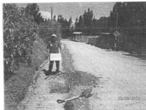
FOTOS 12: SE OBSERVA UNA VISTA PANORÁMICA DE LA EXCAVACION DE LA CALICATA C-06.
