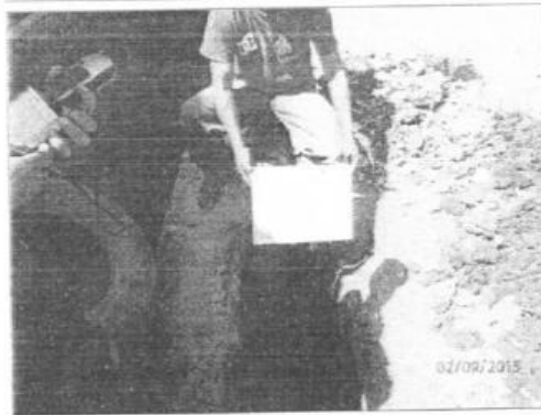
FOTO 09: SE OBSERVA LA EXCAVACION CALICATA C-05.
