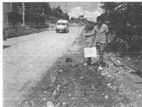
FOTOS 14: SE OBSERVA UNA VISTA PANORÁMICA DE LA EXCAVACION DE LA CALICATA C-07.
