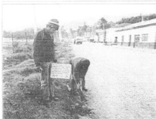
FOTO 05: SE OBSERVA LA EXCAVACION CALICATA C-03.
