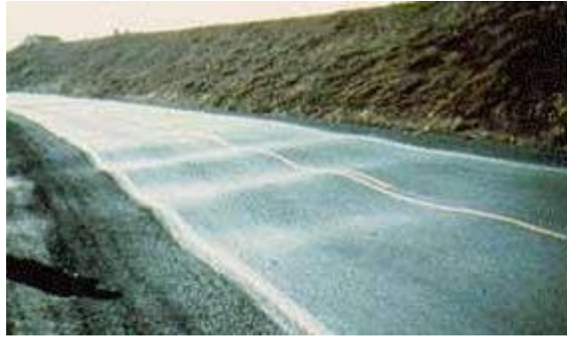
Figura 12. Imagen de Hinchamiento de un Pavimento Tomado de “diseño de carreteras” curso virtual (2015) [digital]. Recuperado de http://.eduvirtual/gnss/.org/? /pág./592
