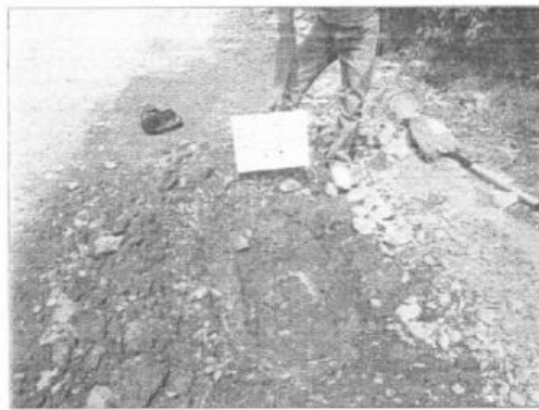
FOTO 13: SE OBSERVA LA EXCAVACIÓN CALICATA C-07.
