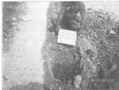
FOTO 15: SE OBSERVA LA EXCAVACION CALICATA C-08.
