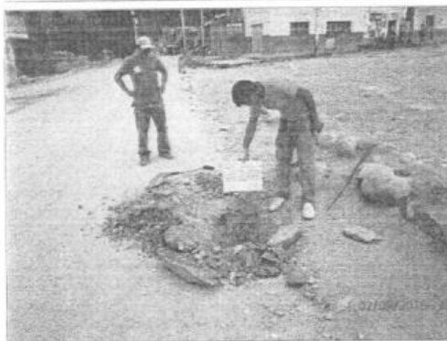
FOTO 17: SE OBSERVA LA EXCAVACION CALICATA C-09.
