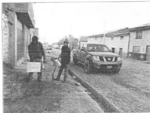
FOTOS 02: SE OBSERVA UNA VISTA PANORAMICA DE LA EXCAVACION DE LA CALICATA C-01.
