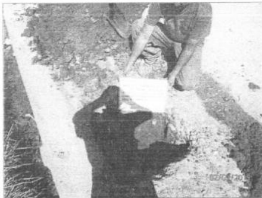
FOTO 07: SE OBSERVA LA EXCAVACION CALICATA C-04.
