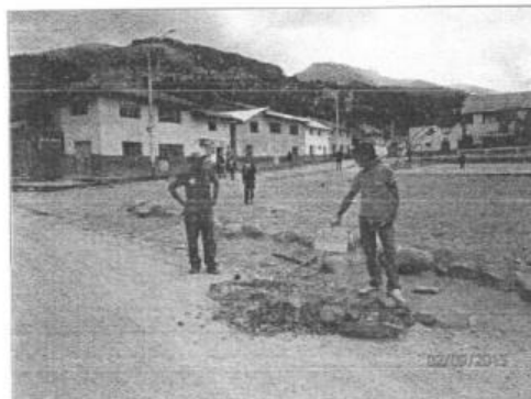
FOTOS 18: SE OBSERVA UNA VISTA PANORAMICA DE LA EXCAVACION DE LA CALICATA C-09.
