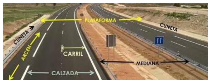
Figura 6. Imagen de una Calzada Tomada de (Cardenas, Fundamentos de vias de comunicacion y Carreteras, 2014)
