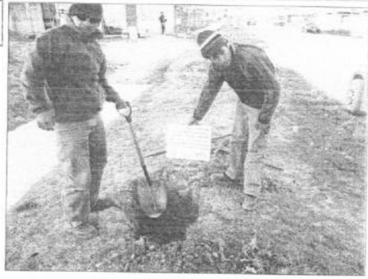
FOTO 03: SE OBSERVA LA EXCAVACION CALICATA C-02
