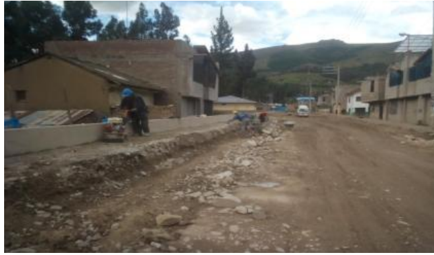
Figura 14. Limpieza del terreno para la compactacion Fuente: Elaboracion Propia
