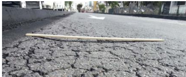
Figura 8. Imagen de desniveles en pavimentos Tomada de (Cardenas, Fundamentos de vias de comunicacion y Carreteras, 2014)
