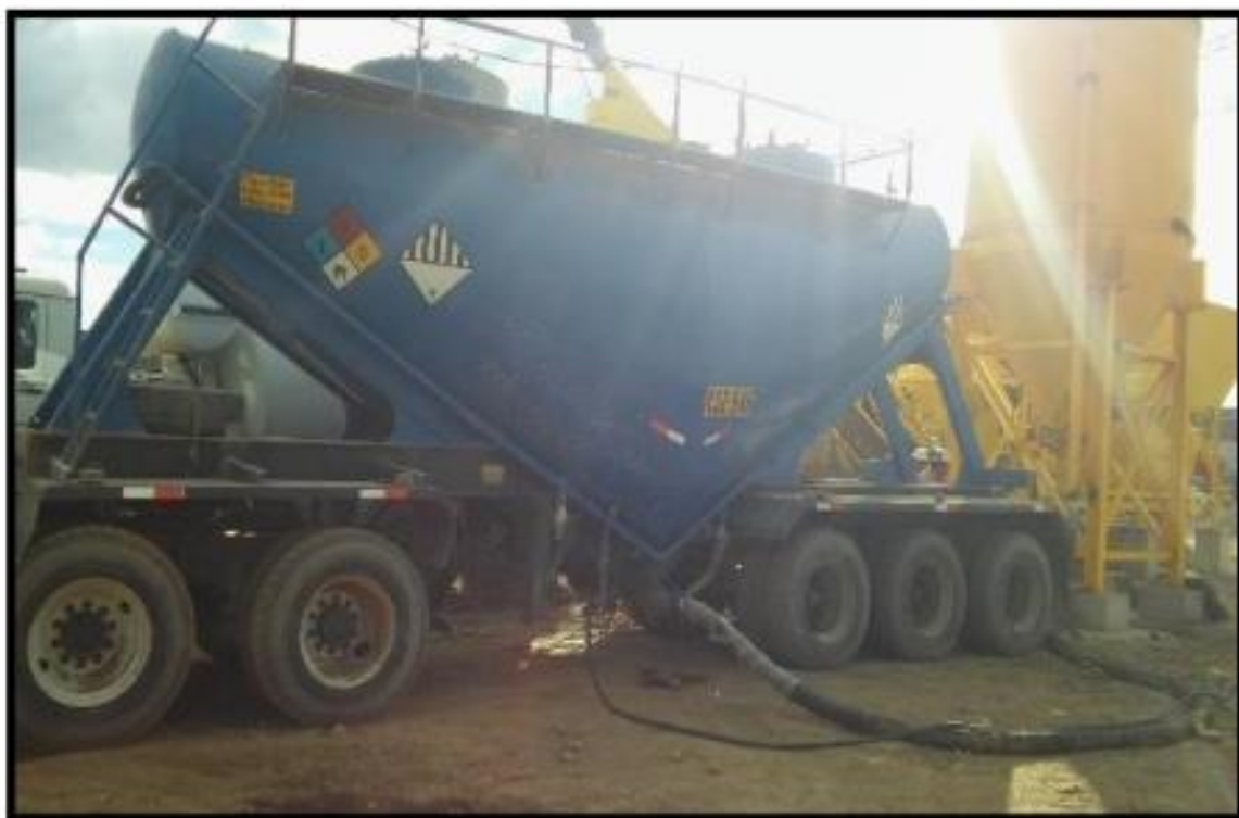
FIGURA N° 03: Abastecimiento de cemento a granel en planta de concreto, Colegio Santa Isabel.
