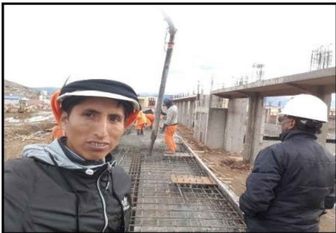
FIGURA N° 11: Bombeo del concreto en graderías, Colegio Santa Isabel.
