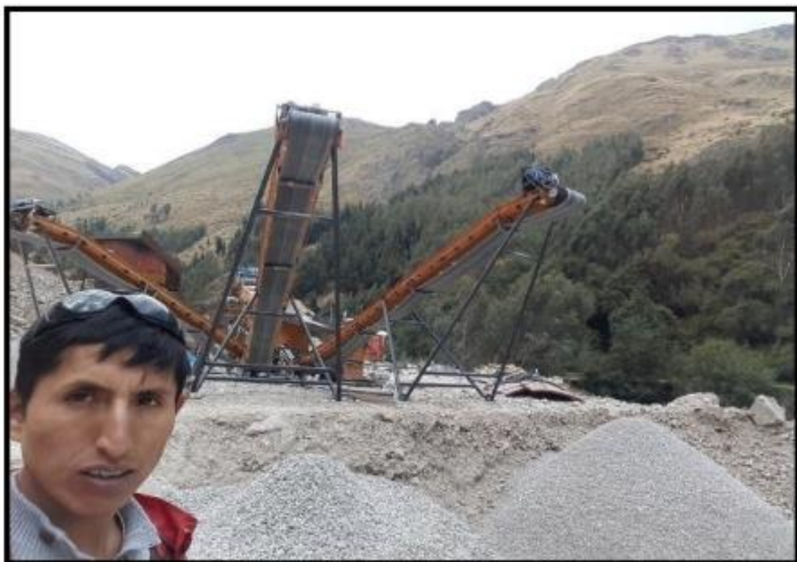
FIGURA N° 01: Verificación de la cantera de piedra chancada.
