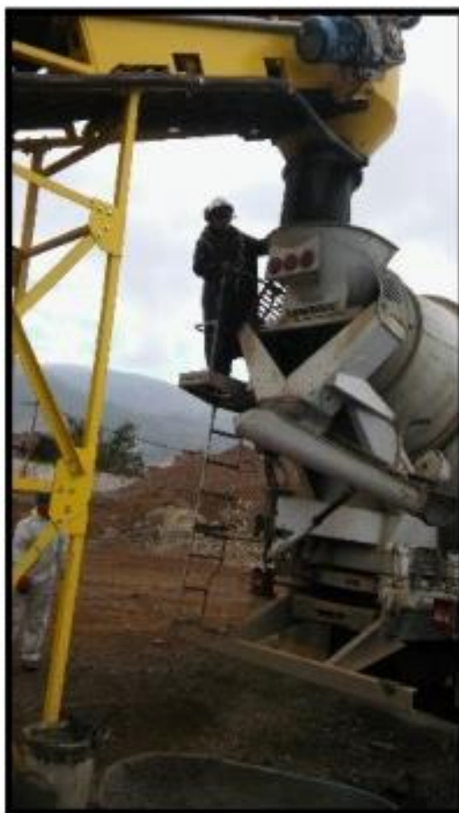
FIGURA N° 06: Inspección visual del concreto en mixer, Colegio Santa Isabel.
