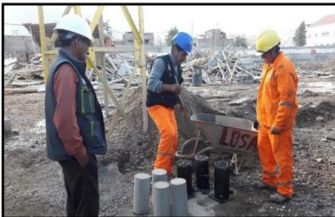
FIGURA N° 10: preparado del espécimen del concreto para el ensayo a compresión, Colegio Santa Isabel.
