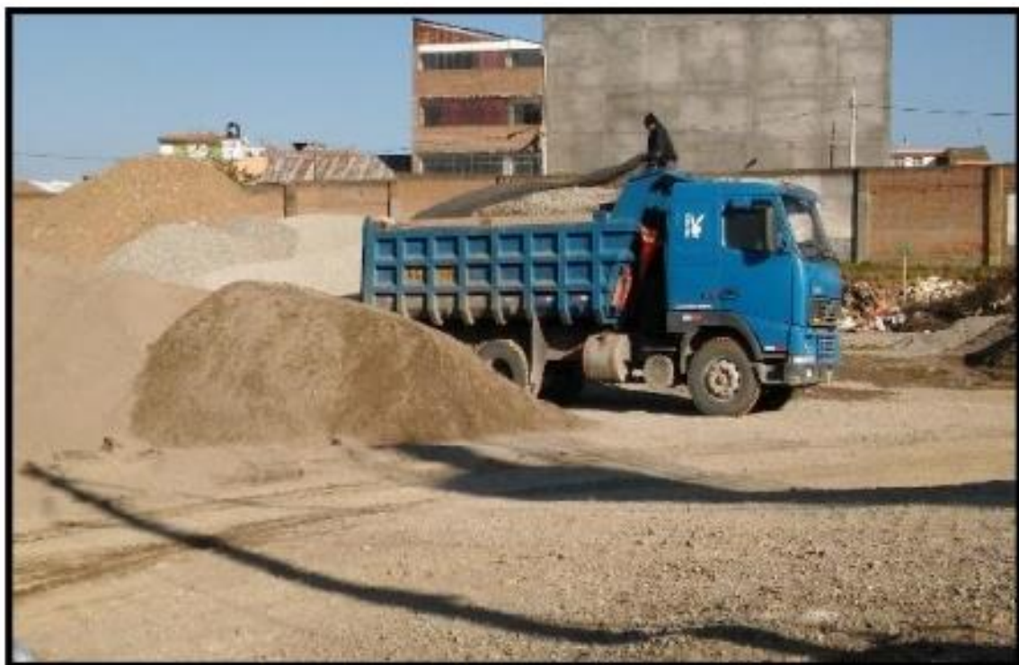
FIGURA N° 02: Abastecimiento de agregados en planta de concreto, Colegio Santa Isabel.
