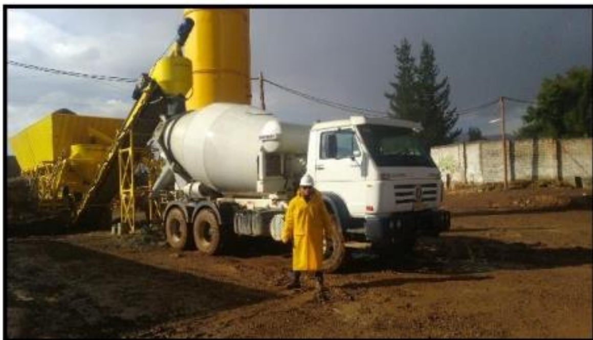
FIGURA N° 05: Preparado de concreto premezclado en planta de concreto, Colegio Santa Isabel.
