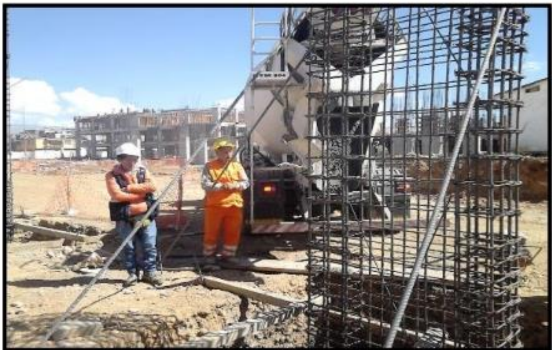
FIGURA N° 12: colocado directo de concreto en zapatas, Colegio Santa Isabel.
