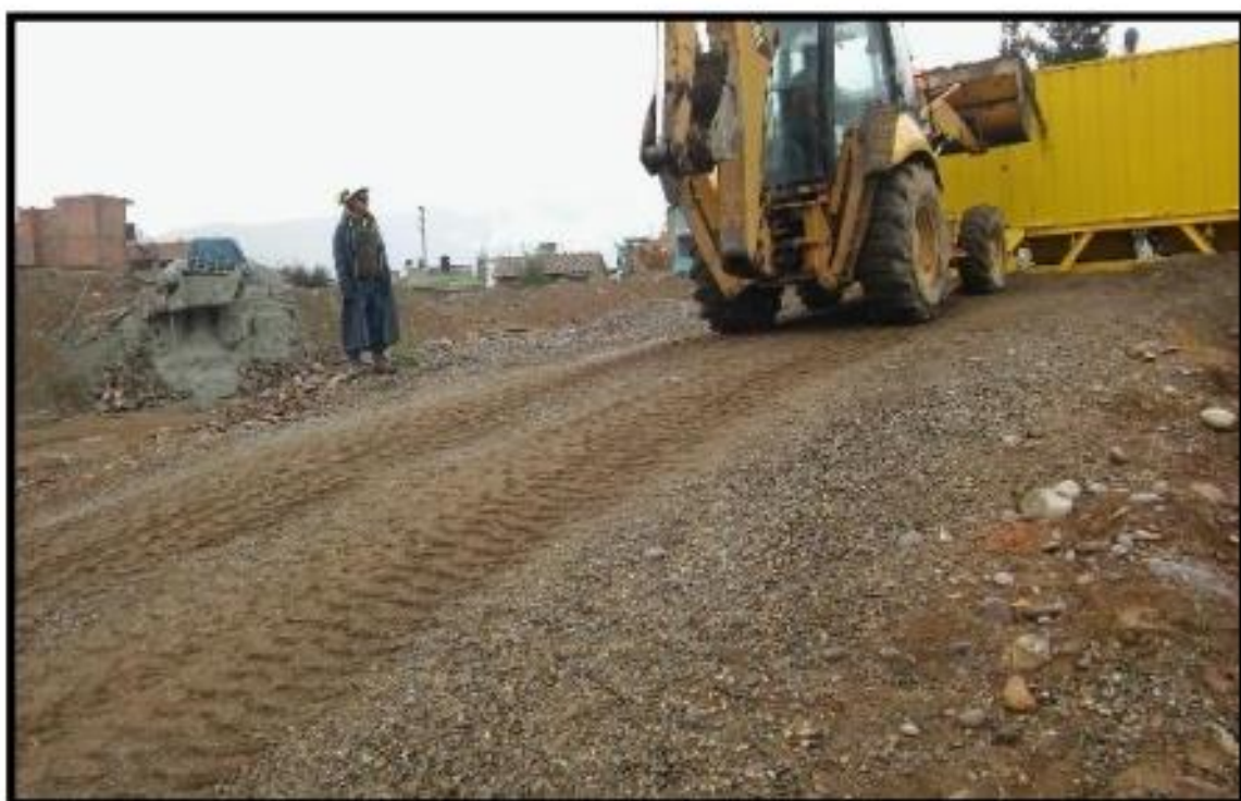
FIGURA N° 04: Abastecimiento de agregados en planta de concreto, Colegio Santa Isabel.
