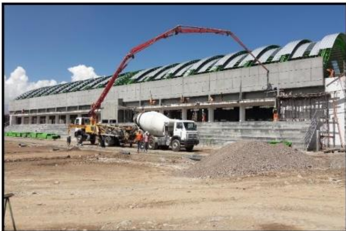
FIGURA N° 13: Colocado de concreto en mensulas , Colegio Santa Isabel.
