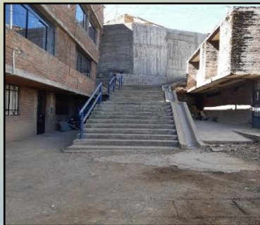
INGRESOS PEATONALES INADECUADOS
