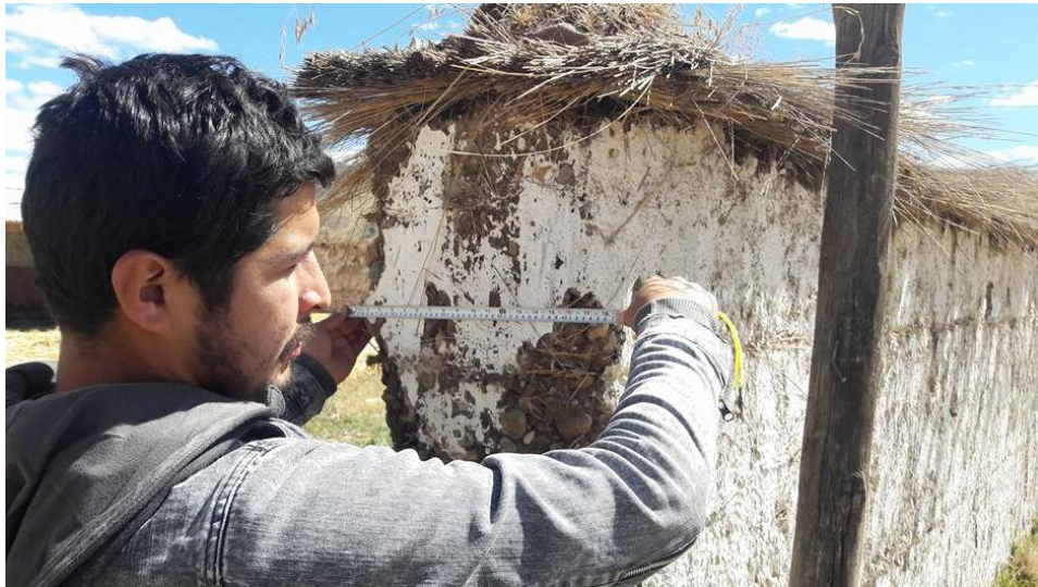
FOTO 11. Medida de los anchos de los muros de las viviendas
