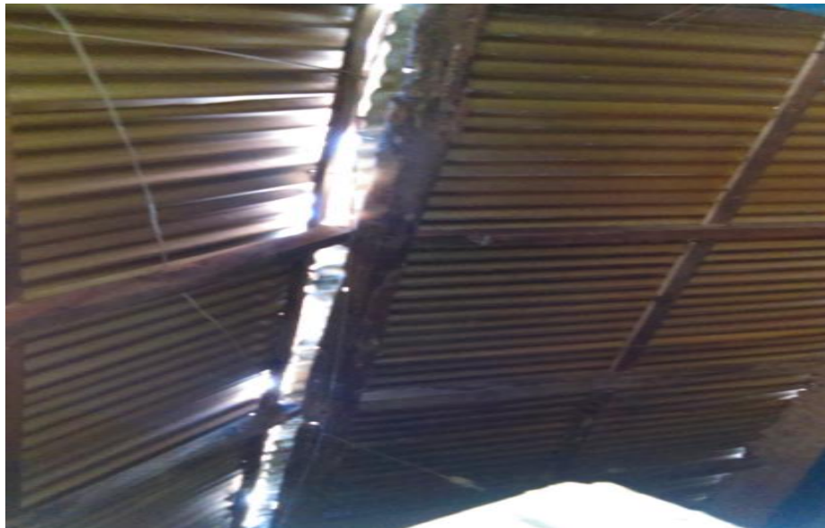
FOTO 12. Características de los techos inclinados y reconocimiento del tipo de material de construcción
