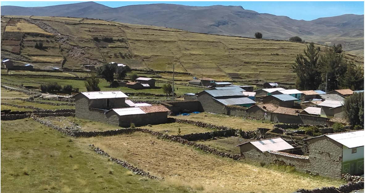
FOTO 2. Vista de las viviendas más alejadas del distrito de Yanacancha
