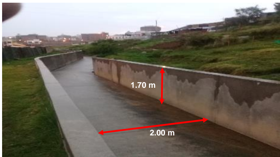
Foto 1: Curso de quebrada por un canal de concreto-Sector 01
