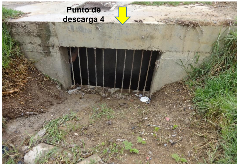
Foto 9: Punto de descarga 4 de todas las quebradas.
