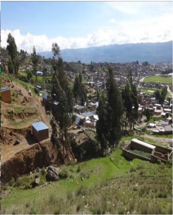
Foto 14: Viviendas asentadas al borde de quebradas Sector 02
