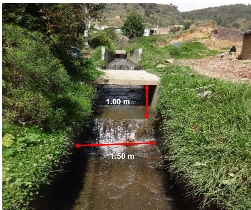
Foto 5: Curso de quebrada 01 por un canal de concreto-Sector 02
