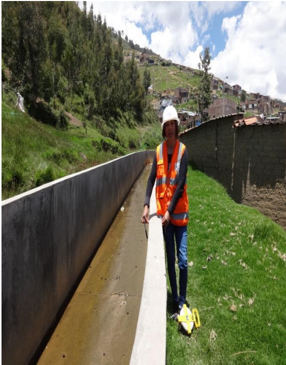
Foto 11: Canal de drenaje de 2.00 x 1.70 m Quebrada modificada-Sector 01
