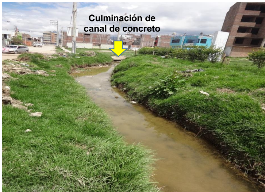
Foto 4: Canal de tierra de quebrada que continua hasta el río Florido
