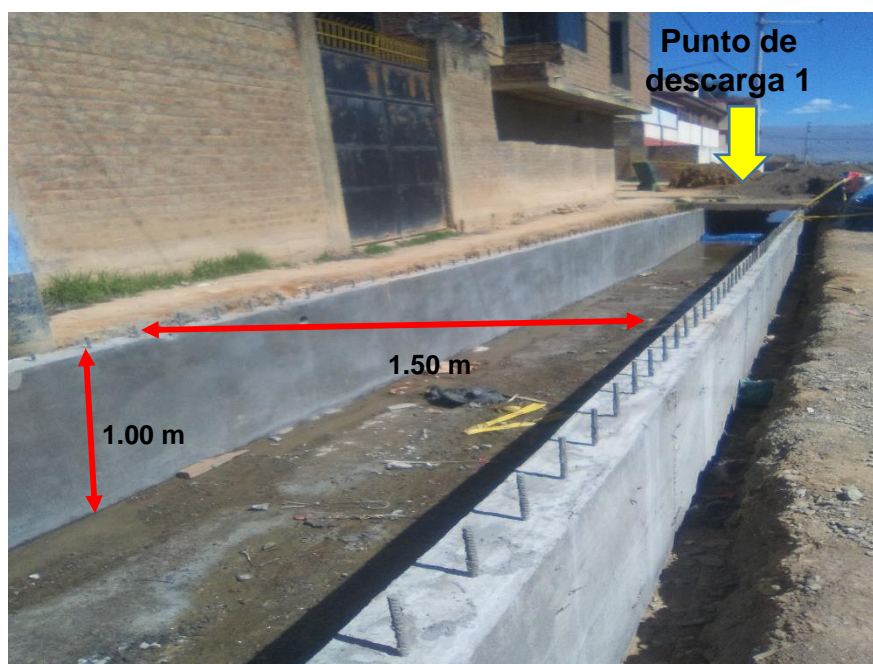
Foto 6: Construcción de canal de concreto de quebrada 01-Sector 02
