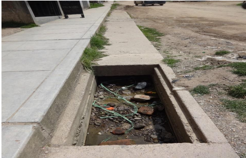
Foto 3: Trayecto de la escorrentía de la quebrada por canal de Concreto-Sector 01
