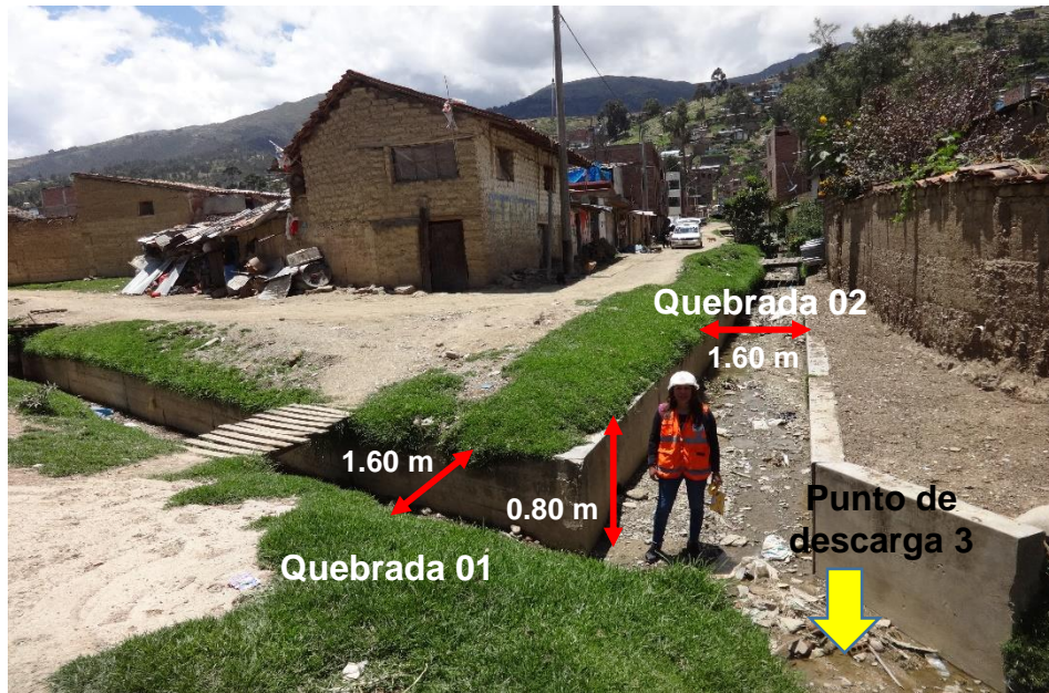
Foto 10: Punto de descarga 3 de todas las quebradas.
