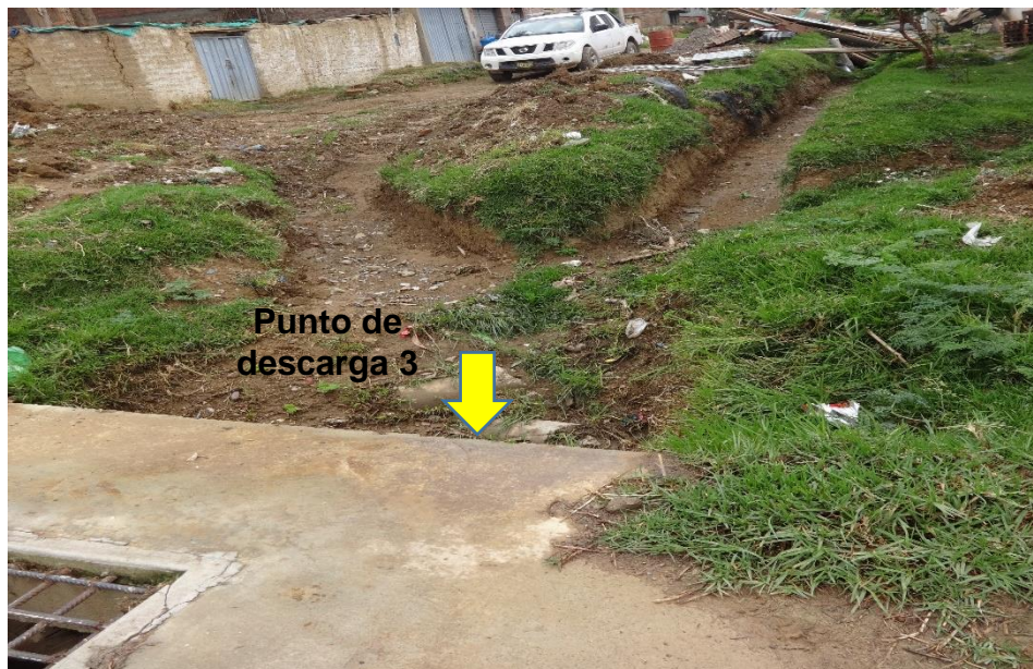
Foto 8: Punto de descarga de la quebrada 3
