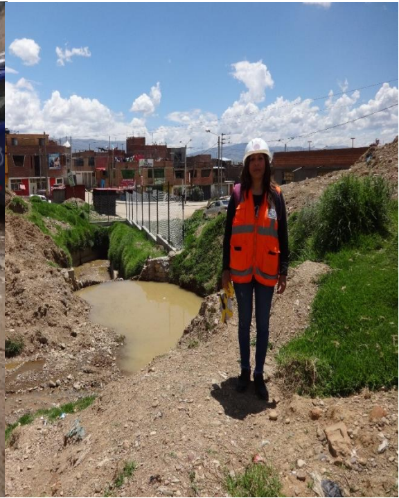
Foto 16: Sección disminuida a 1.50 x 1.00 m Sector 02
