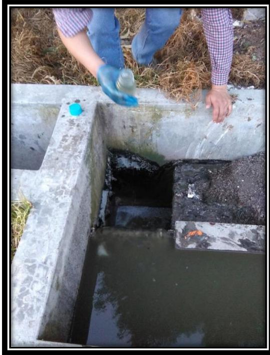
FOTO N°6 LECHO DE SECADO DEL TANQUE IMHOFF
