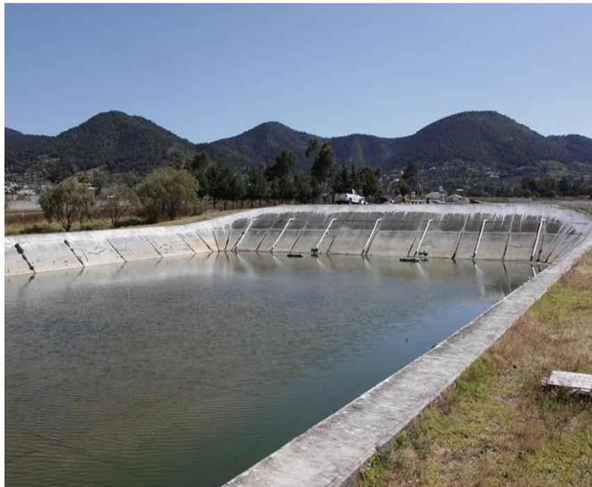
**Figura N°22** Laguna de Estabilización
