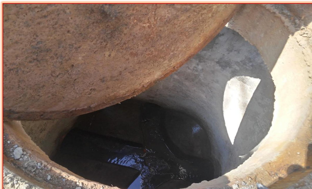
Medición de altura de buzón N°05
