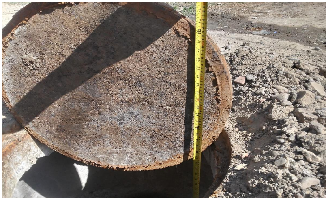
Medición de altura de buzón N°01
