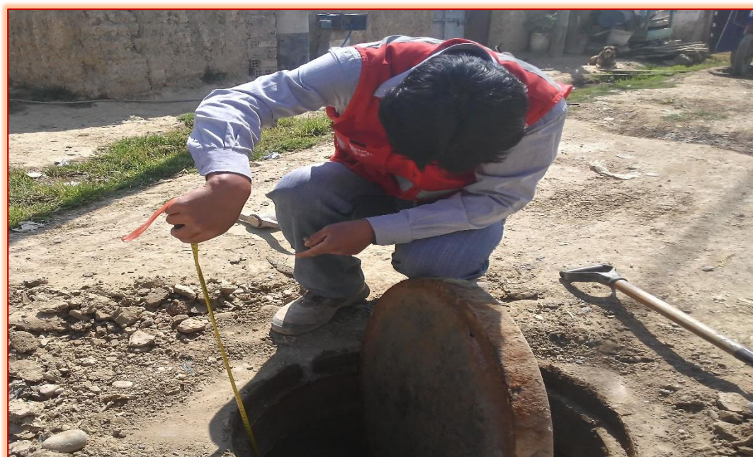
Medición de altura de buzón N°03
