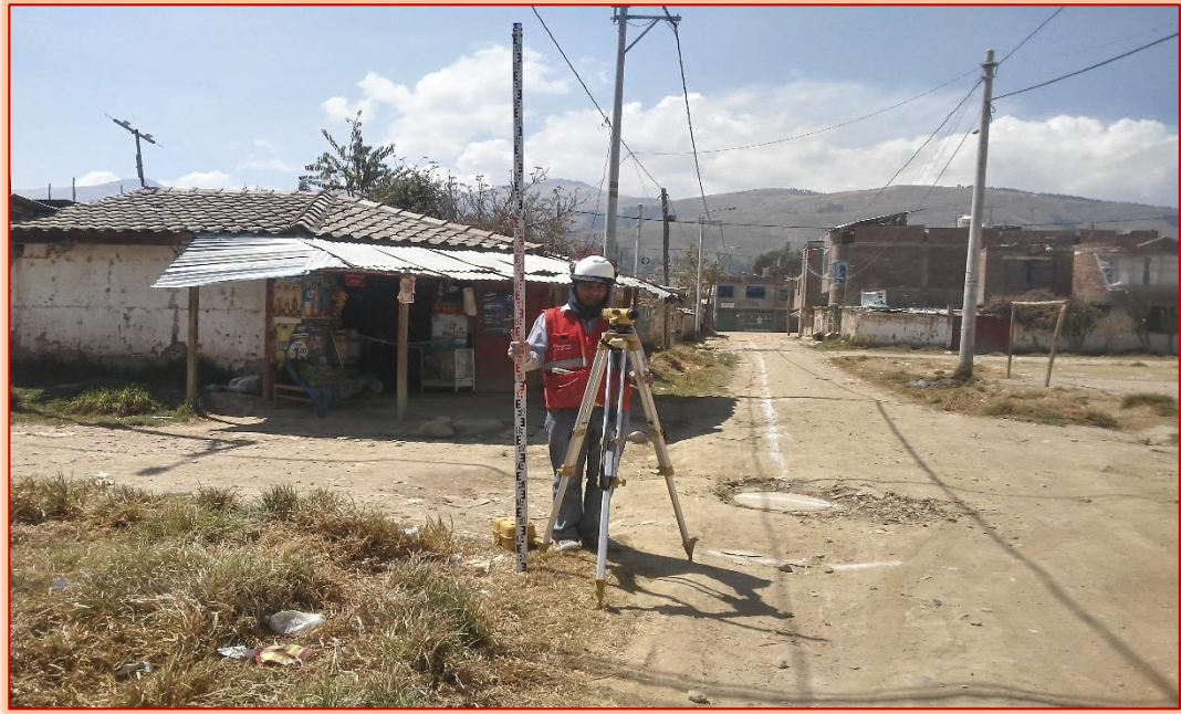
Inicio de trabajos en el anexo Ancalahuata equipos de medición
