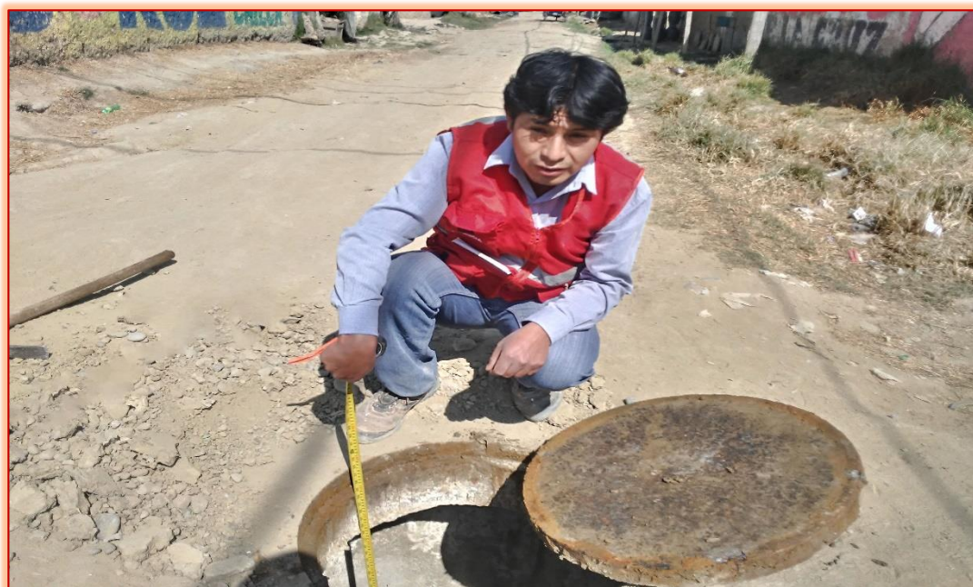
Medición de altura de buzón N°02
