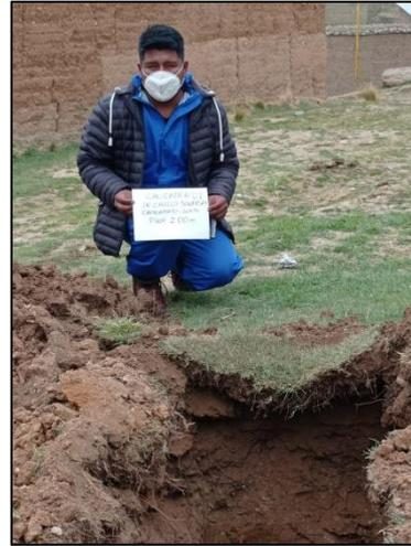
Fotografía 5 y Fotografía 6. Vista de calicata para la toma de muestras de suelo.
