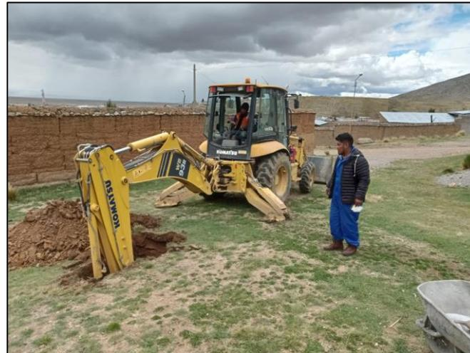
Fotografía 3 y Fotografía 4. Excavación de calicata para la toma de muestras de suelo en el jirón Carlos Sowersby.
