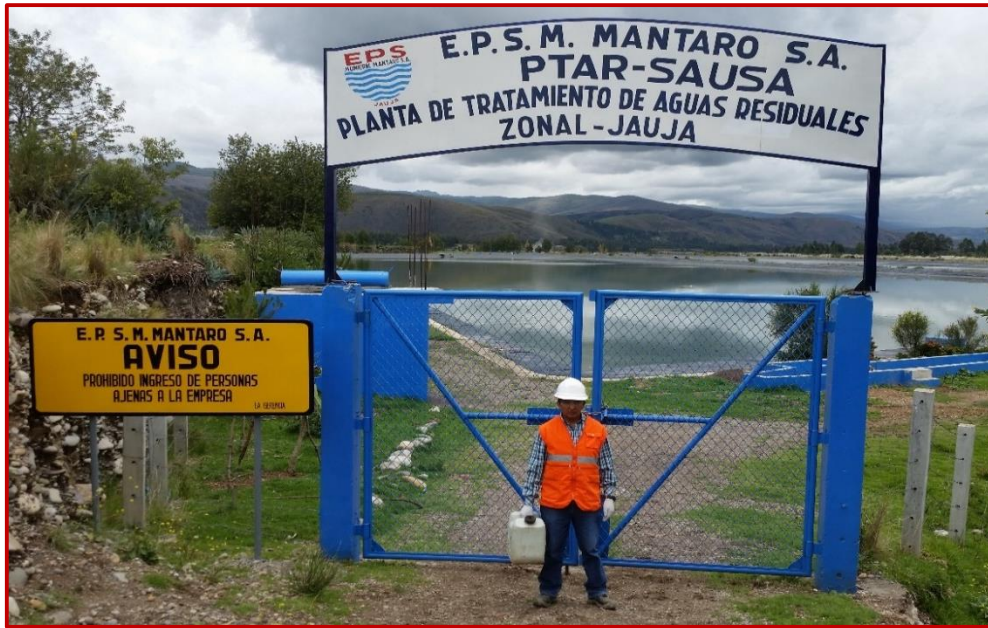
Fotografía N° 01: Visita a las instalaciones de la planta de tratamiento de aguas residuales de Jauja para la recolección de agua tratada.
