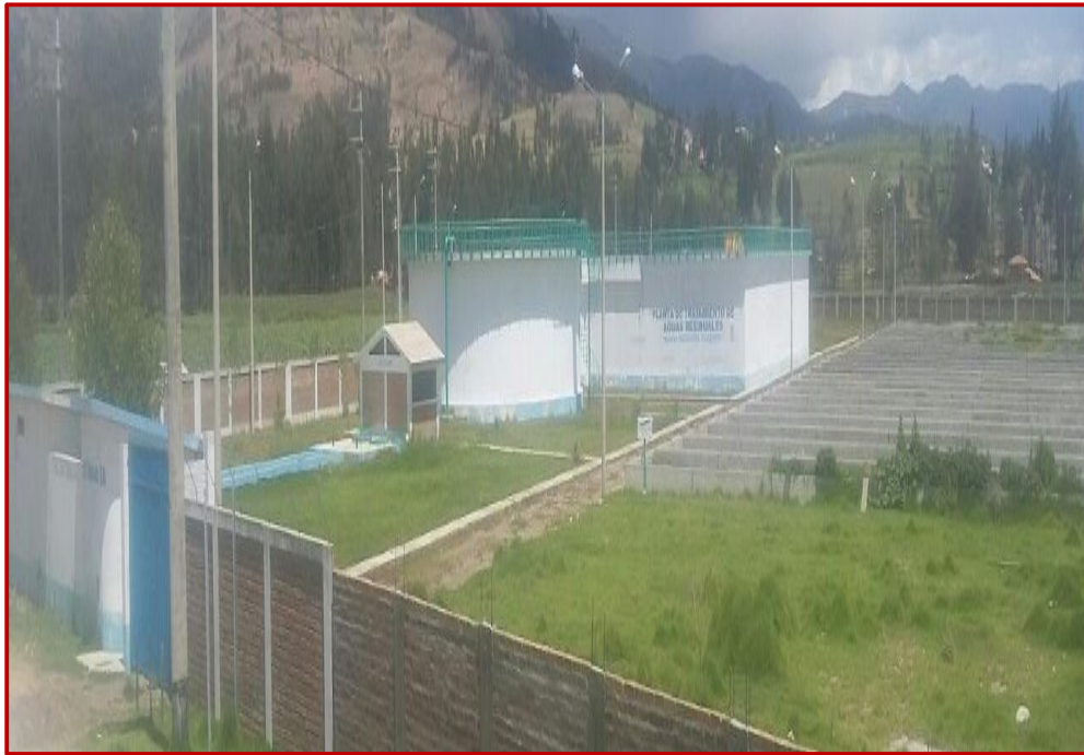
Fotografía N° 03: Visita a las instalaciones de la planta de tratamiento de aguas residuales de la provincia de Concepción para la recolección de agua tratada.
