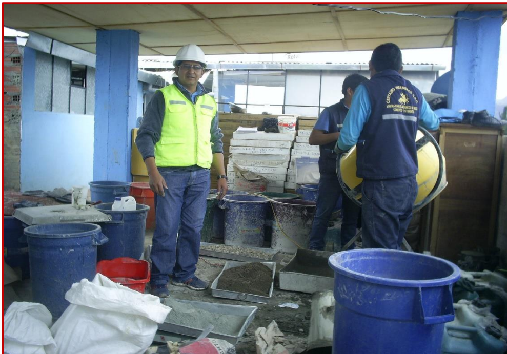
Fotografía N° 12: Elaboración de probetas en laboratorio, toma de datos de los ensayos realizados al concreto en estado fresco para su posterior análisis.
