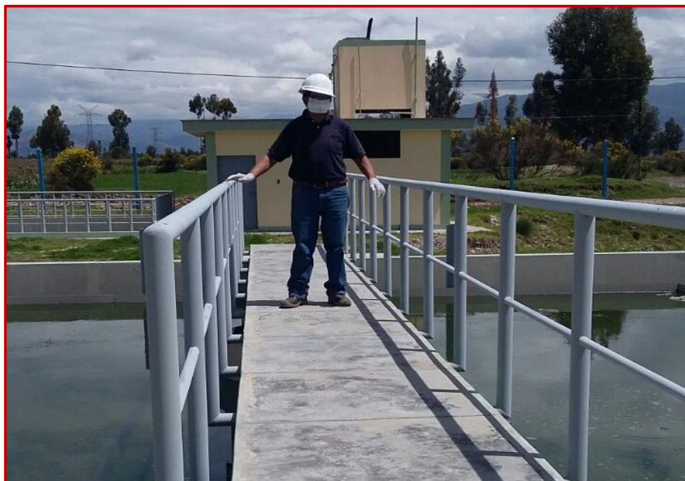
Fotografía N° 05: Visita a las instalaciones de la planta de tratamiento de aguas residuales de la provincia de Chupaca para la recolección de agua tratada.
