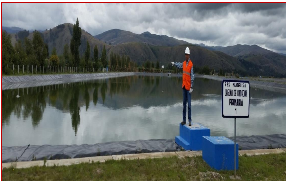
Fotografía N° 02: Identificando el punto de muestreo para la recolección de agua tratada de la planta de tratamiento de aguas residuales de Jauja.
