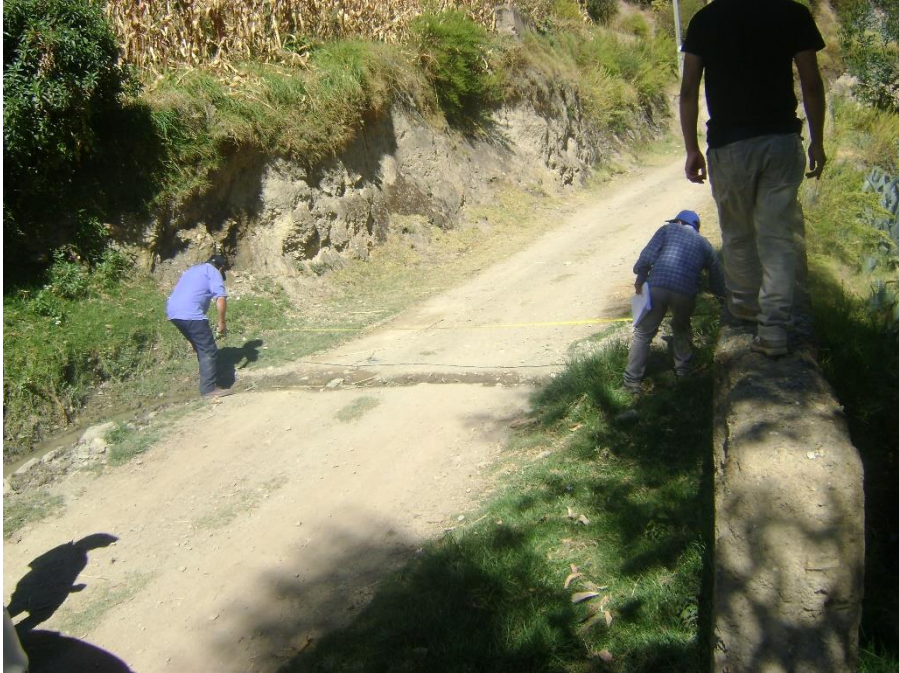
Fotografía 3. Medición de alcantarilla en la progresiva 3 + 200 km.
