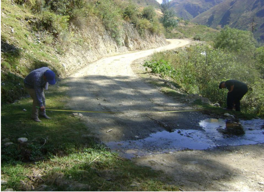
Fotografía 1. Medición en campo de las alcantarillas a proponer.
