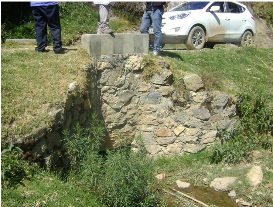
Fotografía 4. Vista de alcantarilla existente en la progresiva 2 + 456 km.
