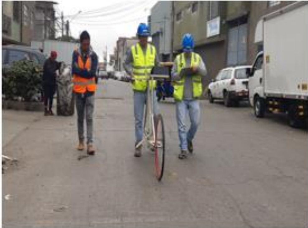
Imagen N° 31. Toma de las lecturas de la depresión y la elevación del pavimento rígido a cada 2m.
