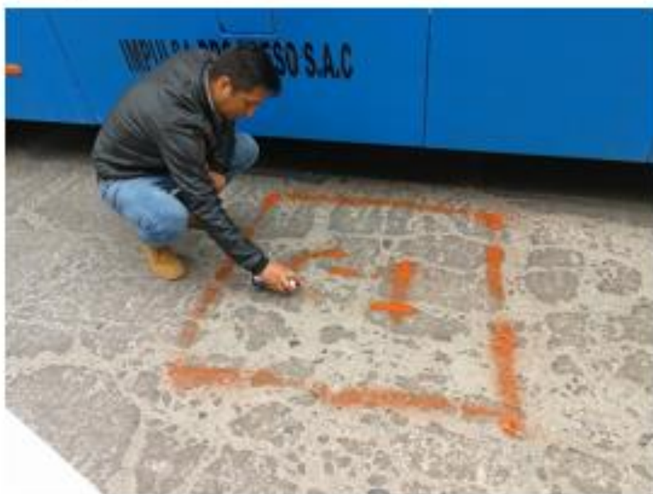
Imagen N° 19. Señalización para la calicata C-1 y extracción de muestras.
