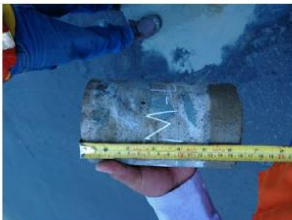
Imagen N° 14. Espesor de la extracción del testigo (diamantina) M-4 cuadra 1 en la calle Luis Galvani.
