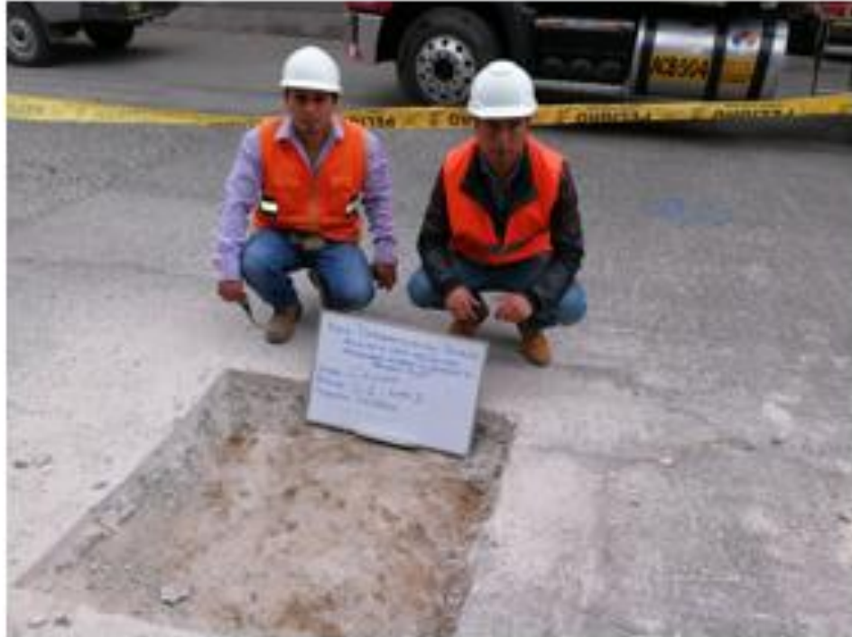
Imagen N° 21. Corte del pavimento rígido para la Extracción de muestras de la Calicata C-2 de la cuadra 3.
