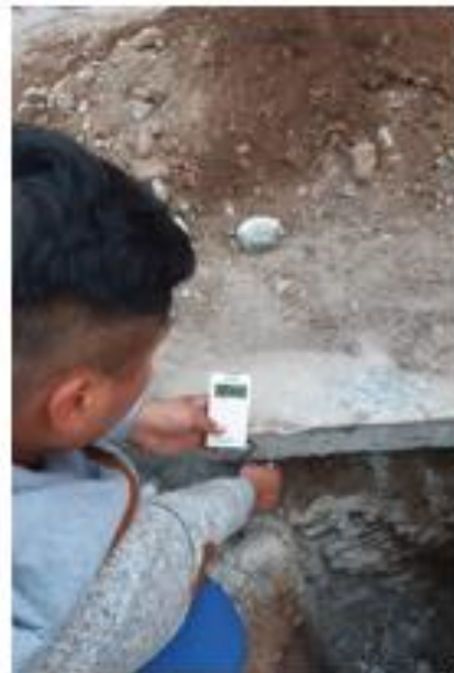
Imagen N° 34. Toma de la temperatura de la losa de concreto parte inferior (día).
