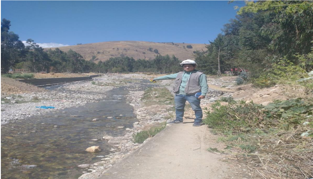
FOTO N° 09: Erosiones generadas en el rio Achamayo.
