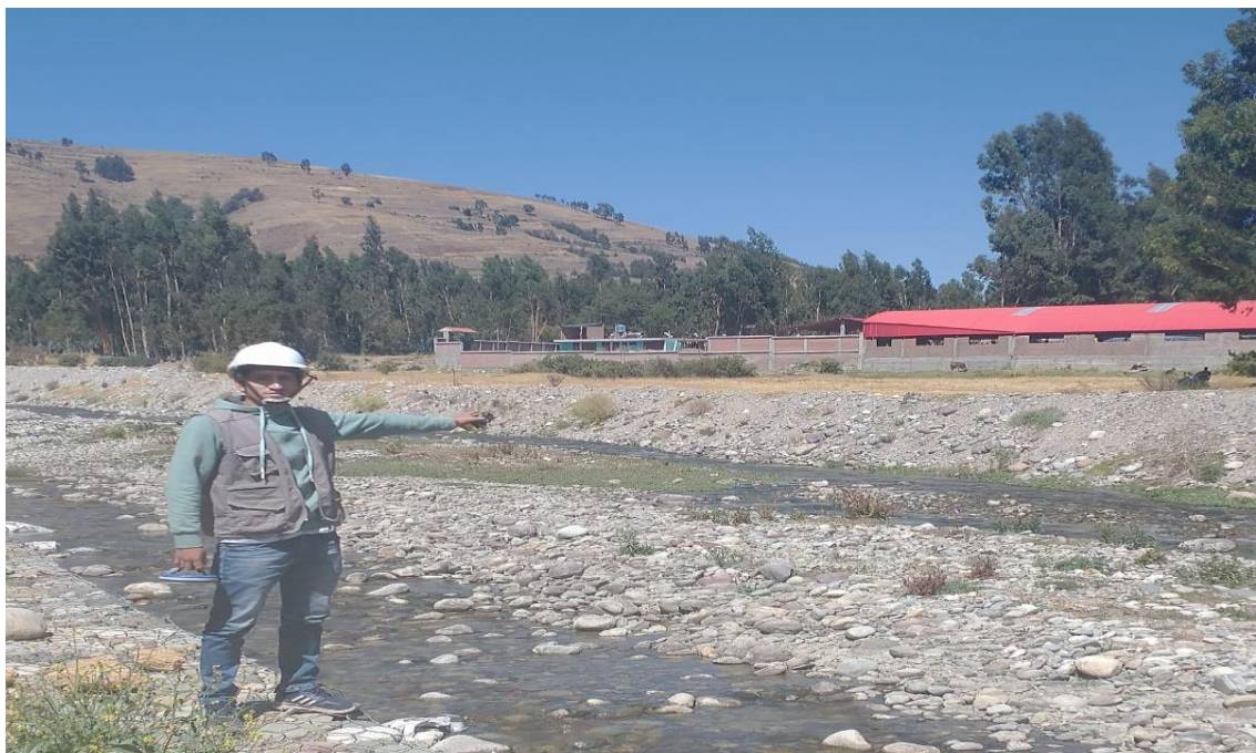
FOTO N° 08: Erosiones generadas en el rio Achamayo.
