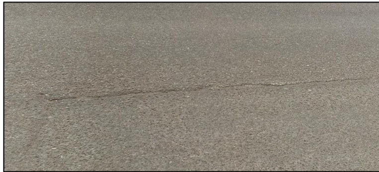
Figura N° 24. Grietas longitudinales.
