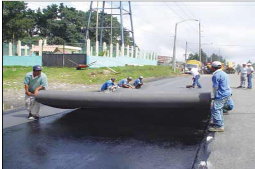
Figura N° 35. Instalación manual del geotextil no tejido.
