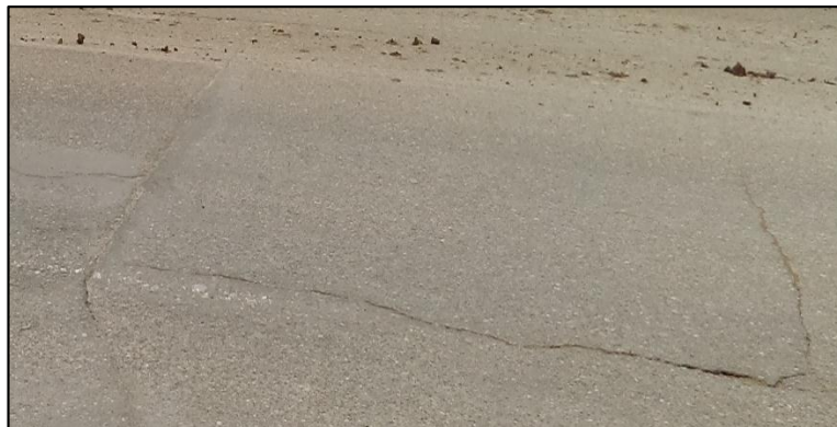
Figura N° 25. Grieta transversal.
