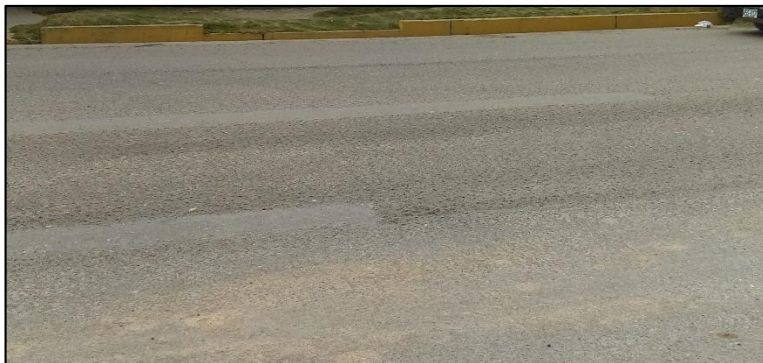
Figura N° 19. Exposición de agregados
