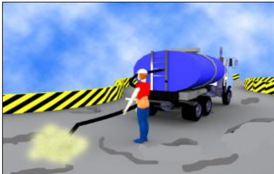
Figura N° 34.Limpieza de la superficie de rodadura.
