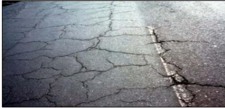
Figura N° 26. Fisuras.
