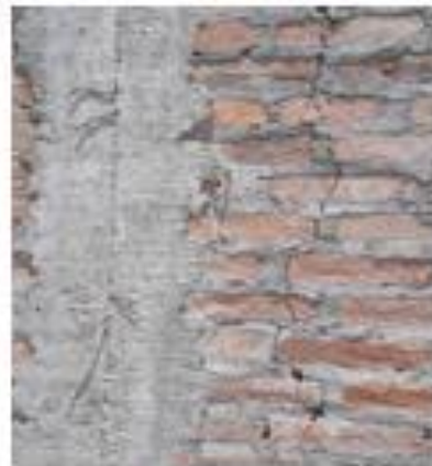
murar partentor aqrietadar
