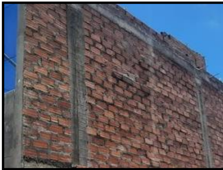
Figura 4.6 - Ladrillos pandereta usados en muros portantes del 2do nivel
