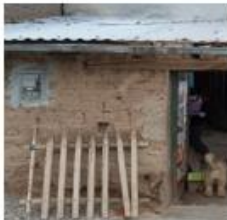
muro de adobe
