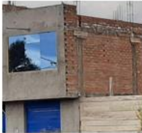
murar partitor con ladrilla pandereta
