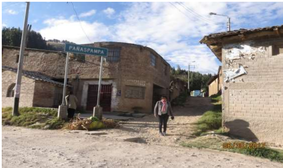
Imagen 6. 11. Las edificaciones que se encuentran al borde derecho de la carretera se encuentran en una zona de AMENAZA MEDIA – BAJA.
