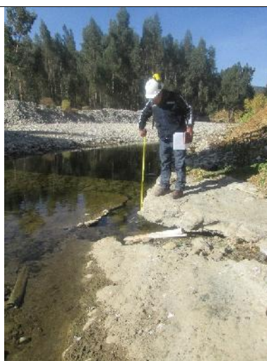
Foto 10: Muestra la toma de datos para evaluación de socavación del puente Huanchar.
