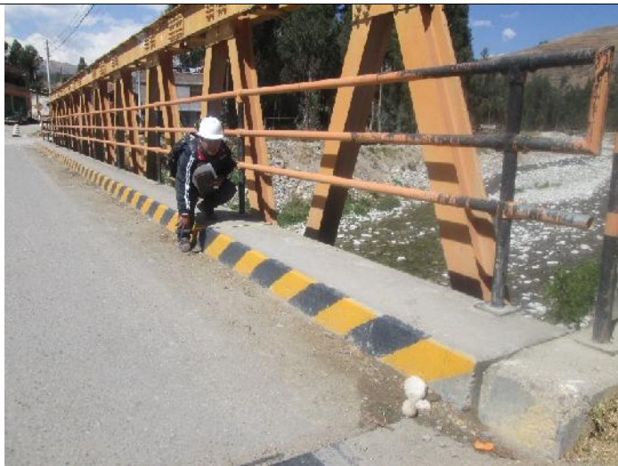
Foto 6: Muestra la toma de datos para evaluación del puente Quichuay.
