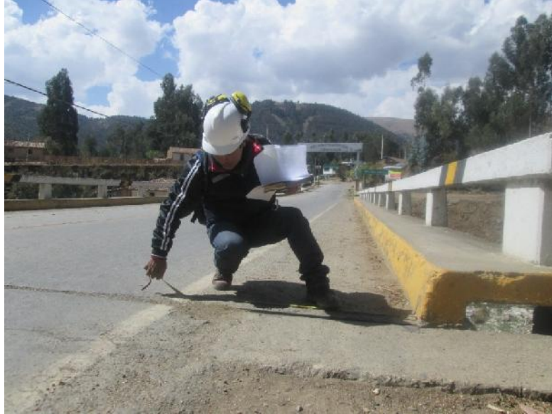
Foto 1: Se muestra toma de datos de la estructura puente Matahuasi
