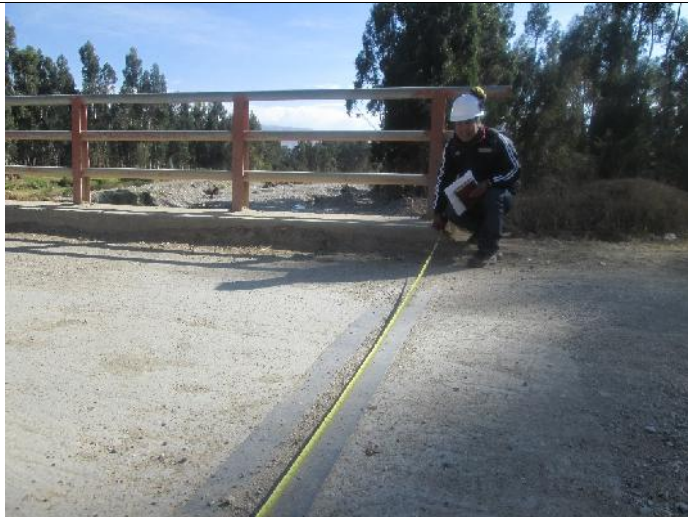
Foto 8: Muestra la toma de datos para evaluación del puente Huanchar.
