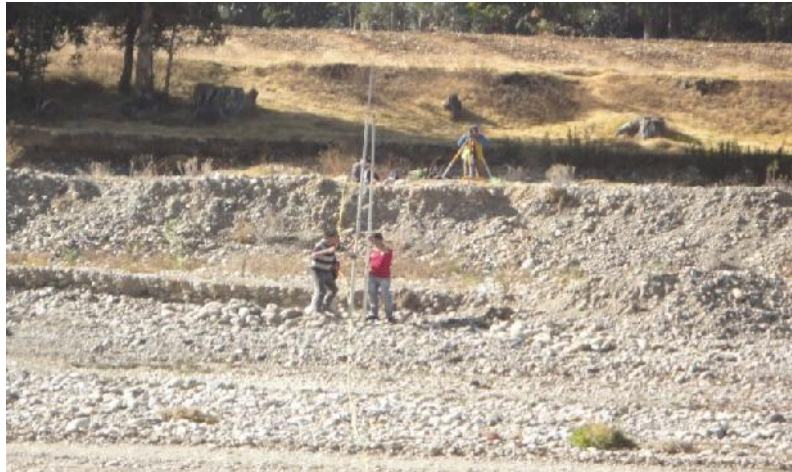
Foto 15: Trabajos de levantamiento topográfico de la sección de cauce en Rio Achamayo
