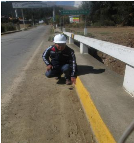
Evaluando fisuras vereda de puente
