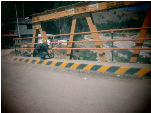
Evaluando fisuras vereda de puente
