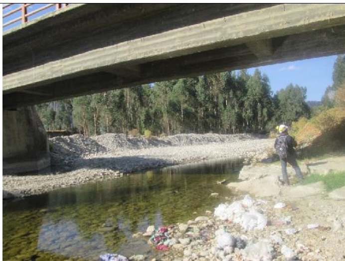
Foto 9: Muestra la toma de datos para evaluación del puente Huanchar.
