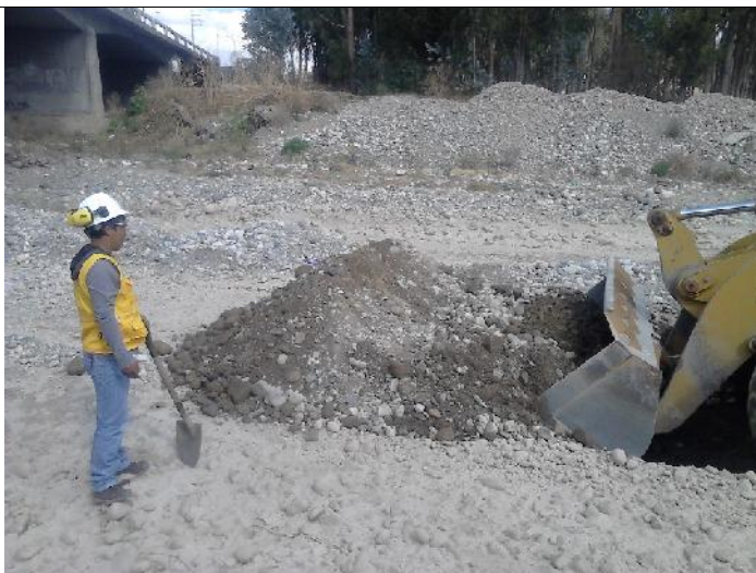
Foto 11: Excavación de calicata para toma de muestra de suelo, rio Achamayo
