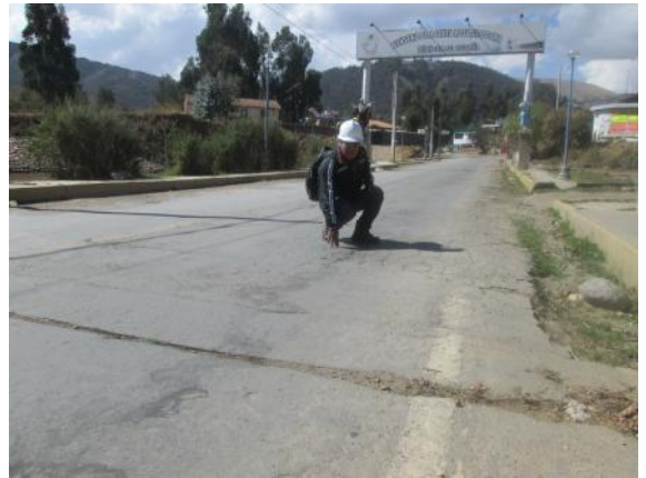
Evaluando fisuras de plataforma de puente
