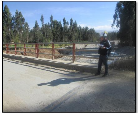
Evaluando fisuras de plataforma de puente
