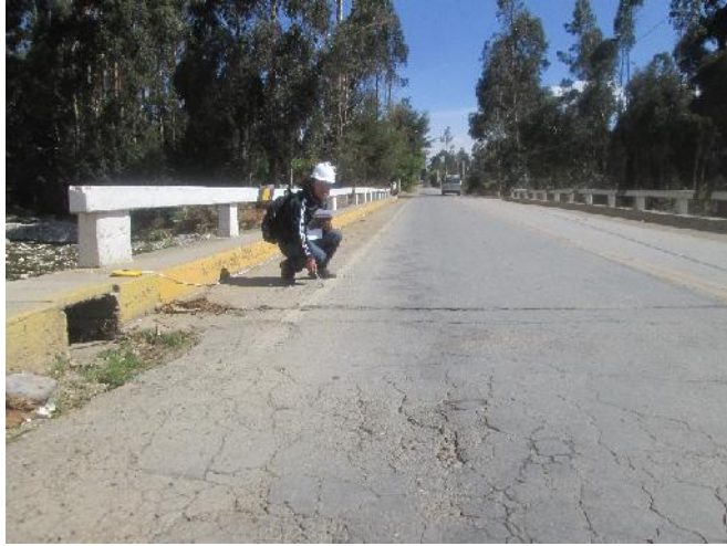
Foto 7: Muestra la toma de datos para evaluación del puente Santa Rosa de Ocopa.
