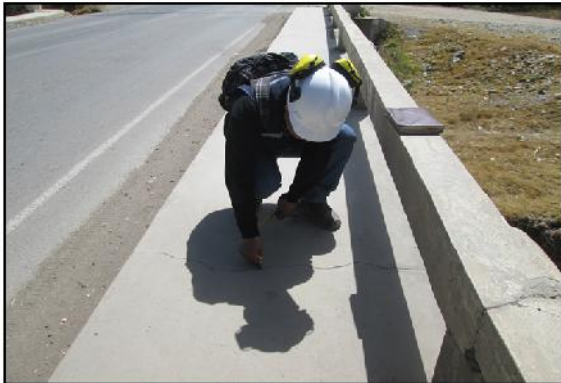
Evaluando fisuras vereda de puente
