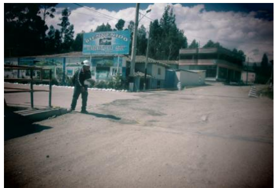
Evaluando fisuras de plataforma de puente
