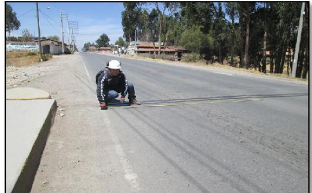
Evaluando fisuras de plataforma de puente
