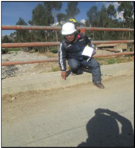
Evaluando fisuras vereda de puente
