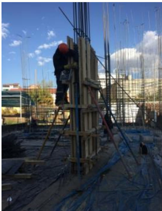
Foto N°5: Encofrado en columna.
