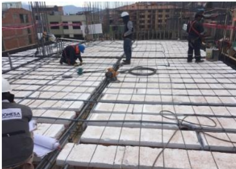
Foto N°4: Colocación de acero en temperatura.
