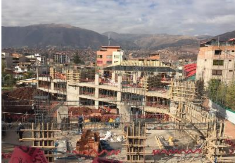
Foto N°7: Avance paralelo (Encofrado, Acero y concreto)
