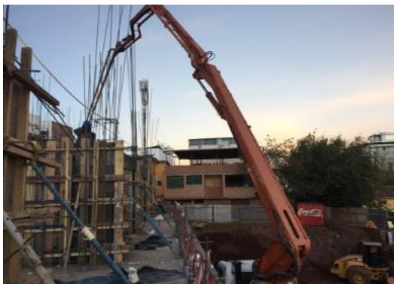
Foto N°6: Vertido de concreto en verticales.
