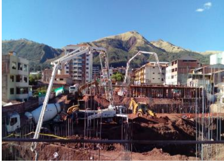
Foto N°3: Compactación y vertido de concreto.
