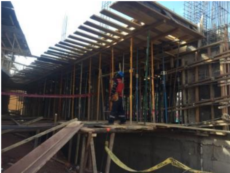
Foto N°8: Encofrado en losa.
