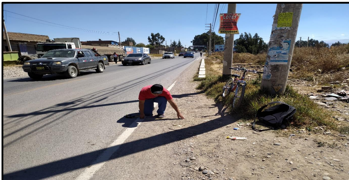
FOTOGRAFIA 9: Tomando la medida de los hombros de la intersección Las Americas y San Martin
