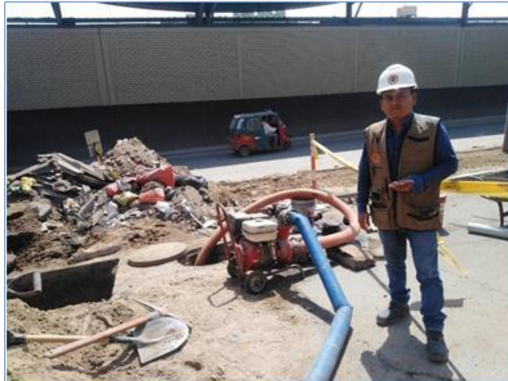
Gráfico N° 07. Desvió de aguas servidas incl. bombeo y alquiler p/caudales
